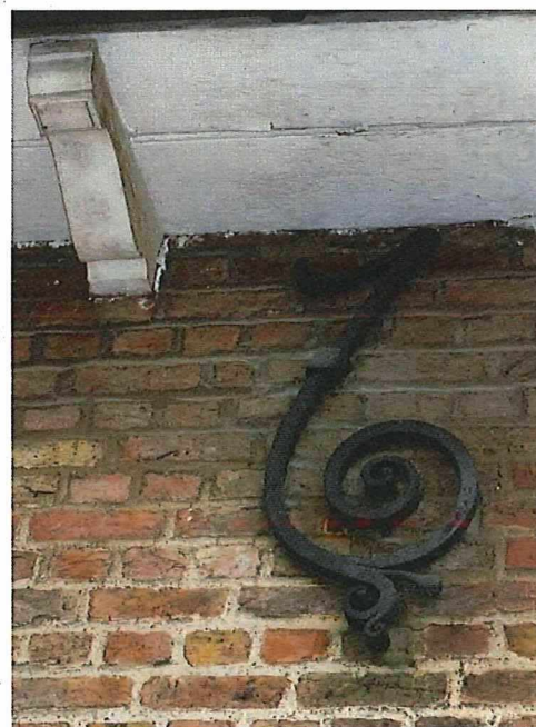
Foto 7 : voorgevel (uitkragend dak op modillons en sieranker)
