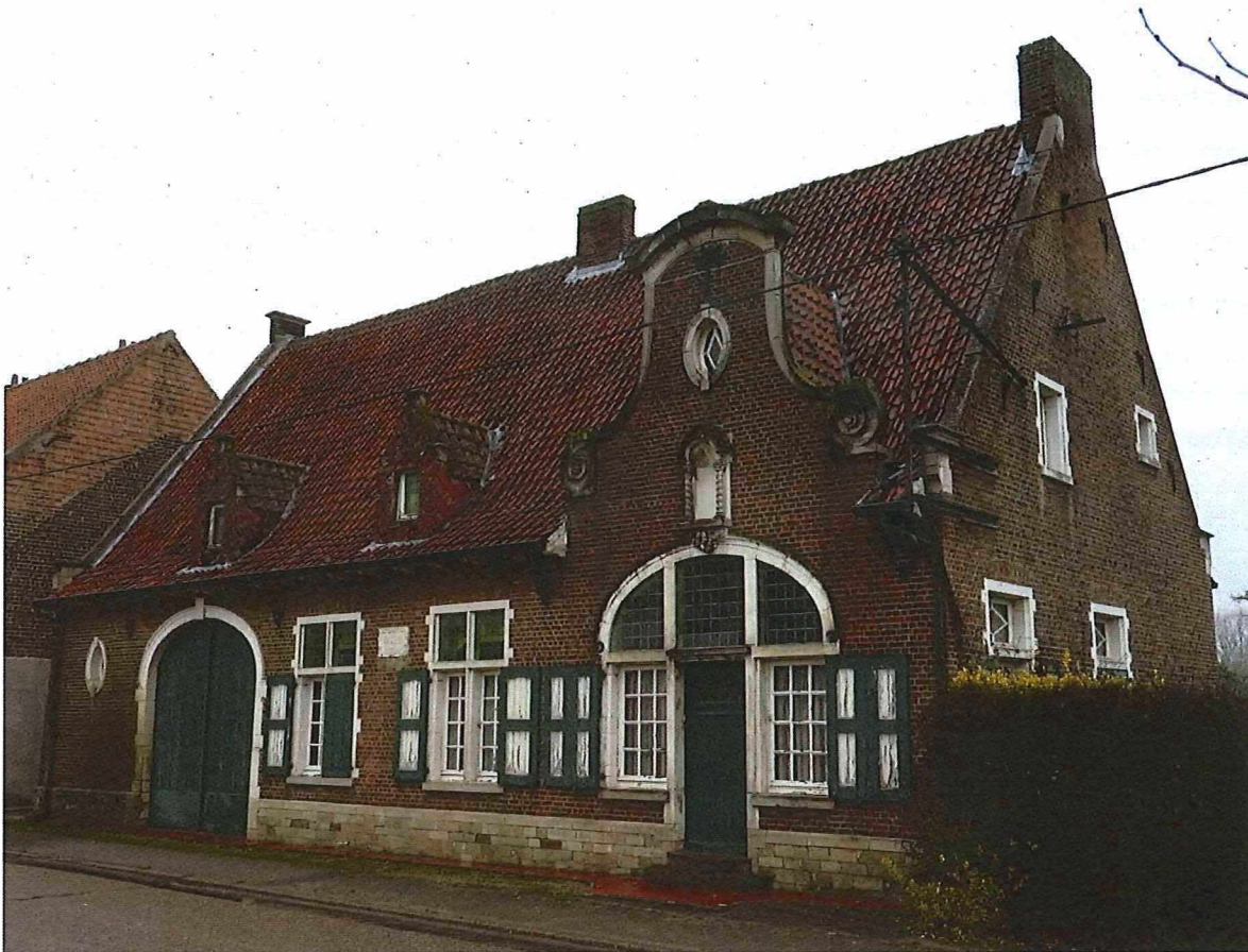
Foto 1 : voorgevel en oostgevel
