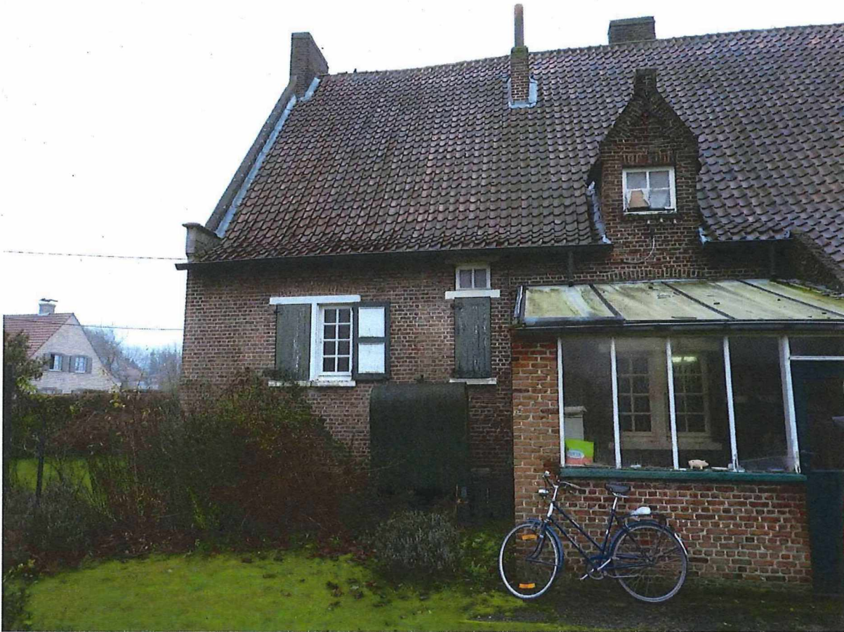
Foto 3 : achtergevel (oostelijk deel)
