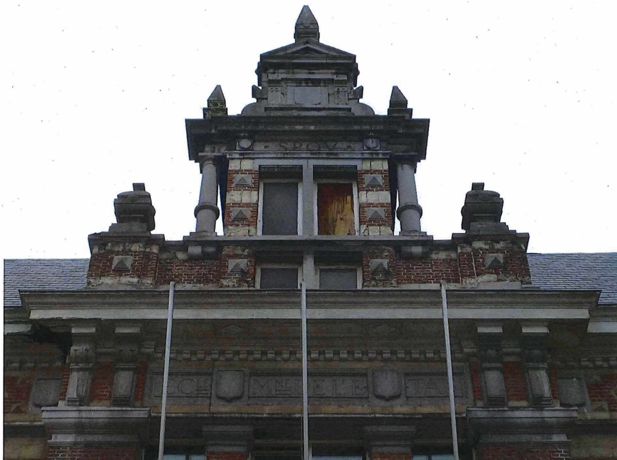
Foto 2: Topgevel van de centrale poorttravee
