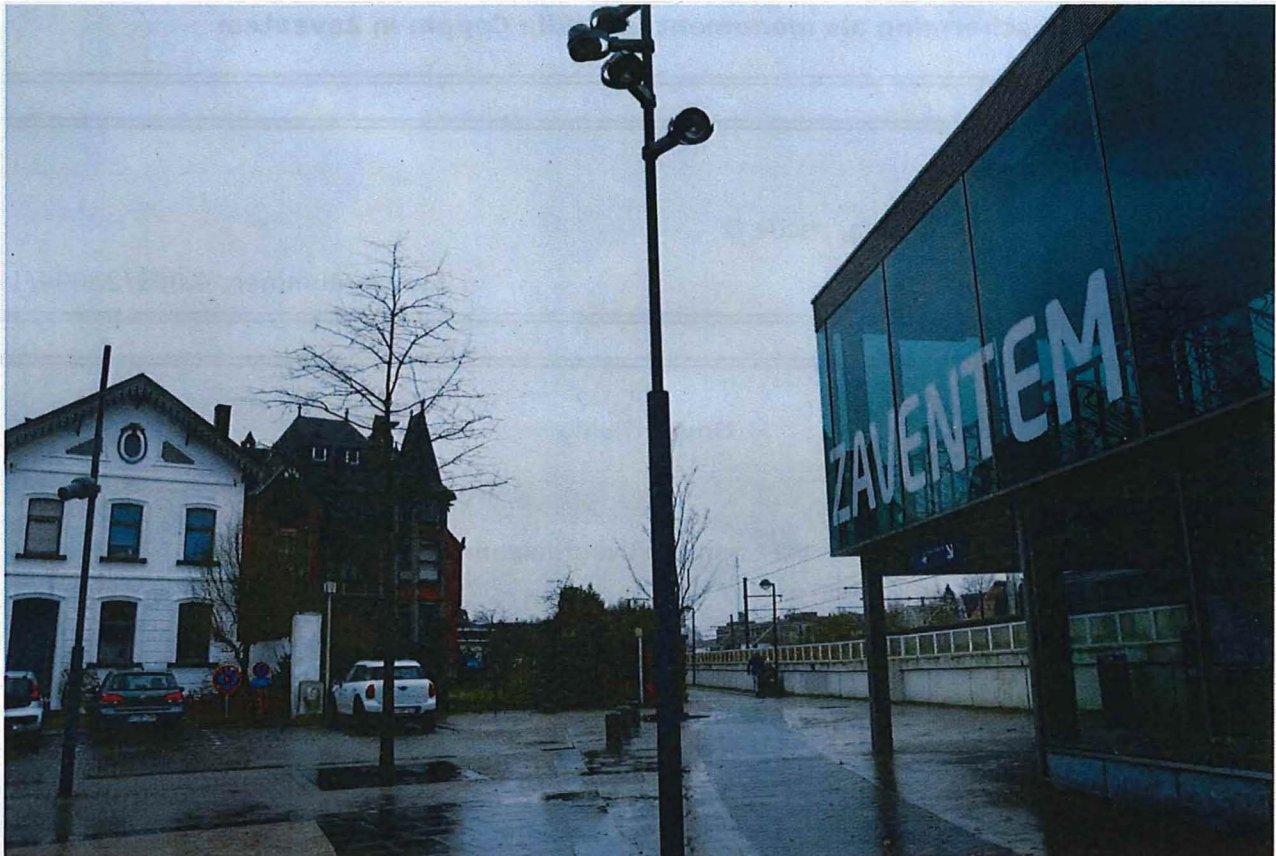
Foto 1: Situering van de Villa Coppin in zijn ruimtelijke context aan het Karel Quitmannplein, met rechts het spoorwegstation van Zaventem (22/02/2017).
