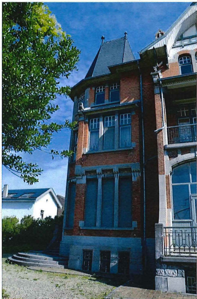
Foto 15: Zuidelijke zijgevel, eerste travee (18/07/2017).
