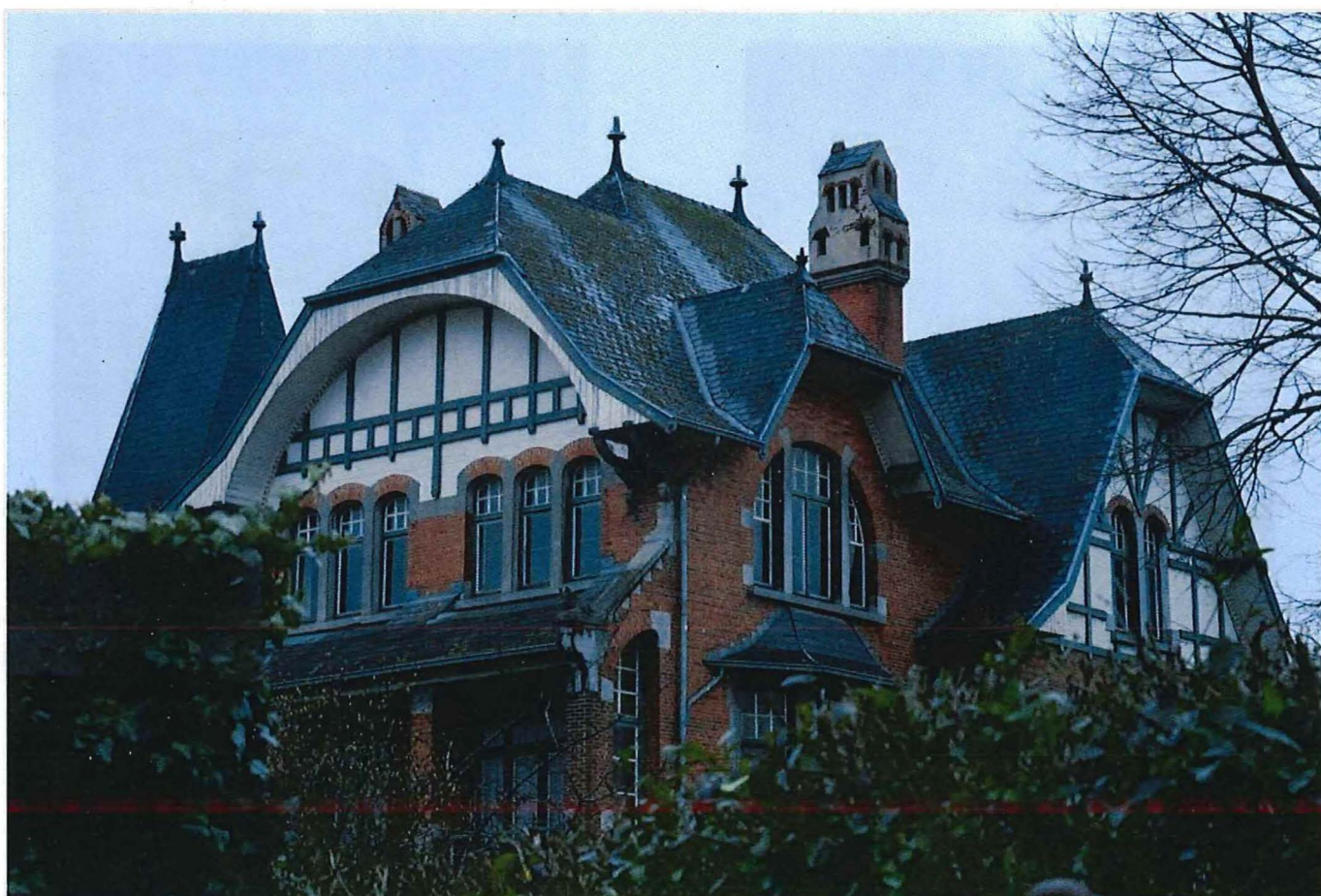
Foto 41: Zicht op de complexe dakstructuur van de villa, gezien vanuit het zuidoosten (22/02/2017).
