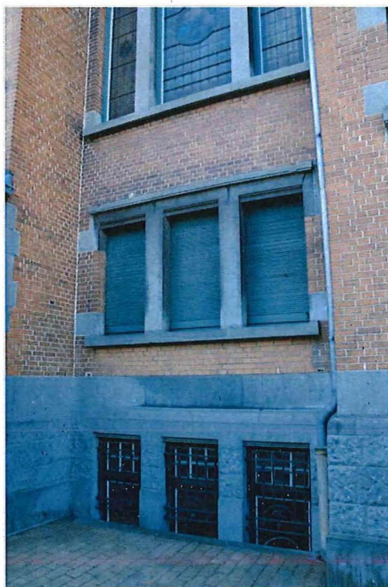
Foto 37: Noordelijke zijgevel, centrale travee (18/07/2017).
