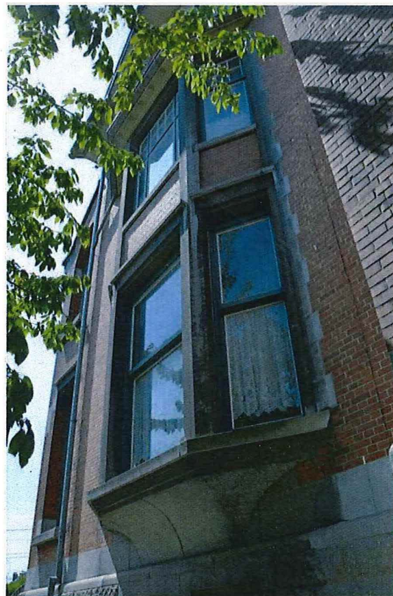
Foto 29: Achtergevel, zicht op eerste travee met erkeruitbouw (18/07/2017).
