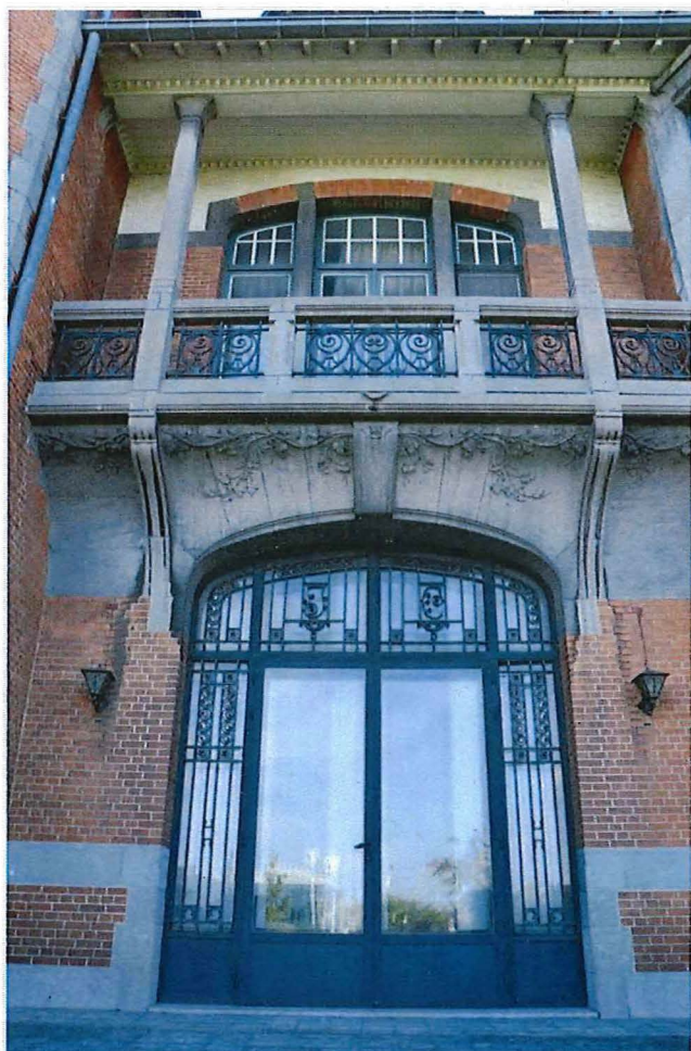
Foto 11: Voorgevel, hoofdingang met bekronende loggia (18/07/2017).
