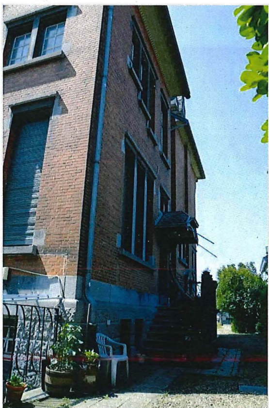
Foto 33: Noordelijke zijgevel, gezien vanaf het oosten (18/07/2017).
