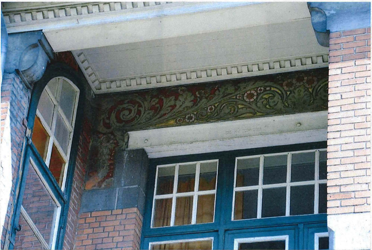
Foto 23: Zuidelijke zijgevel, detail. Zicht op het sgraffitopaneel en de metalen lateien boven de vensterdeuren van de loggia. Een zijlicht (links) en de originele plafondafwerking van de loggia (boven) (18/07/2017).
