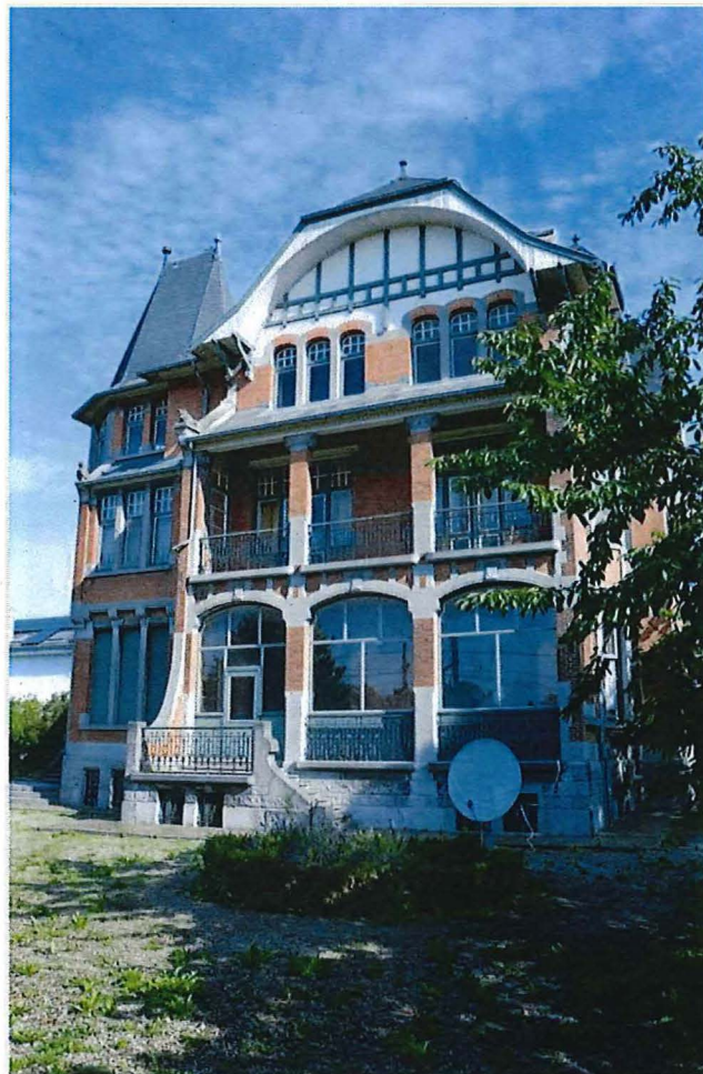
Foto 16: Zuidelijke zijgevel en tuin, met zicht op de wintertuin en bovenliggende loggia (18/07/2017).
