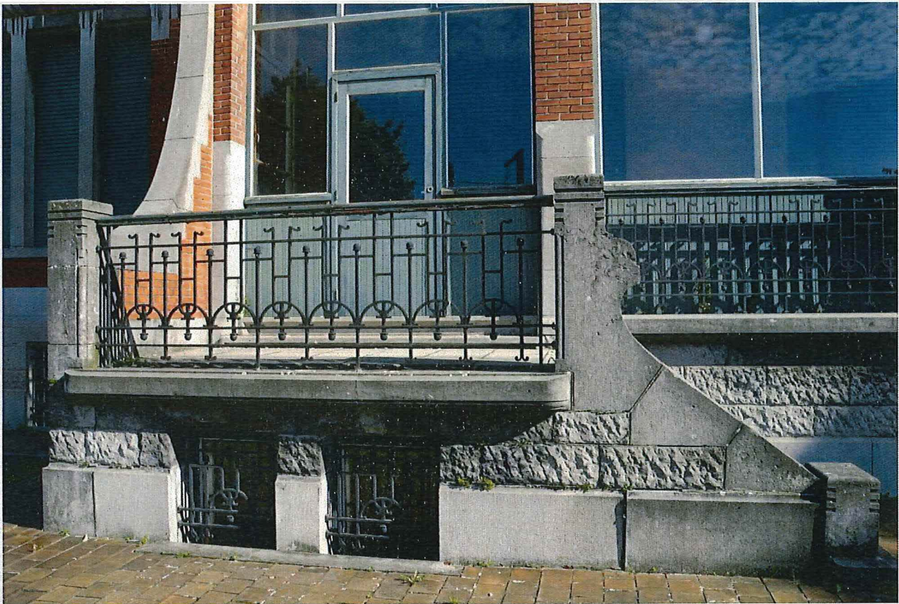
Foto 18: Zuidelijke zijgevel, buitentrap naar de wintertuin (18/07/2017).
