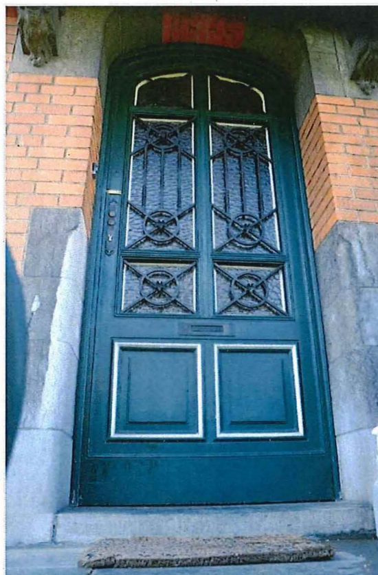
Foto 36: Noordelijke zijgevel, detail. Zicht op de toegangsdeur (18/07/2017).
