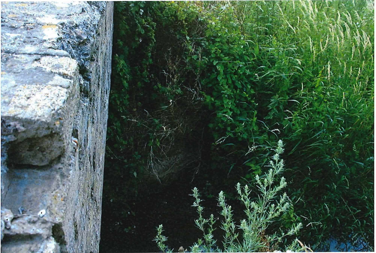
Foto 7: De zuidoostelijke vleugelwand.
