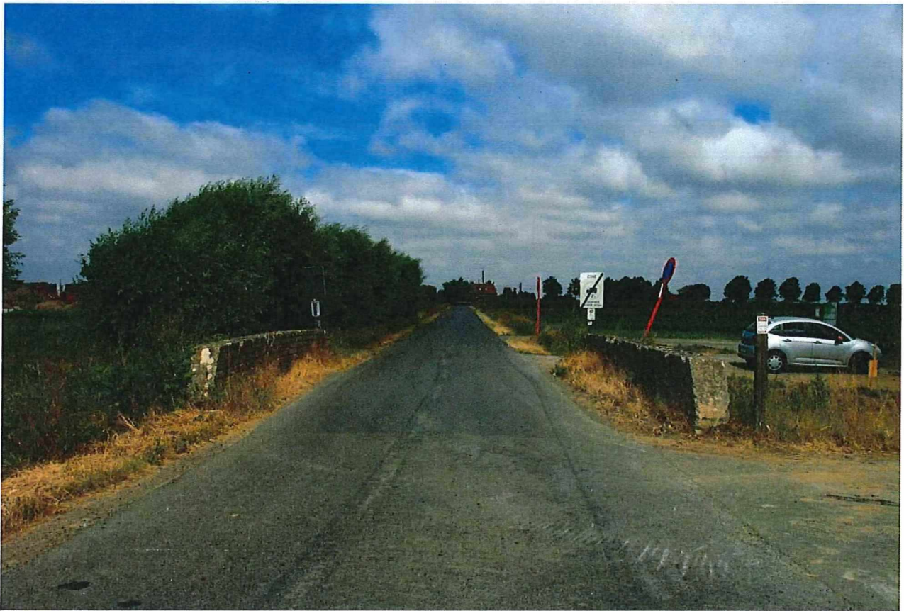
Foto 1: De brug over de Kemmelbeek. Zicht vanuit zuidoostelijk standpunt in de richting van het gehucht Hallebast.
