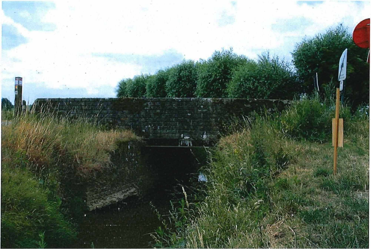
Foto 3: Zicht op de brug, vanuit noordoostelijk standpunt.
