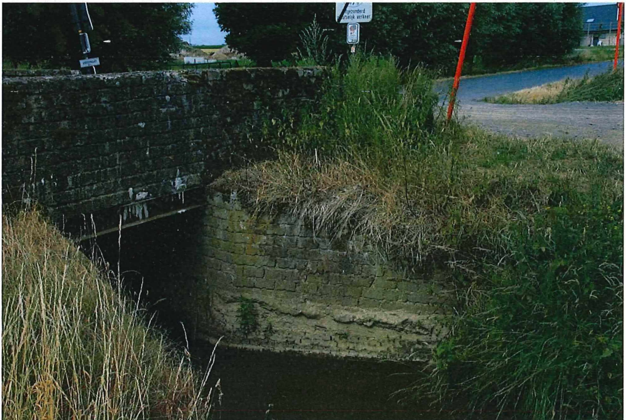
Foto 4: Zicht op de noordoostelijke borstwering en vleugelwand.
