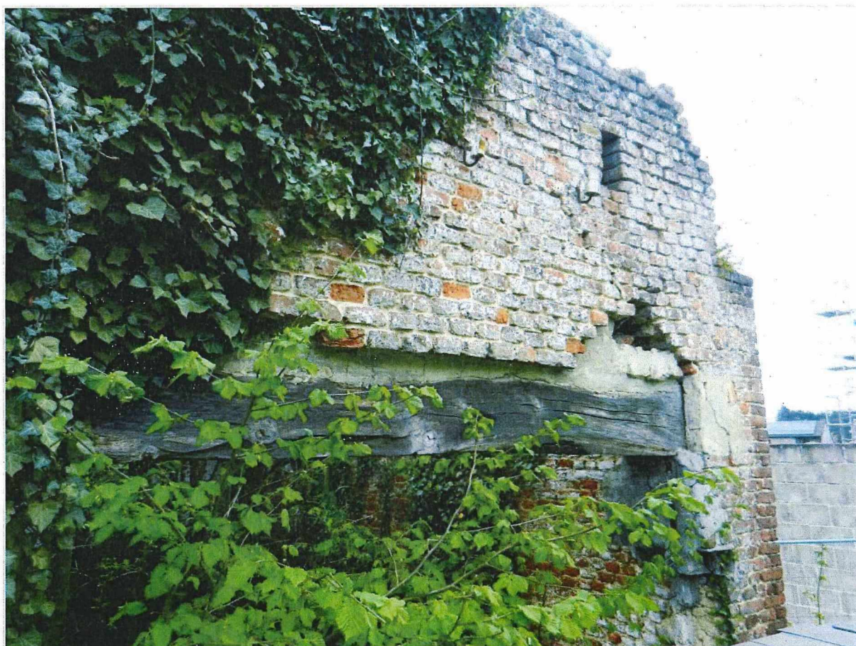
Foto 11: erfzijde van het poortgebouw, met doorbreking (wagenhuis?) onder houten latei.
