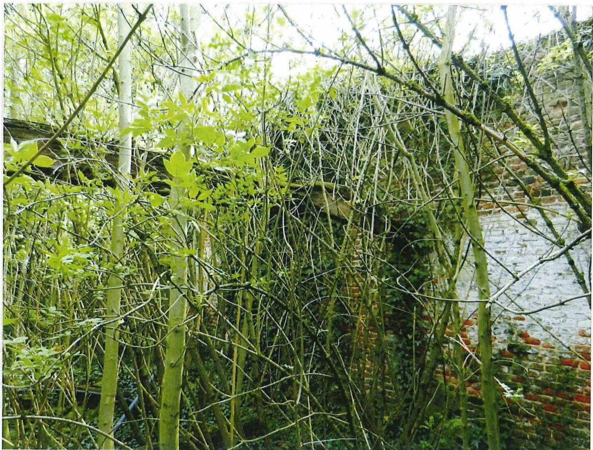
Foto 13: binnenzicht in het poortgebouw, met moerbalk.
