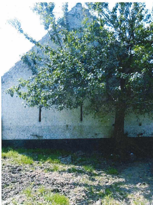
Foto 23. De zijgevel (oostgevel) van de stalling is opengewerkt door lichtgleuven. Foto 24. Detail van de muuropeningen in de noordgevel (17.08.2016).
