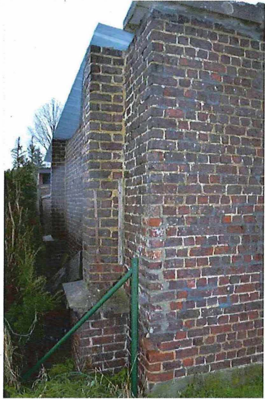
Foto 16: Detail schoolmuur aan de zuidwestelijke hoek (13/12/2017).
