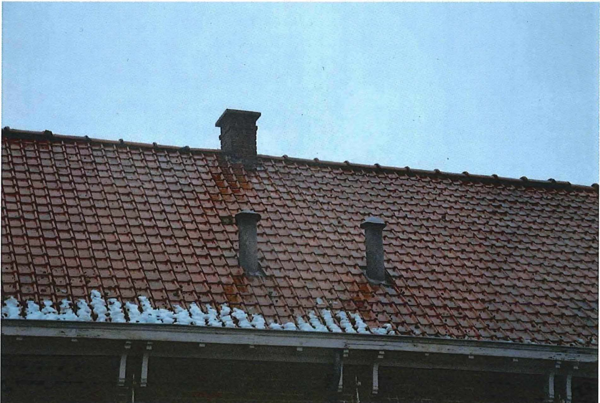
Foto 10: Verluchtingschachten met regenhoed ter bediening van het ventilatiesysteem van de klassen (13/12/2018).
