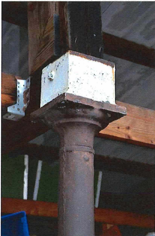
Foto 21: Overdekte speelplaats, detail kapiteel gietijzeren zuil (13/12/2017).
