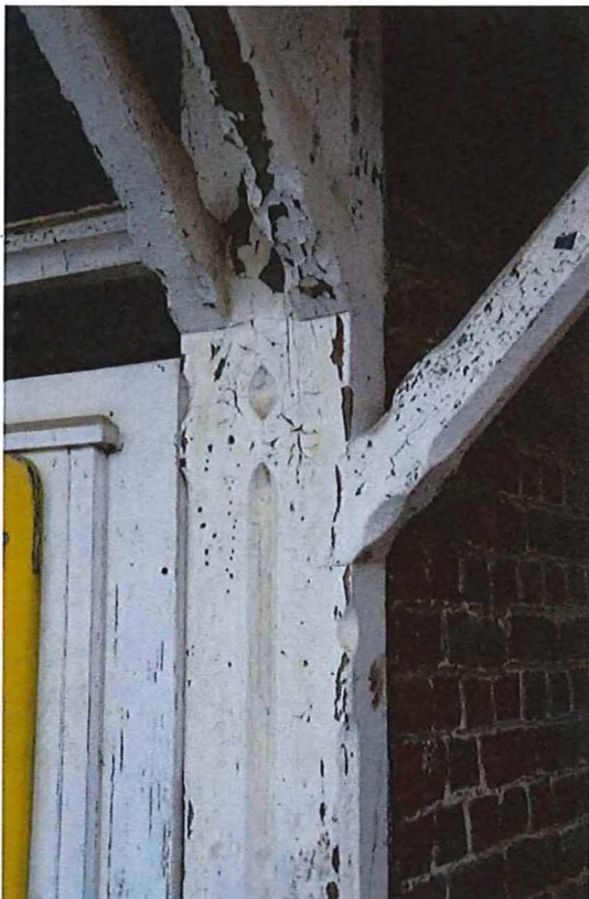
Foto 29: Sanitaire blok, detail korbelen van de dakoversteek (13/12/2017).
