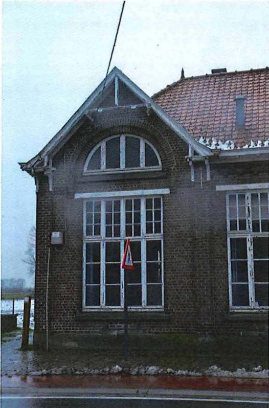
Foto 5: Puntgevel met geprononceerde dakoversteek en piron ter hoogte van de nok (13/12/2017).
