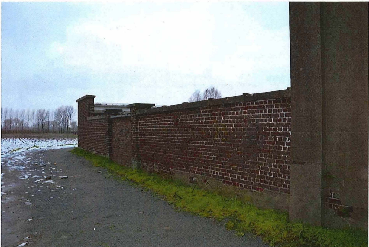
Foto 14: Schoolmuur met gecementeerde plint en toegangspoort tussen pijlers. Deze laatste werd dichtgemetseld (13/12/2017).
