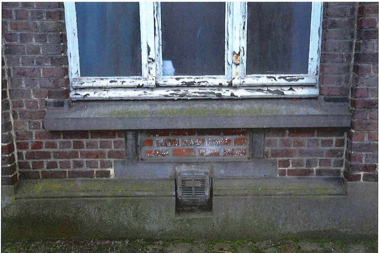
Foto 7: Detail drieledig raam voorgevel. Onder de hardstenen dorpel bevindt zich de omlijsting van de ventilatiegrouters. Deze openingen werden dichtgemetseld. Onderin steekt een nieuw ventilatiemechanisme (13/12/2017).
