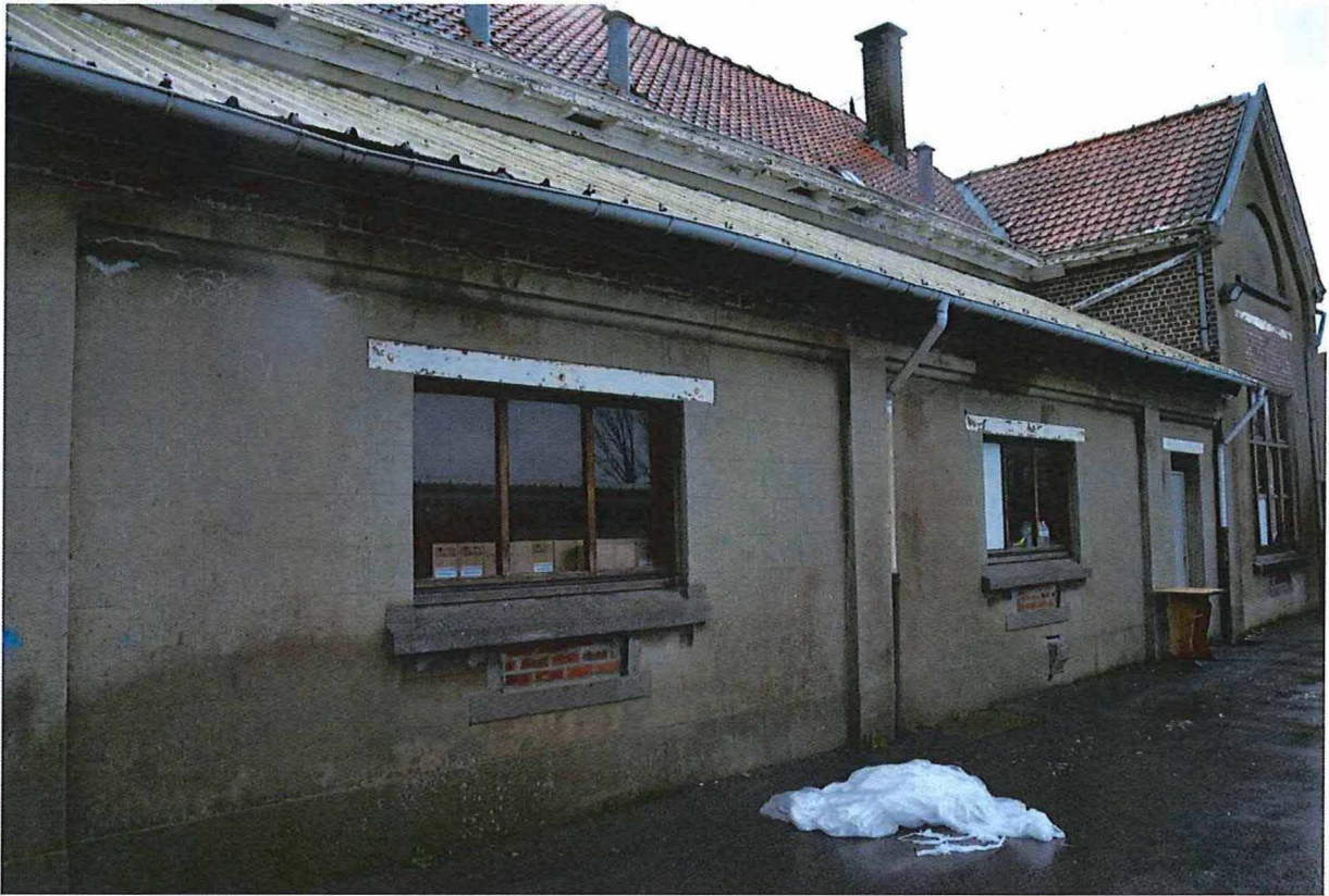
Foto 18: Achtergevel gemeenteschool, volume van de gang (13/12/2017).
