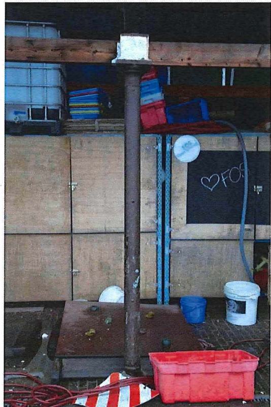
Foto 22: Overdekte speelplaats, gietijzeren zuil (13/12/2017).
