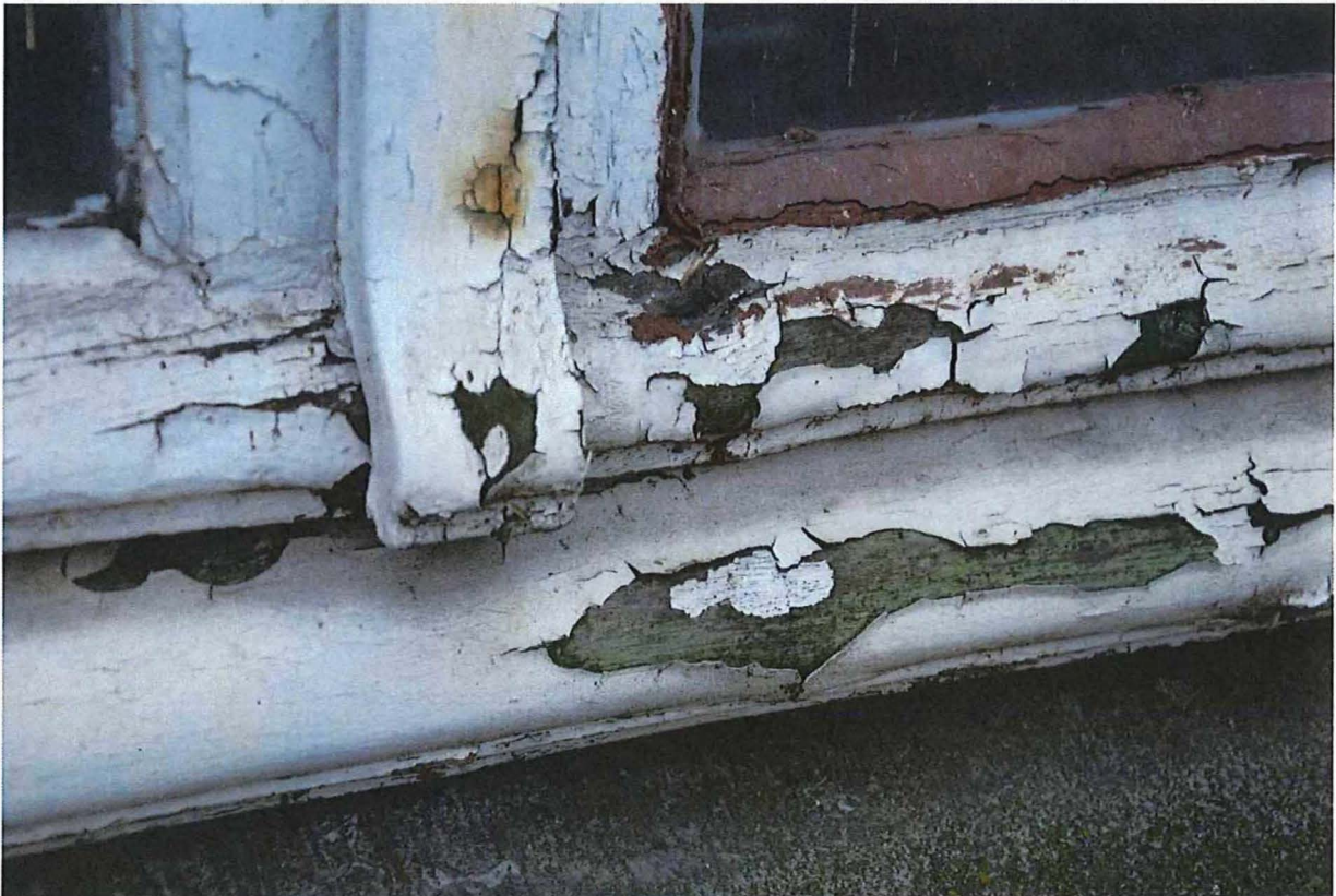
Foto 12: Detail schrijnwerk rechthoekige raampartijen voorgevel. Onder de huidige verflaag bevindt zich de oorspronkelijke groene afwerkingslaag van het schrijnwerk (13/12/2018).
