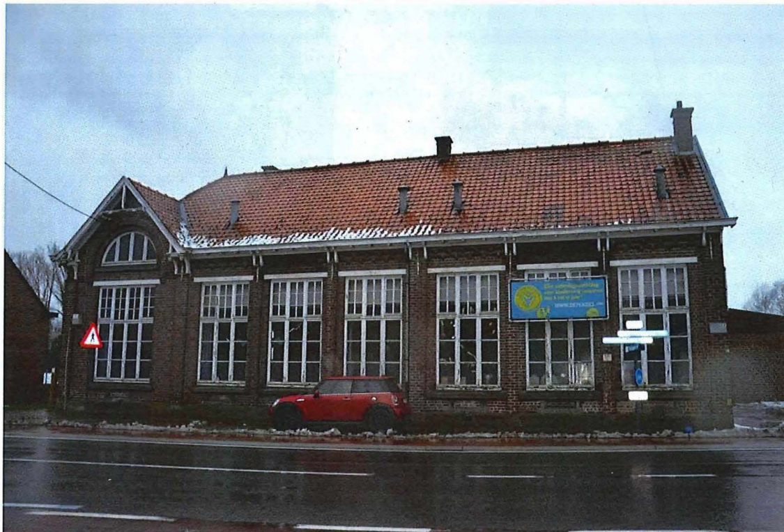
Foto 3: Voorgevel gemeenteschool Nederzwalm, zicht vanuit het oosten (13/12/2017).
