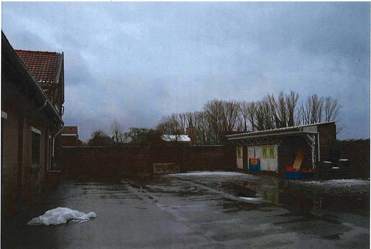
Foto 24: Zicht op de speelkoer en de zuidelijke schoolmuur met toegangspoort (13/12/2017).
