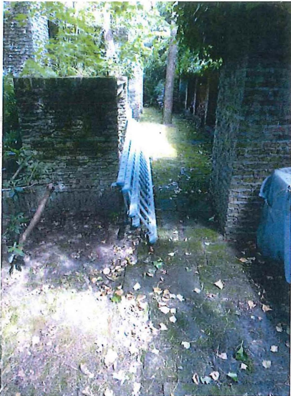
Foto 32: Tuinpad zuiden met houtopslag
