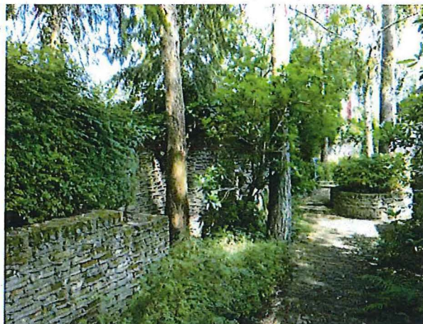
Foto 24: Detail van de noordelijke tuinmuur
