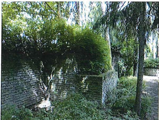
Foto 23: Detail van de noordelijke tuinmuur
