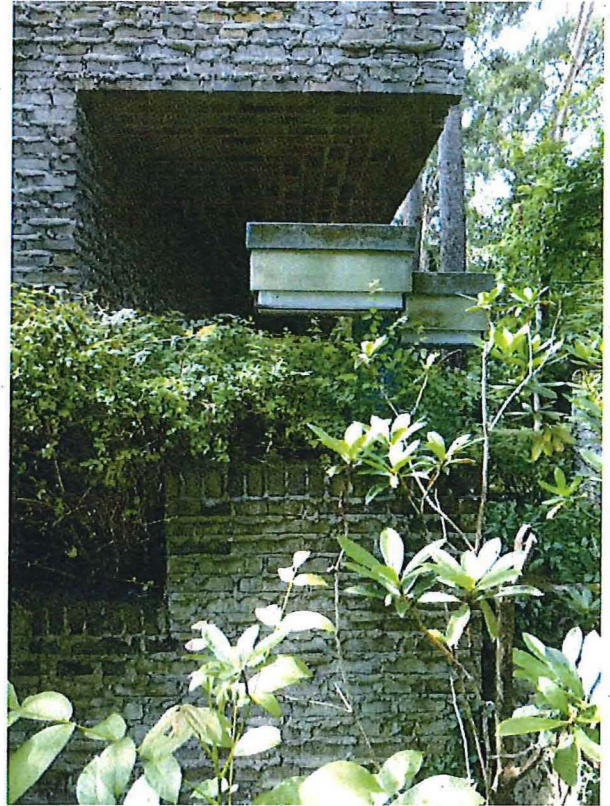
Foto 29: Oostgevel detail met verlichtingselement
