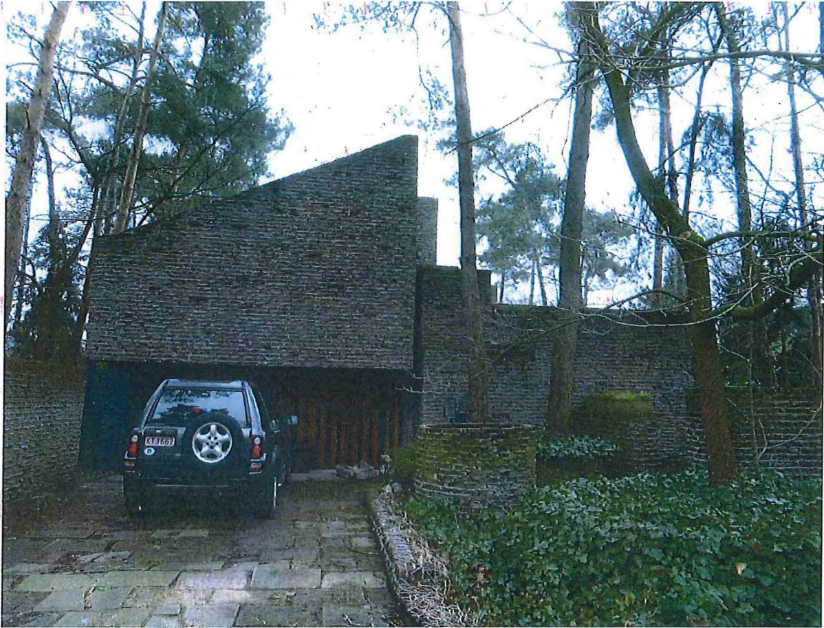
Foto 3: Westgevel met zicht op de oprit
