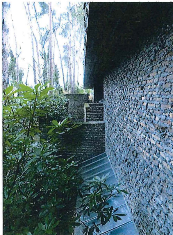
Foto 19: Detail noordgevel met kelderramen
