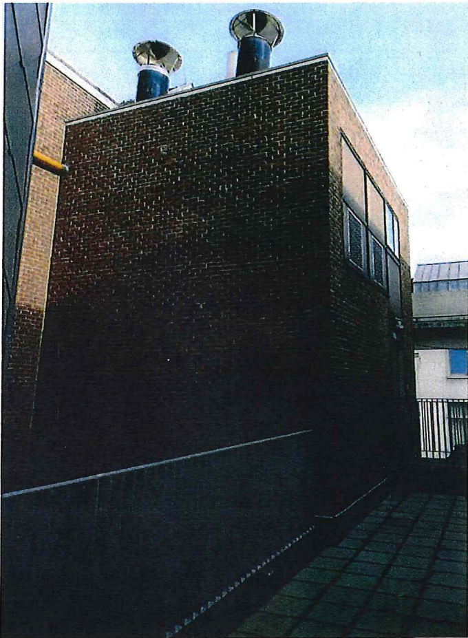
Foto 11: westelijk hoger bouwvolume
