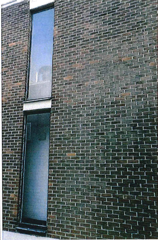
Foto 13: ramen in wetsgevel van oostelijk hoger bouwvolume
