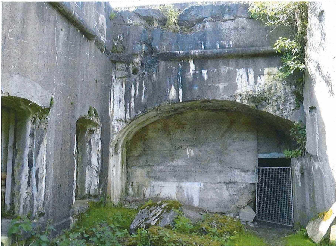
28. Linkerhoofdfrontgebouw, toegang naar de binnenkoer, in het ronde gat in de hoek van het gebouw boven de toegang zit een obuspunt, 22/05/2017.
