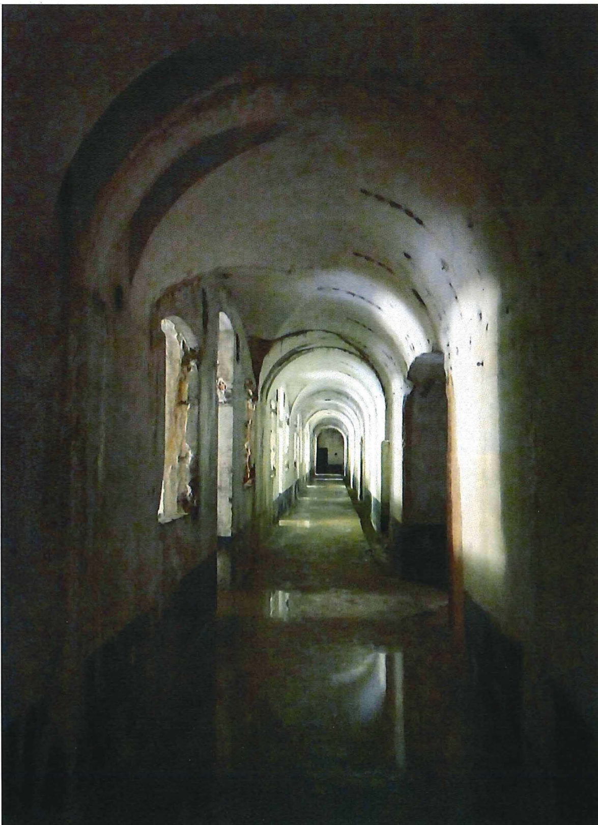
30. Hoofdfrontgebouw, linkergang met links de ramen die uitgeven op de verblijven van de troepen, 21/05/2016.
