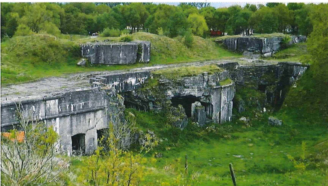
22. Hoofdfrontgebouw (boven) Linkerhoofdfrontgebouw met 12cm geschutkoepel en binnenkoer, (centraal) achterzijde van de 15cm geschutkoepel en zonnepanelen, (rechts) rechterhoofdfrontgebouw met oorlogsschade uit 1914, 21/05/2016.
