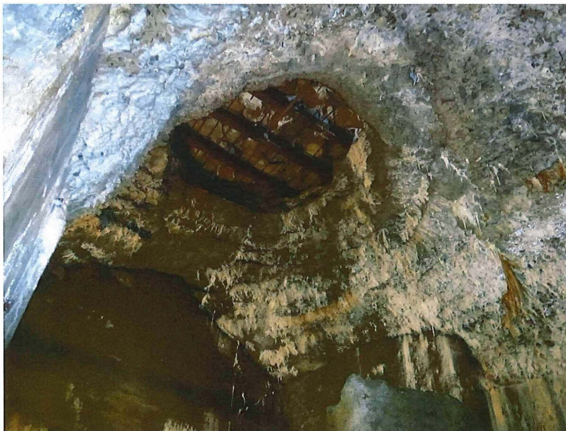
21. Hoofdfrontgebouw, kamer van de commandant: inslag waarbij het gewelf volledig werd doorboord. Sinds 1914 was deze ruimte dichtgemetseld en afgesloten. In 2014 groeven vrijwilligers de massa puin weg, 21/05/2016.
