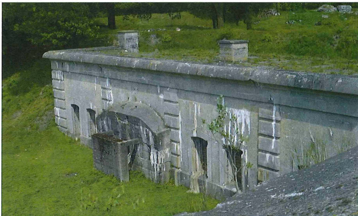
11. Zicht op het linkerkeelfrontgebouw, vanaf het dak van de traditorebatterij. Het muurtje centraal in de foto schermt de toiletten van de (onder)officieren tegen inkijk af. Boven op het dak zijn de ventilatieschachten zichtbaar, 21/05/2016.
