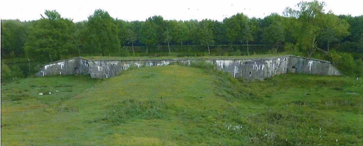
43. Caponnière met schietgaten, gaten voor 5,7cm snelvuurkanonnen en oreillon (schuinaflopemd). Centraal op de voorgrond bevindt zich de aangeaarde ondergrondse galerij naar de caponnière. In de achtergrond, achter de eerste bomenrij is het steile contrescarp zichtbaar, 21/05/2016.
