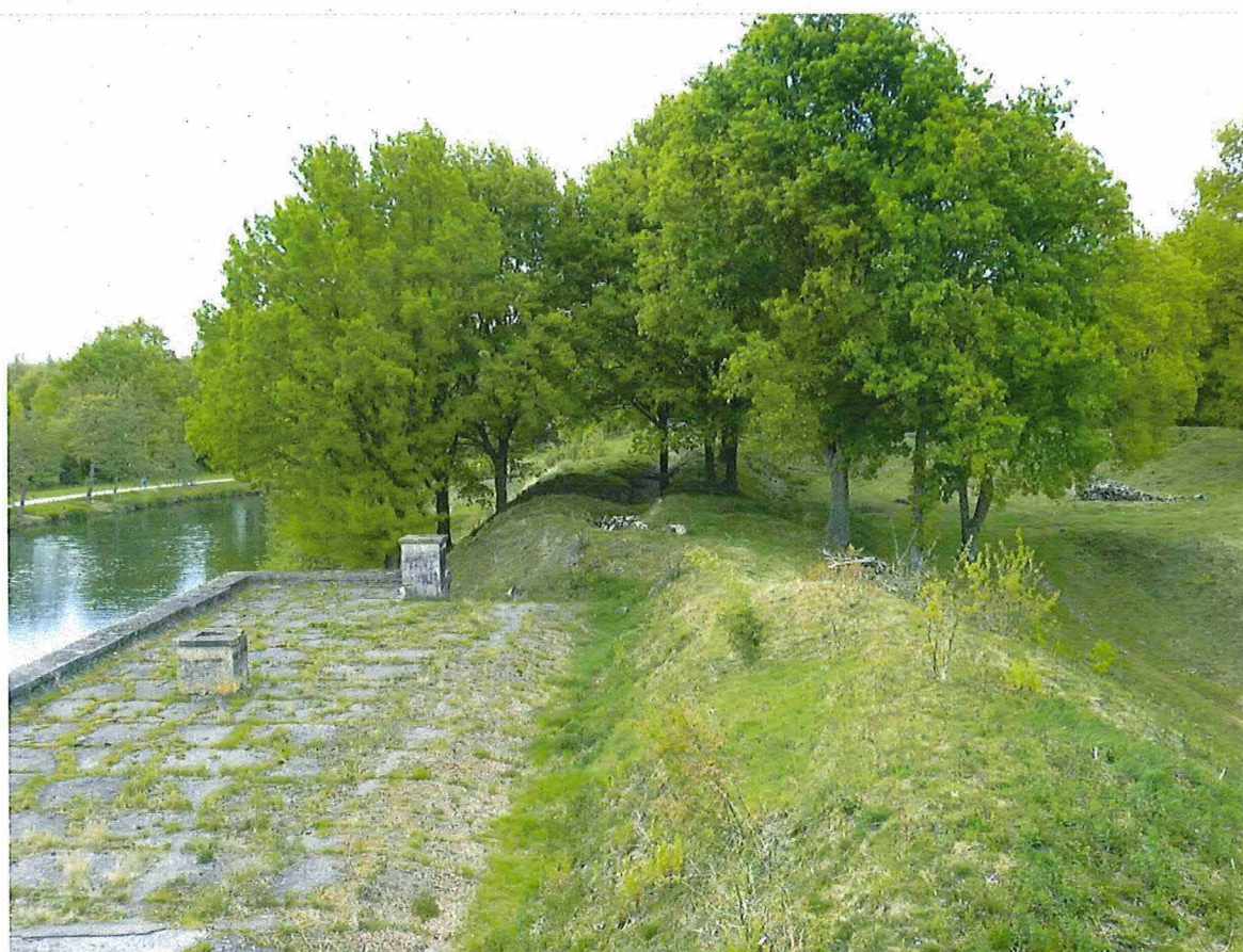
54. Loopgraven uit het interbellum ter hoogte van het keelfrontgebouw links, 12/05/2017.
