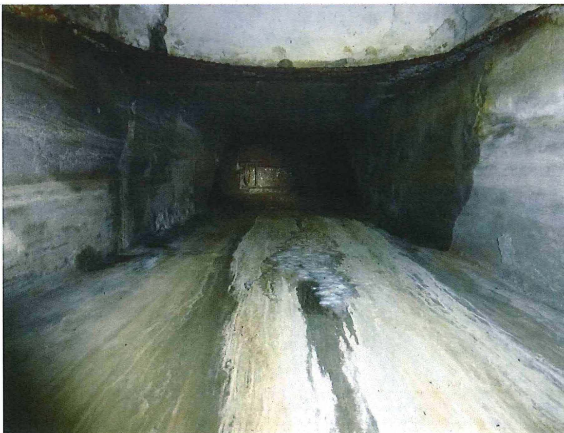
32. Geschutkoepels, interieur van de de centrale geschutkoepel: munitielift, 55/05/2017.
