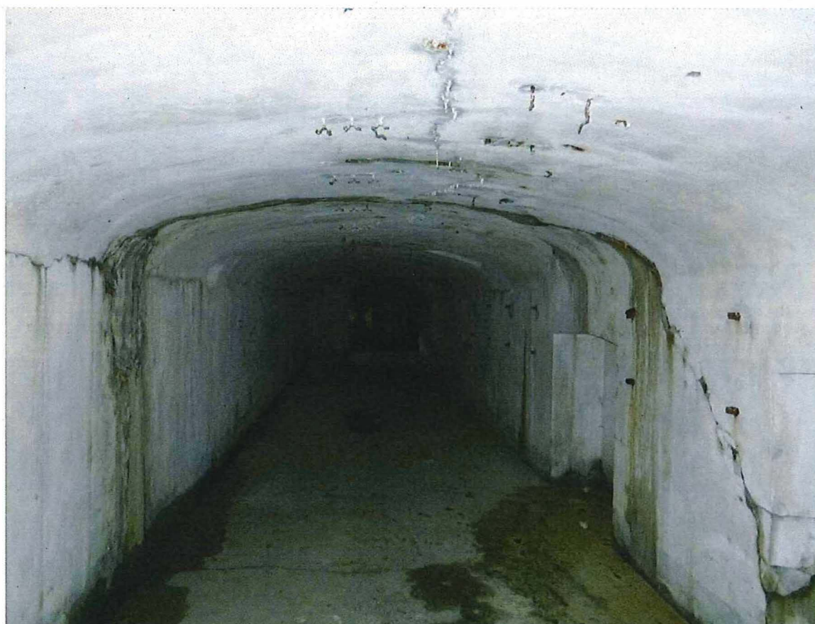
46. Caponnière interieur: corridor met verankeringen, dichtgemetste schietgaten, betonnen vloer en nissen voor muurkastjes, 22/05/2017.
