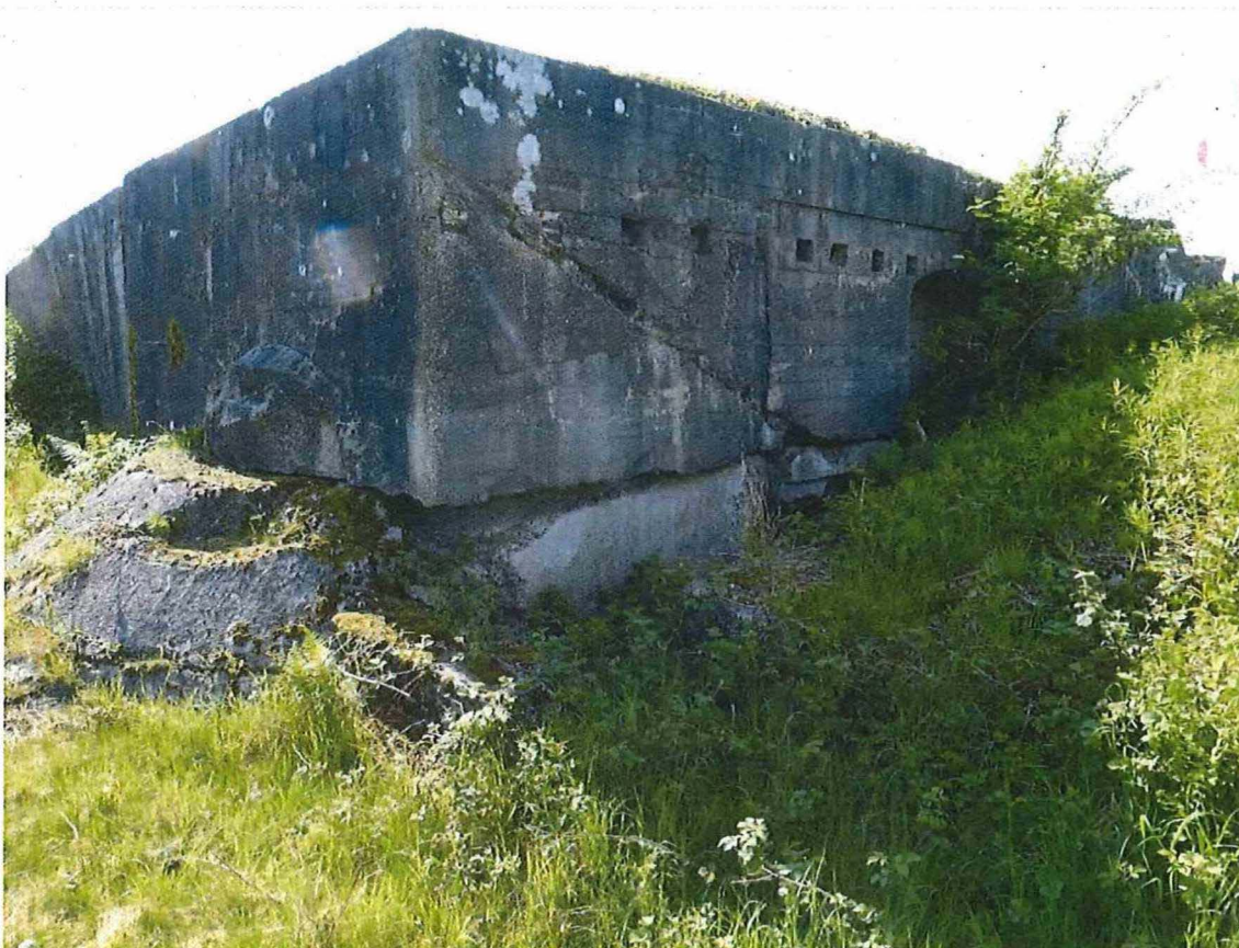
38. Saillant 3, achterzijde: let op de horizontale bouwnaad onderaan de saillant (gebarsten): het onderste gedeelte behoorde tot de bouwwerken van de privéfirma Bolsée, terwijl de geschutkoepel omwille van het strategische belang door de militairen werd aangelegd: 12/05/2017.
