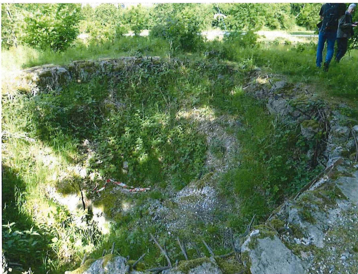
50. Saillant 1, bovenzijde: het gewapend beton op de rand van de koepel zijn de resten van de torenbunker die in het interbellum bovenop de geschutkoepel is aangelegd, 22/05/2017.
