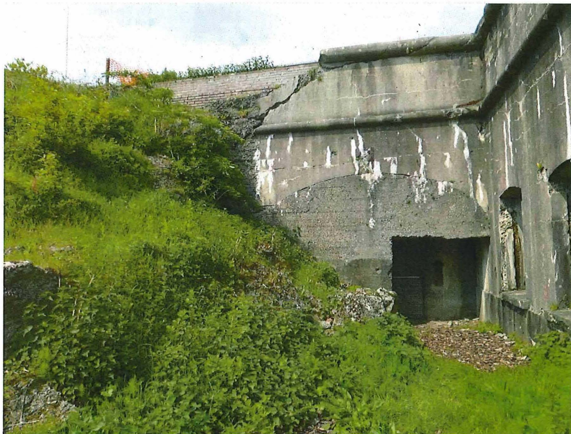
20. Centrale verbinding tussen het keelfront- en het hoofdfrontgebouw met zicht op het magazijn dat een inslag te verwerken kreeg. Een recent gemetsd muurtje sluit het dak af. Daarboven staan zonnepanelen geplaatst, 21/05/2016
