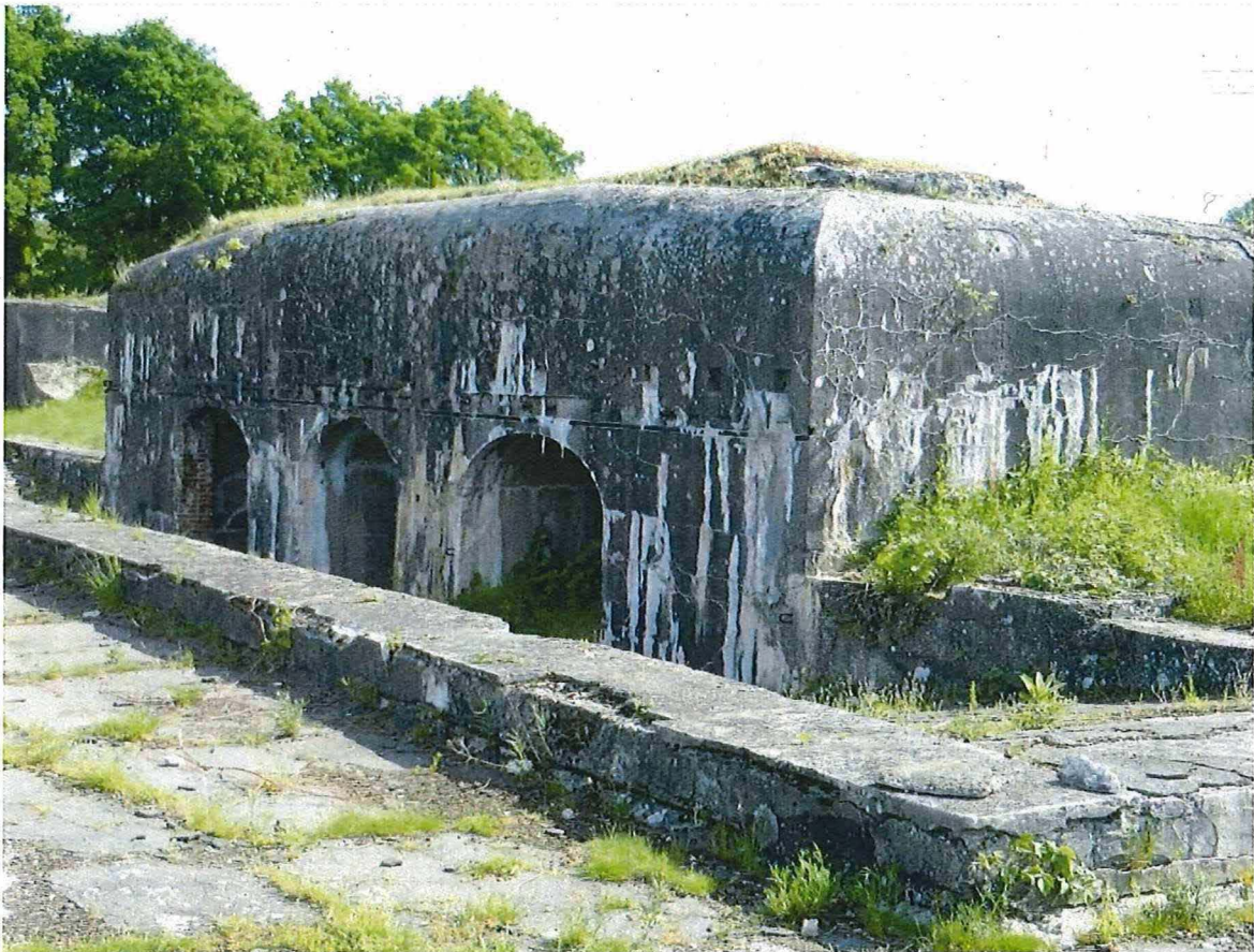
33. Centrale geschutskoepel, achterzijde: in de drie opening stond mobiele artillerie die boven op het fort kon worden geplaatst. Elke poort was afgedekt met een zijdelings verplaatsbare metalen schuifdeur, die intussen verwijderd is, 22/05/2017.
