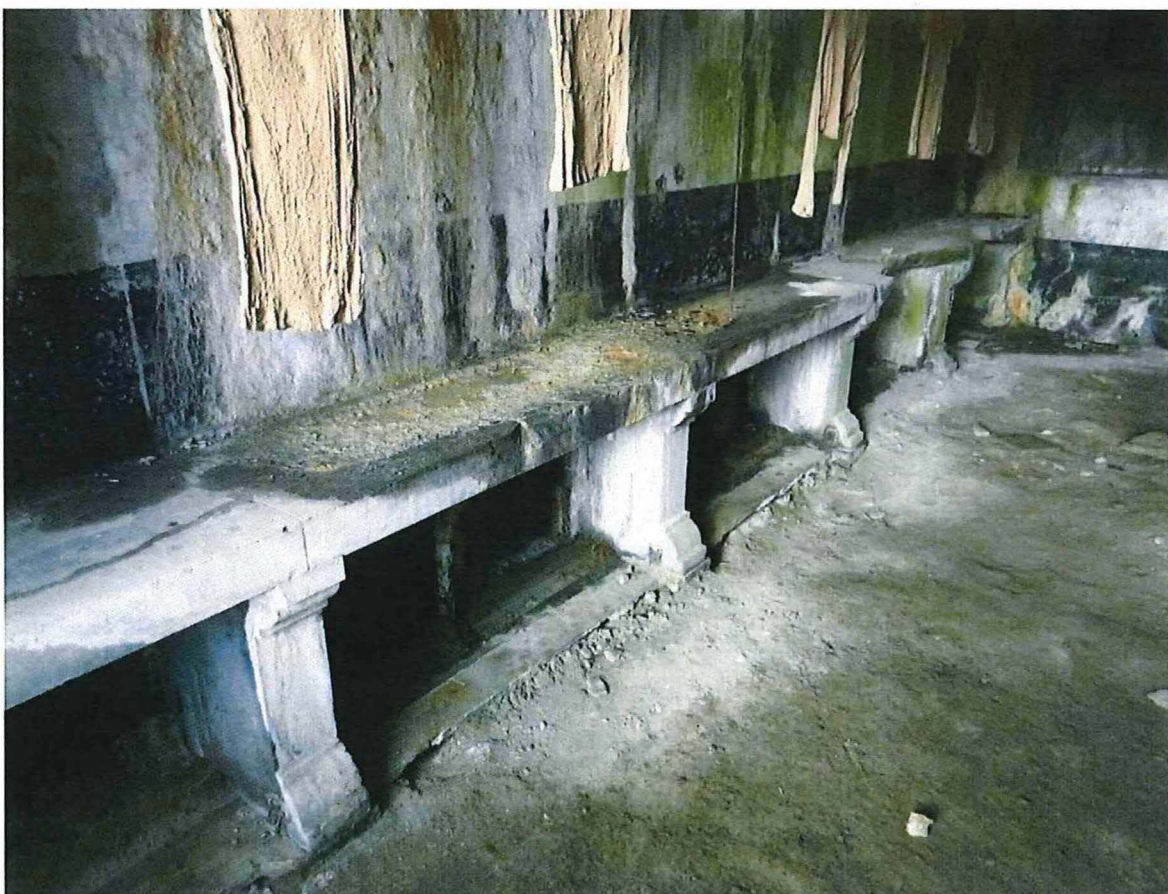
16. Keelfrontgebouw (links), interieur: wasplaats met originele arduinen wastafels, 12/05/2017.
