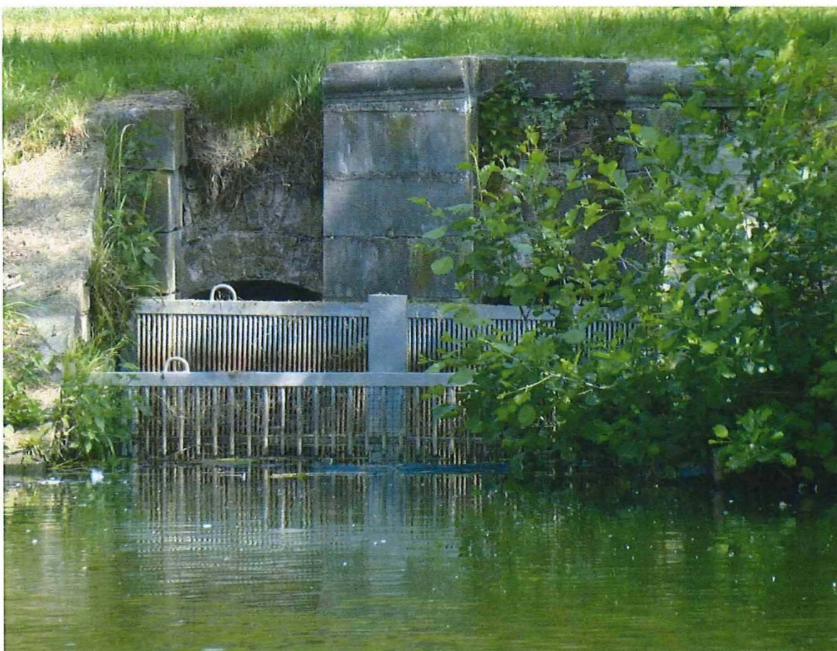
52. Sluis voor waterafvoer vanuit de vestinggracht naar de Elstbeek, 22/5/2017.
