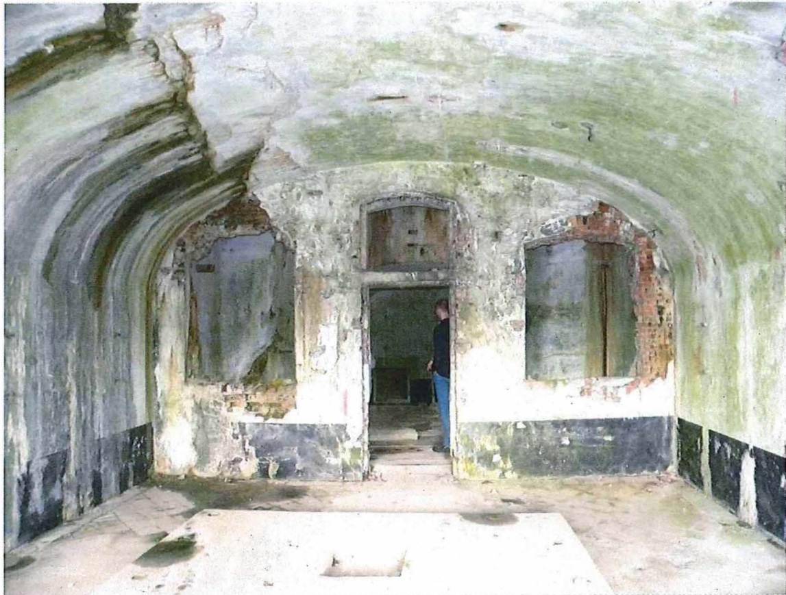
17. Keelfrontgebouw (links), interieur: douchekamer, met cementtegels, de douche-installatie en kranen zijn verwijderd, 22/5/2017.
