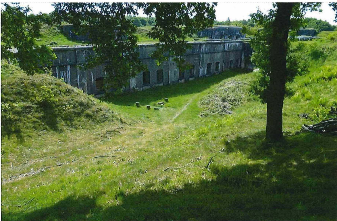
27. Linkerhoofdfrontgebouw met daarboven geschutkoepels en beneden de binnenkoer, 22/05/2017.
