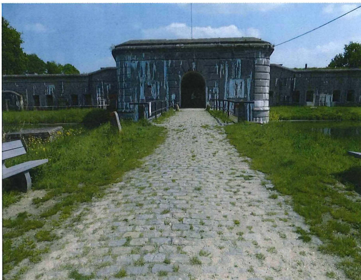
2. Brug, poort en traditorebatterij, toegang tot het fort van Kessel, 21/05/2016.
