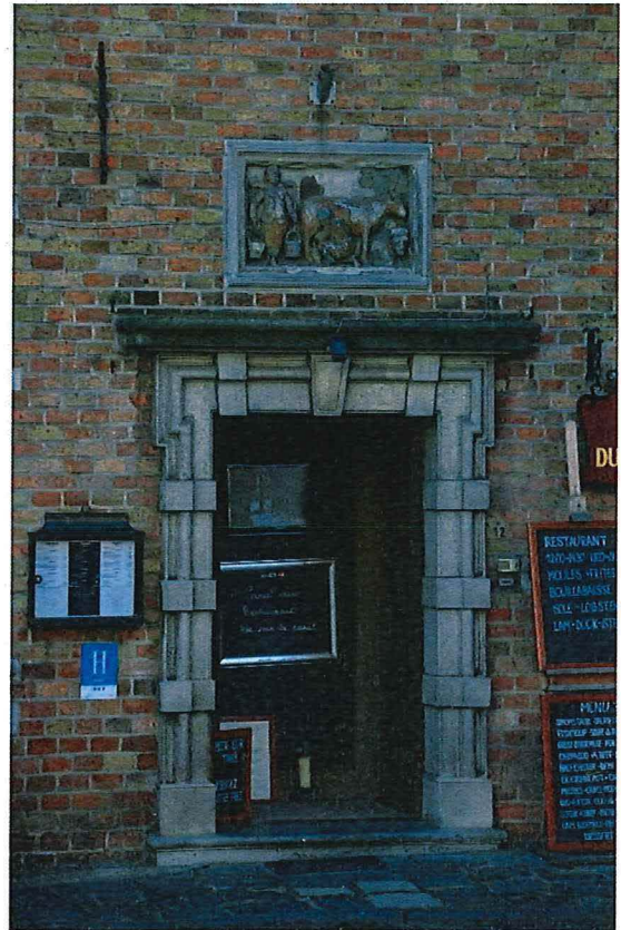
Foto 57: Huidenvettersplein nummer 12, detail deur
