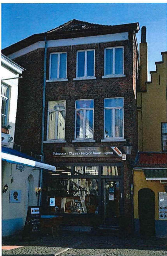
Foto 83: Braambergstraat nummer 5, achtergevel
