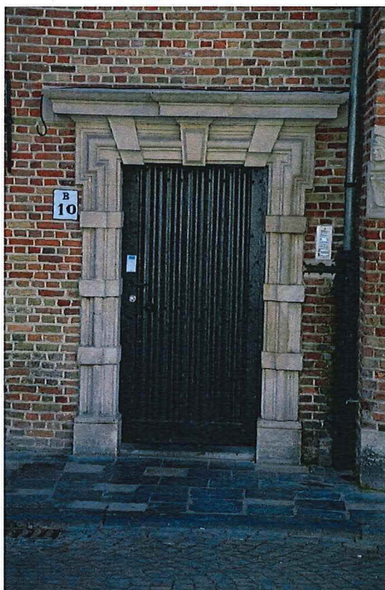
Foto 49: Huidenvettersplein nummer 10, detail deur in barokke omlijsting
