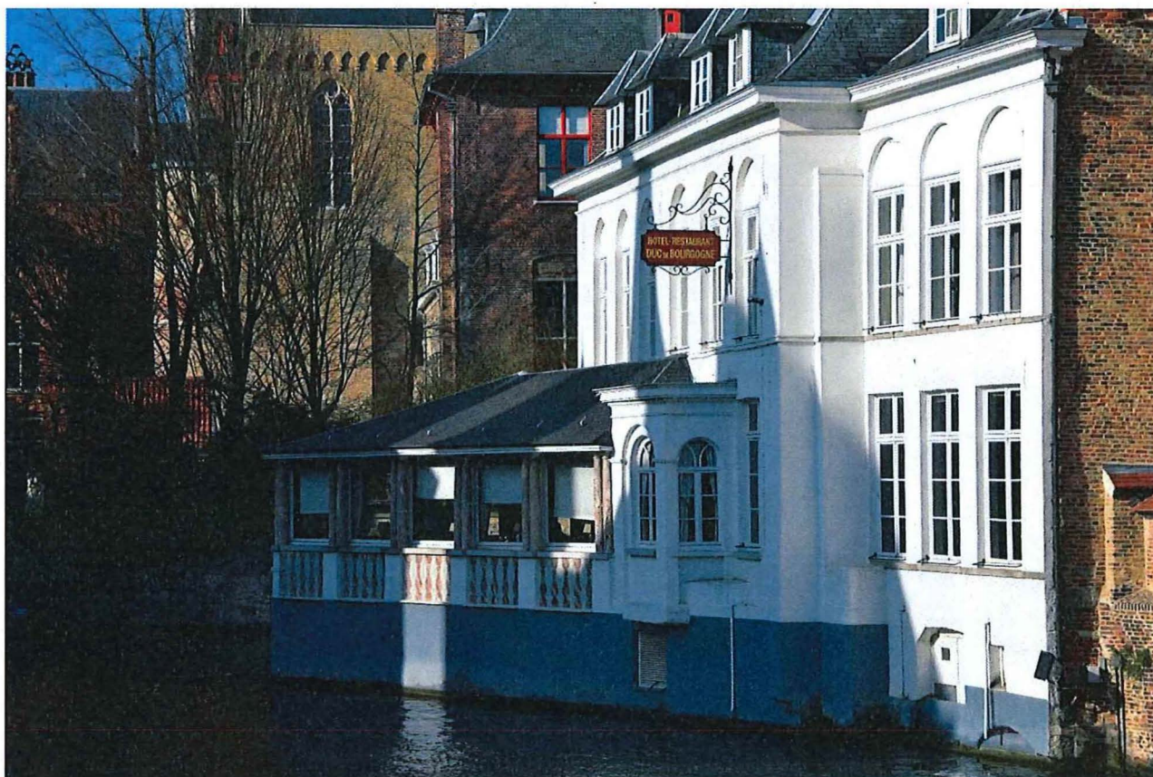
Foto 53: Huidenvettersplein nummer 12, gevel kant Rozenhoedkaai
