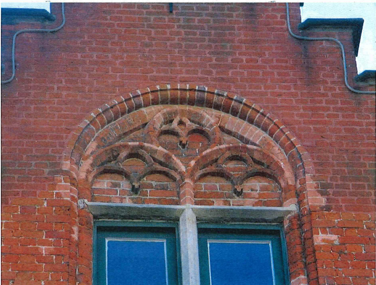
Foto 23: Vismarkt nummer 10, detail maaswerk
