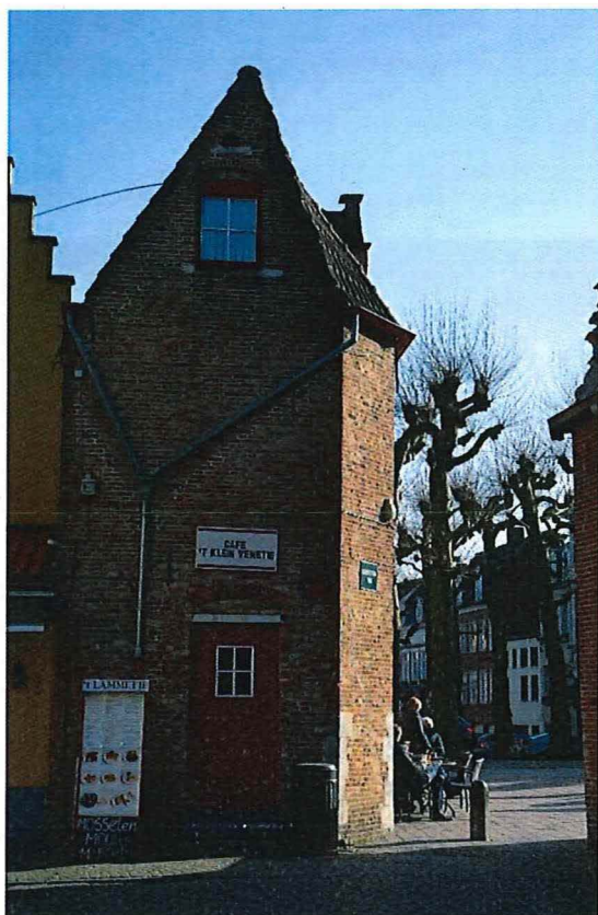
Foto 81: Braambergstraat nummer 1, achtergevel
