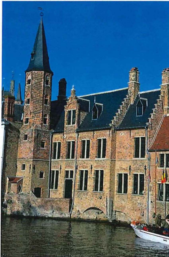
Foto 43: Huidenvettersplein nummer 10, Reiegevel
