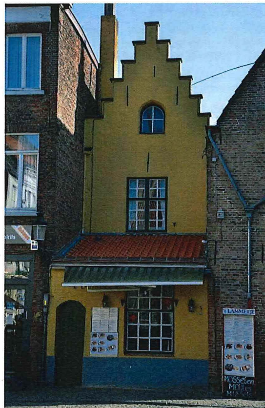
Foto 82: Braambergstraat nummer 3, achtergevel
