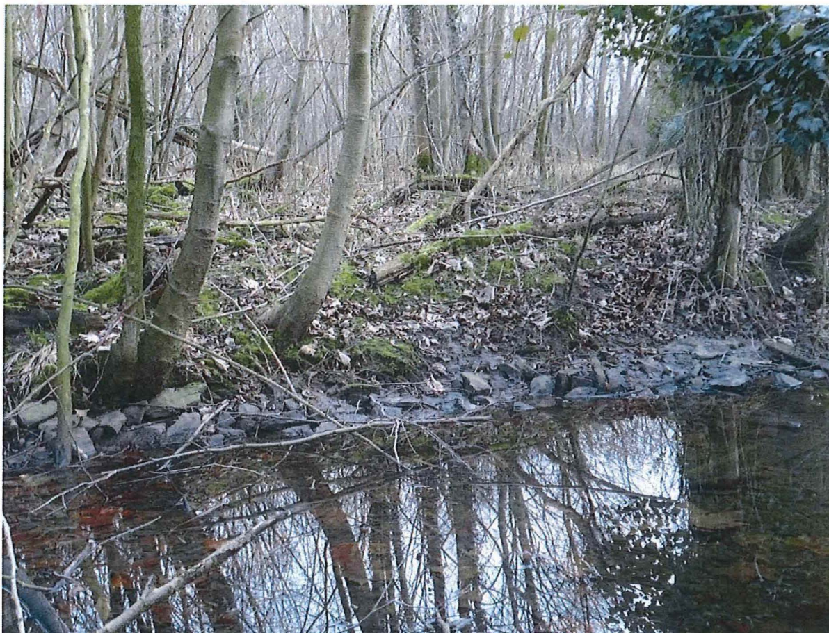
Foto 15: Fragmenten van steenbestorting bij relict van noordelijke vangpijp 1 op linkeroever (Weert)
