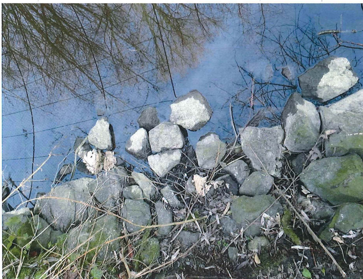
Foto 16: detail van steenbestorting bij zuidelijke vangpijp 3 op recheroever (Bornem)
