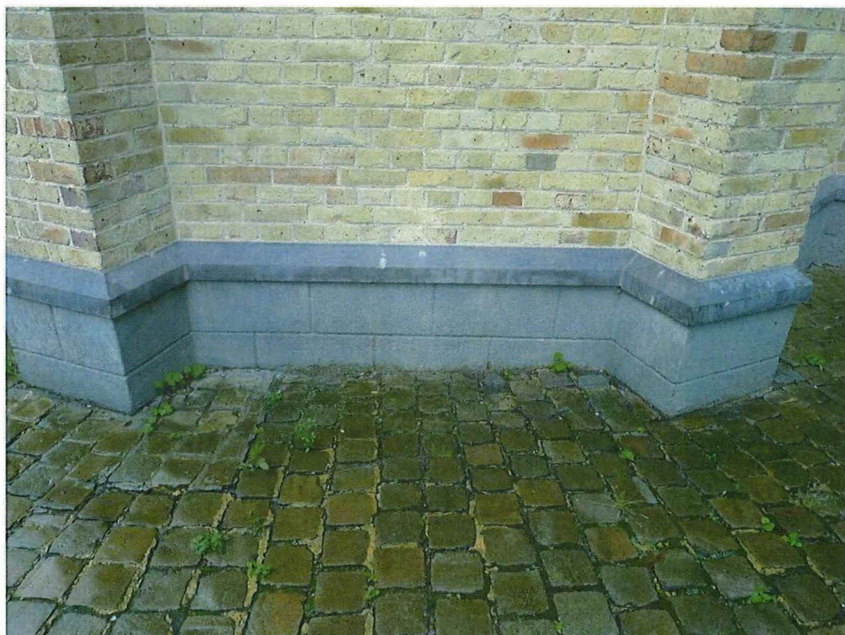
Foto 20: Sint-Jozefkapel – zuidelijke zijgevel - detail
