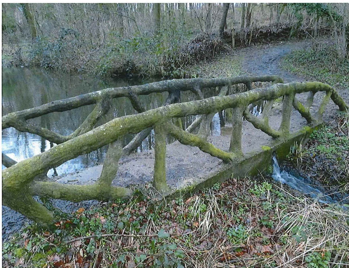
foto 40: cementrustiek sierbrugje met loopvlak uitgebouwd als stuw
