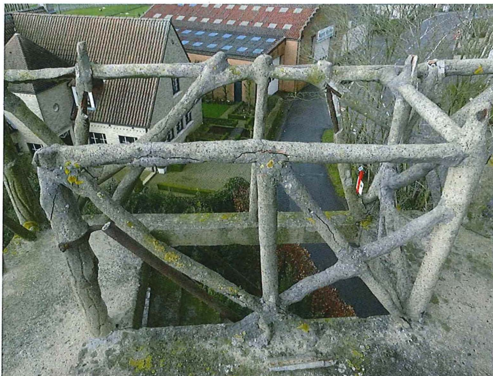
foto 69: borstwering in cementrustiek van het hoogste uitkijkplatform
