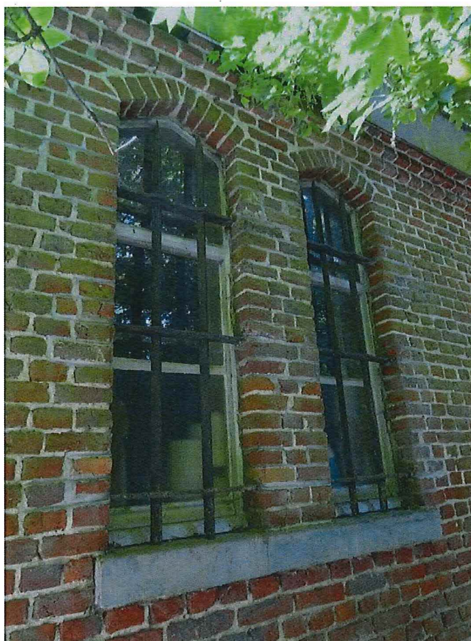
foto 20: de zijgevel van de sacristie is opengewerkt door getraliede, mijterboogvormige raampjes
