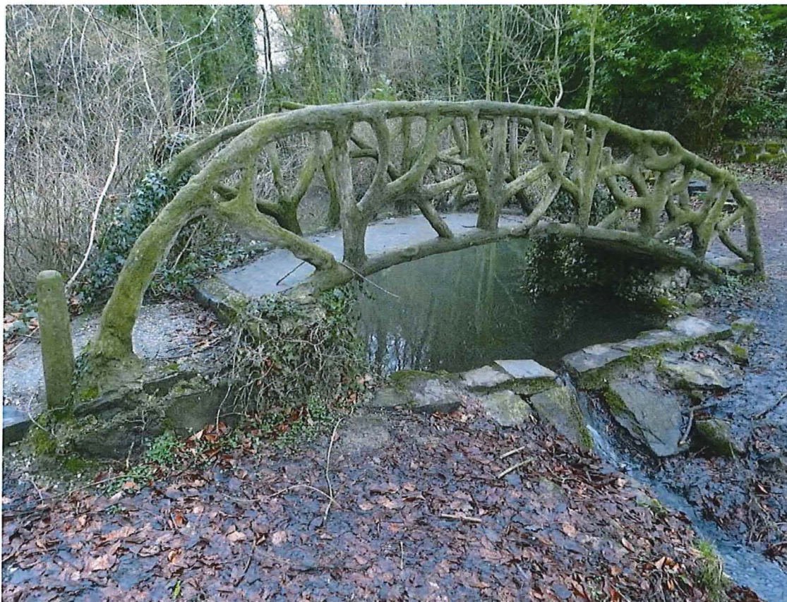
foto 39: cementrustiek sierbrugje annex stuw in gestapelde natuursteen
