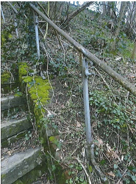
foto 60: detail ijzeren armleuning steektrap
