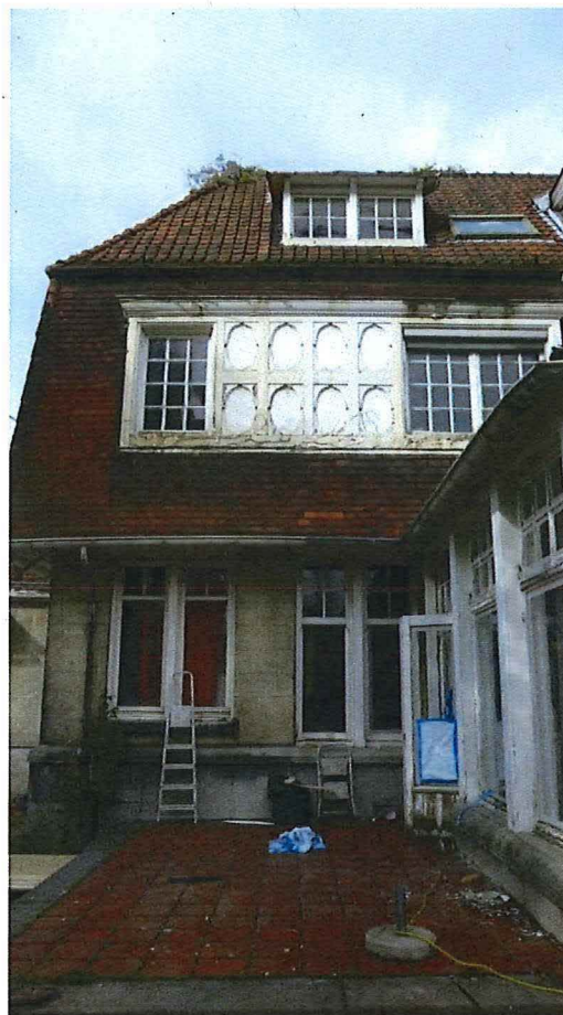
Foto 32: zuidelijk volume oostgevel en aansluiting op middenvolume.
