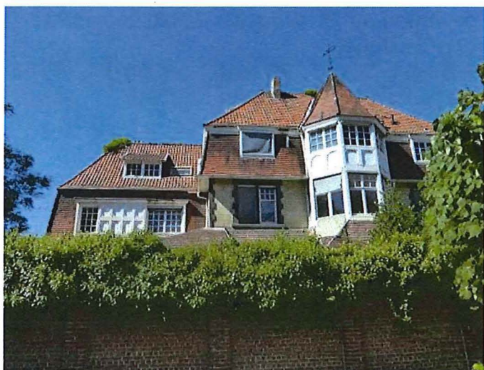
Foto 2: zuidelijk deel van de oostgevel.
