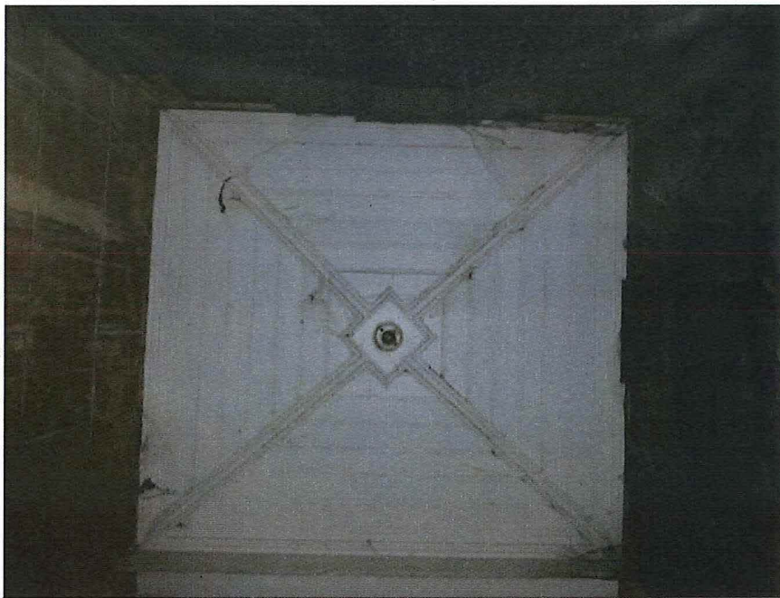
Foto 24: houten plafond ingangsportiek
