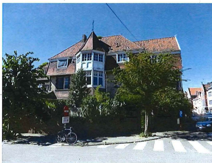
Foto 3: noordelijk deel van de oostgevel
