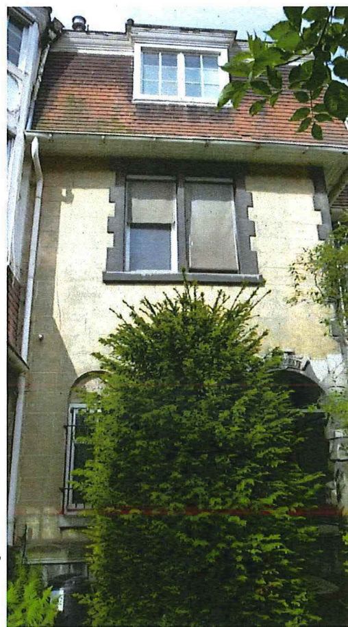
Foto 26: oostelijk gevelveld van het middelste volume met portiek, twee vensters in boognis en bovenliggende verdiepingen.
