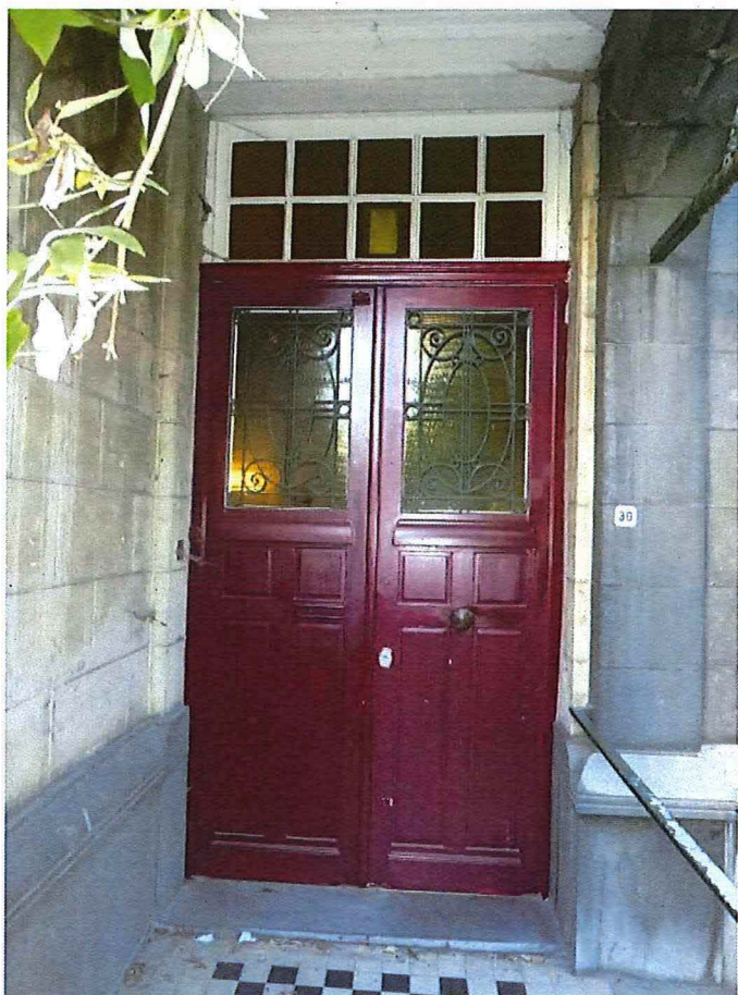
Foto 27: detail oorspronkelijk schrijnwerk, inkomdeur.
