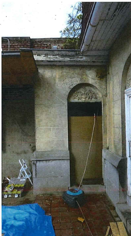
Foto 34: zuidelijk volume met toegang tot buitentoilet.
