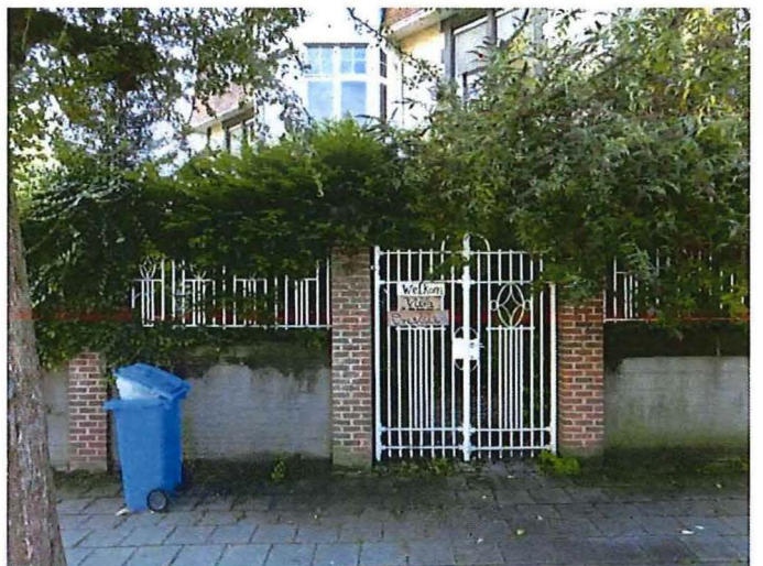
Foto 14: Hoek Kollegestraat en Sint-Amandslaan: tuinmuur met toegangspoort in smeedwerk
