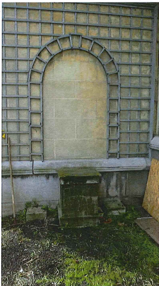
Foto 31: noordelijke muur van de tuinkamer.
