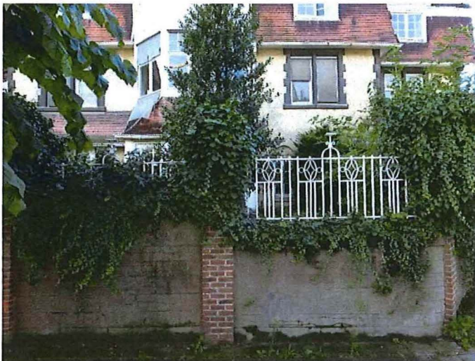
Foto 11: Kollegestraat tuinmuur oostzijde
