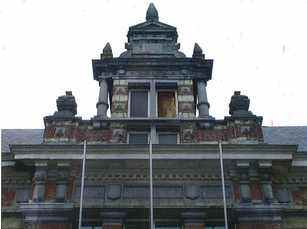
Foto 2: Topgevel van de centrale poorttravee
