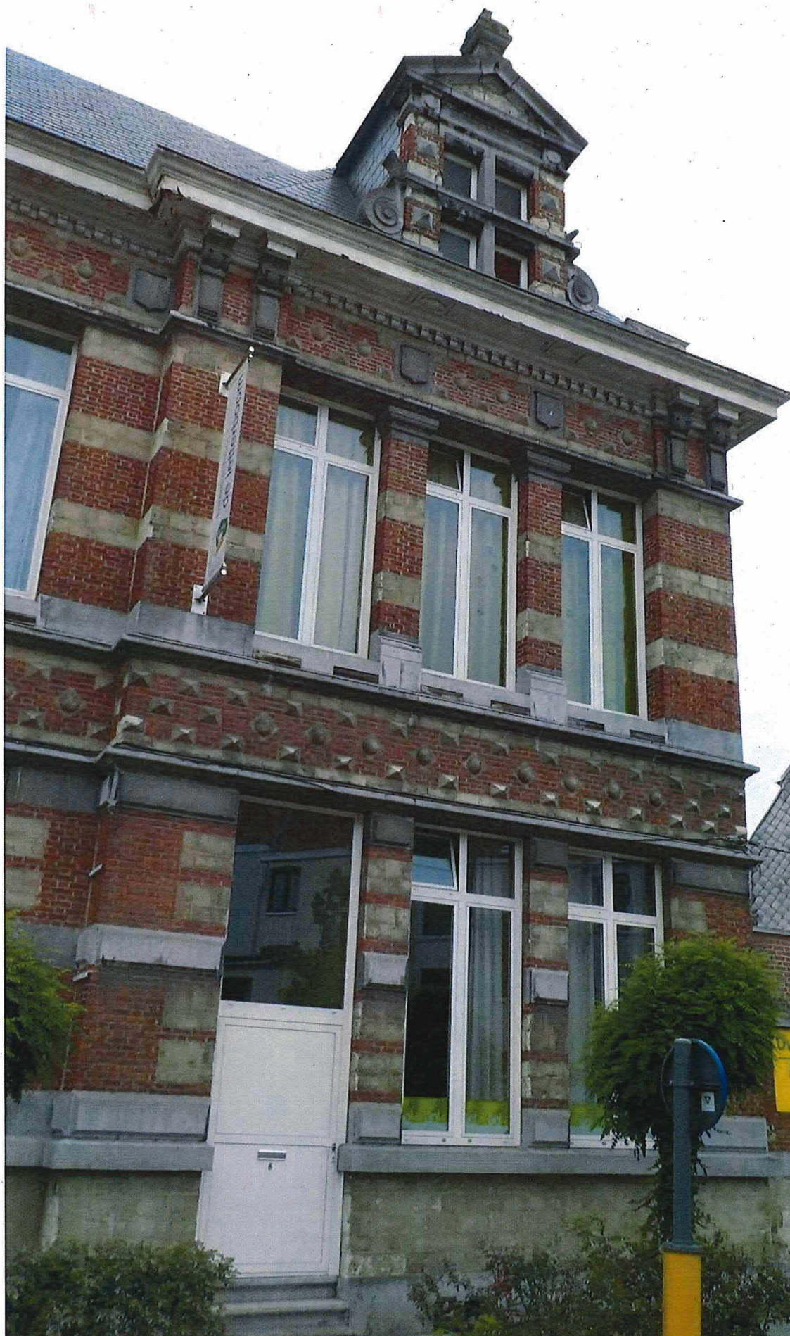
Foto 4: Voorgevel van de voormalige conciërgewoning
