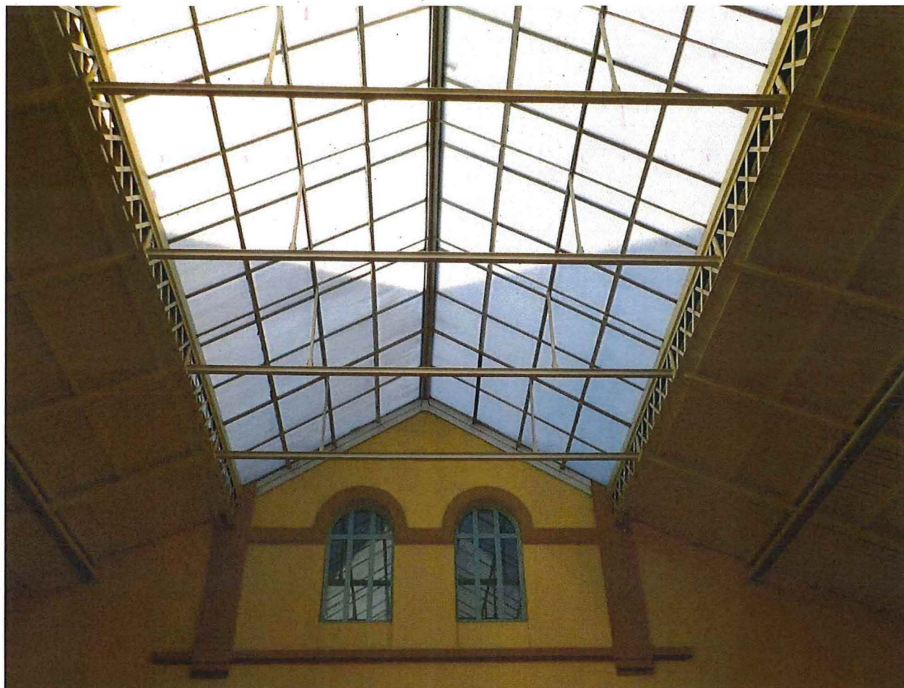
Foto 5: Overdekte speelplaats, overkapping
