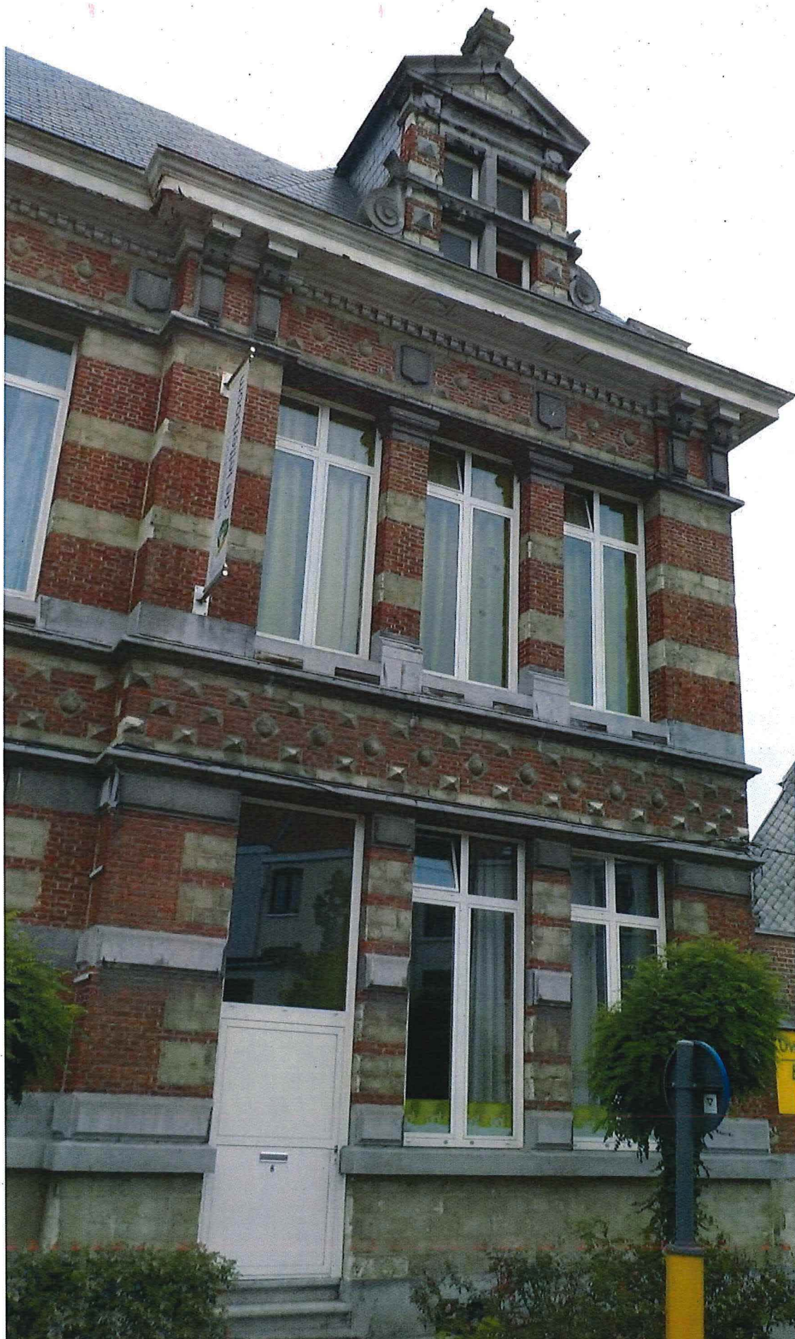
Foto 4: Voorgevel van de voormalige conciërgewoning
