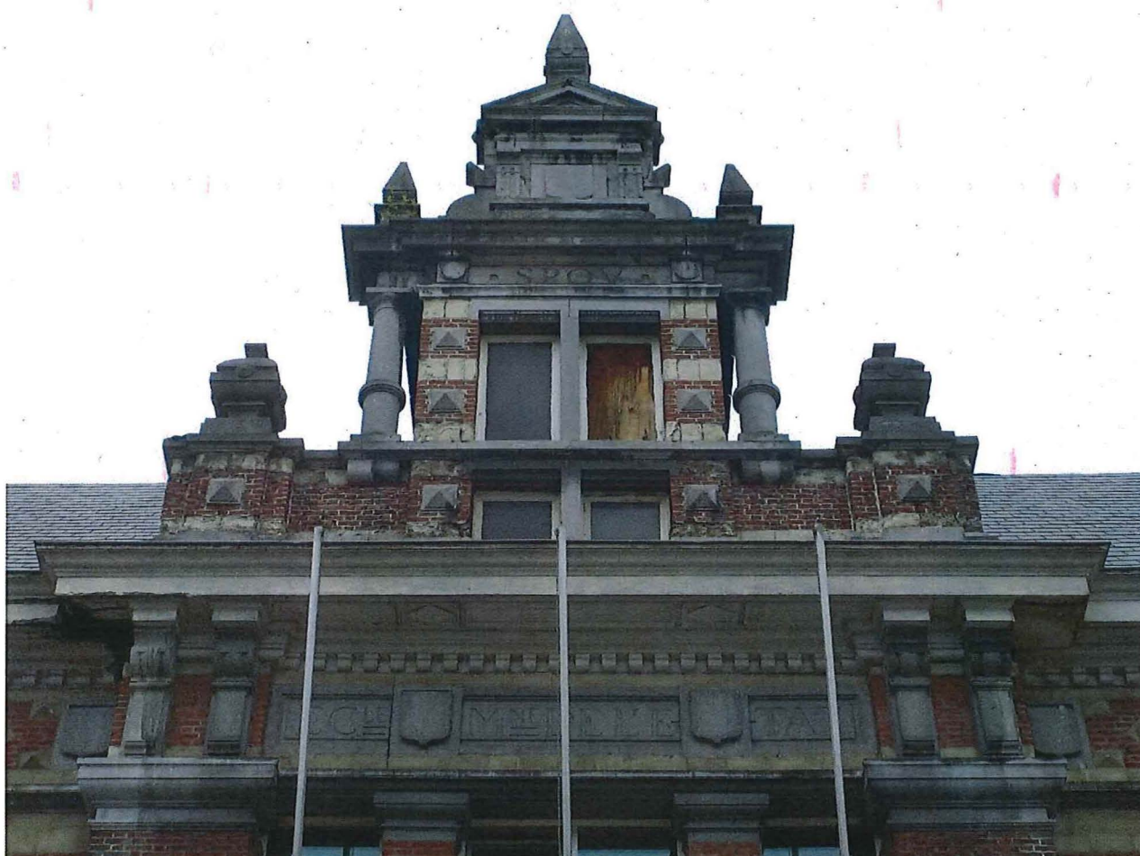
Foto 2: Topgevel van de centrale poorttravee
