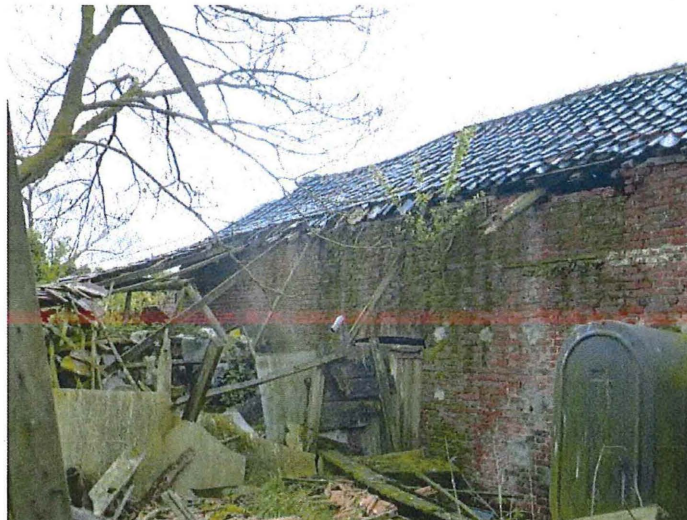
Foto 21: achterzijde van het dwarsschuurtje – bemerk hetzelfde type geglazuurde pannen als bij het hoofdvolume (plaatsbezoek 14 september 2016).
