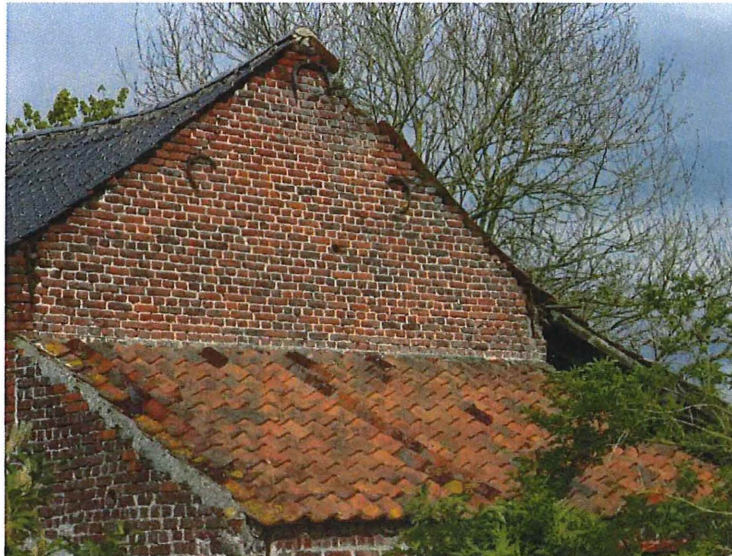
Foto 20: dwarsschuurtje, rechter zijgevel met halfcirkelvormige muurankers. De recentere aanbouw onder lessenaarsdak hoeft niet bewaard te blijven (plaatsbezoek 14 september 2016).
