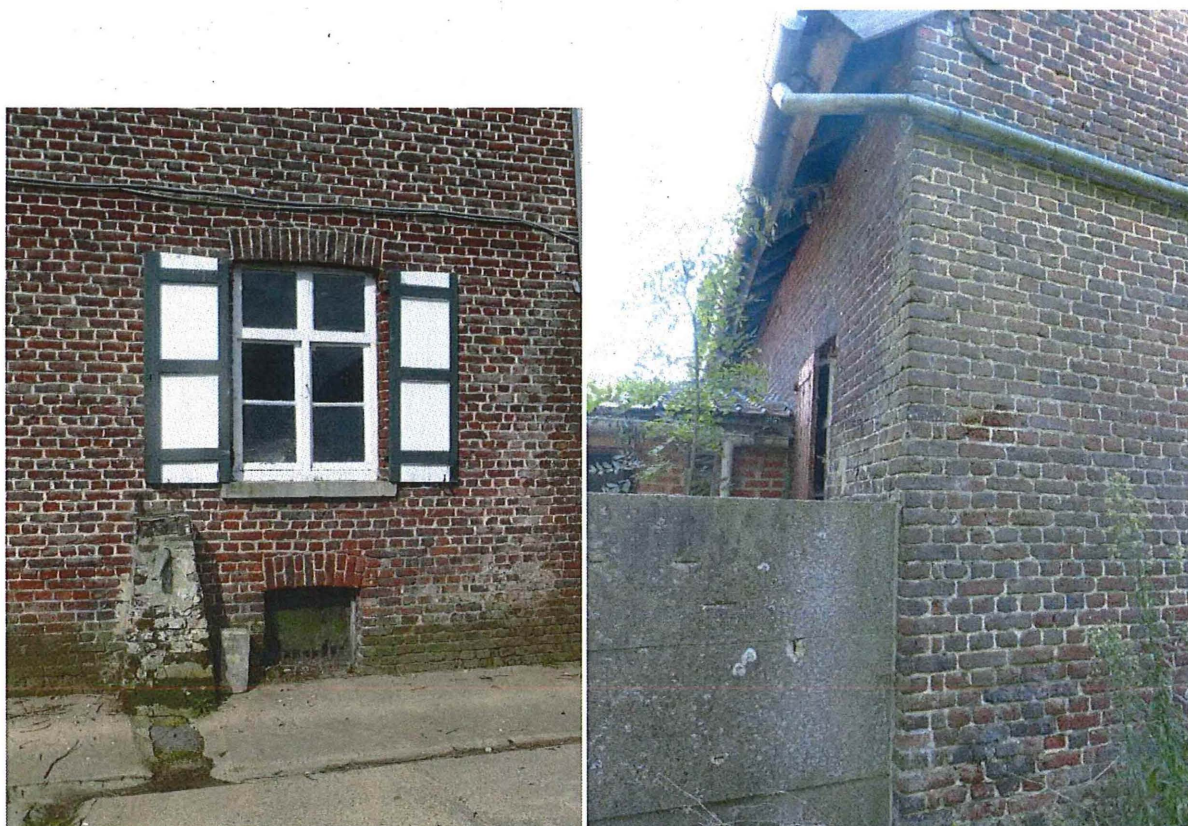
Foto 15: achtergevel van het herbergvolume met pomp, keldervenster met diefijzers en opkamervenster (plaatsbezoek 14 september 2016).
