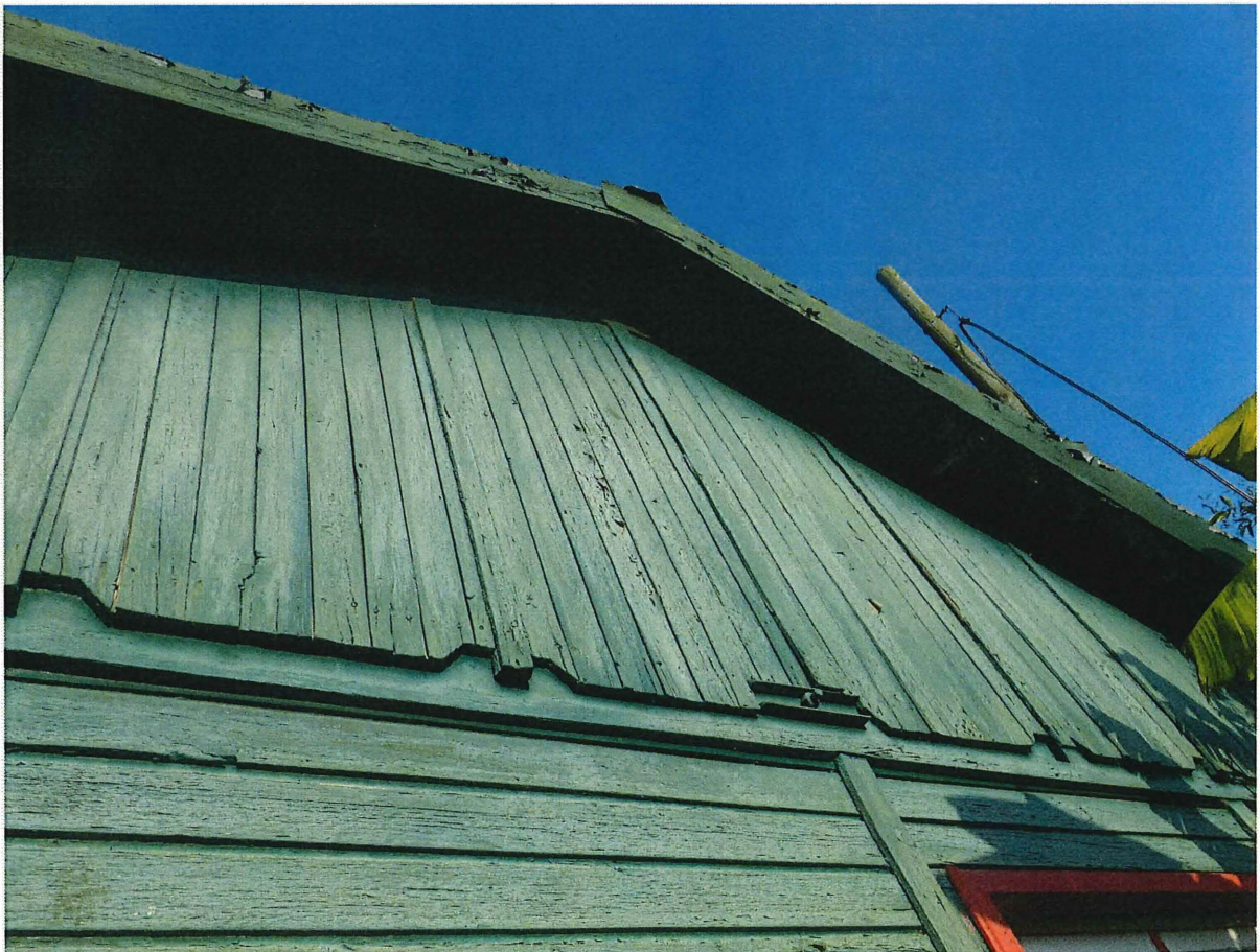
Foto 8: Detail van de beplanking aan zuidoostelijke zijde.
