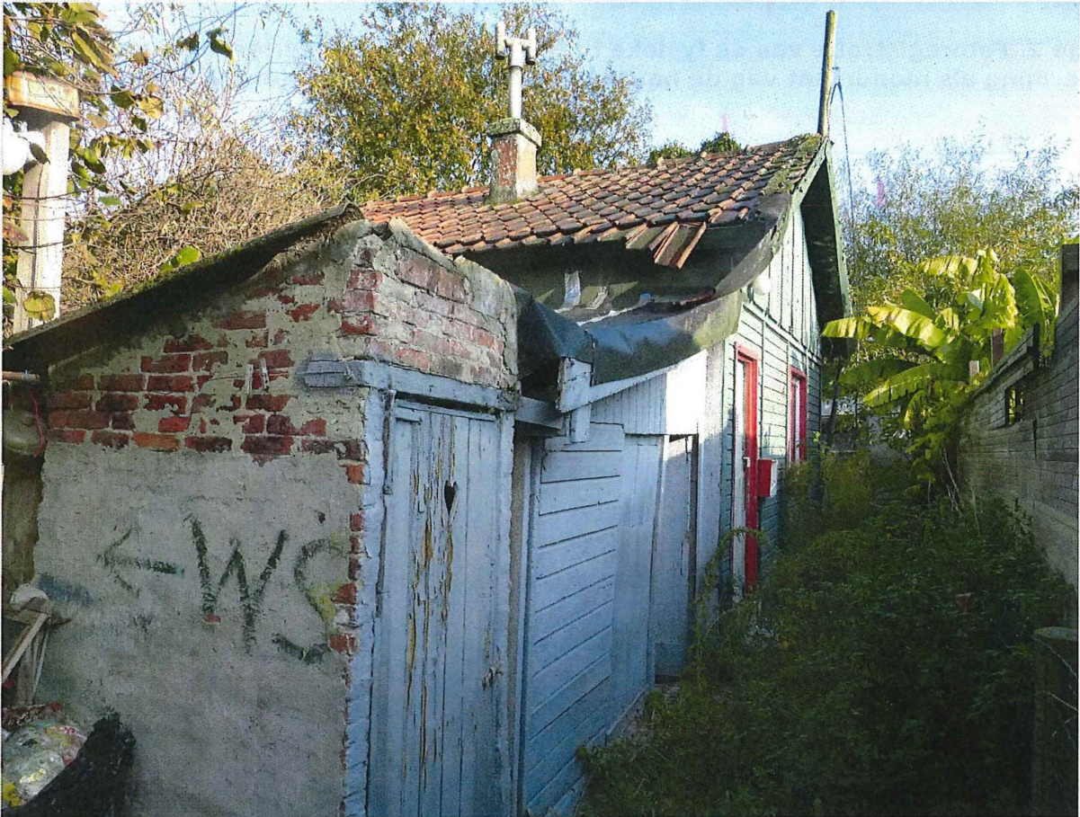
Foto 1: Zicht op de noodwoning met aangebouwd stalletje aan zuidwestelijke zijde.
