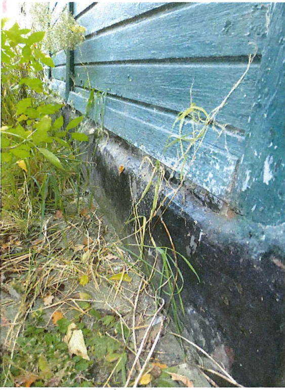
Foto 4: Gecementeerd fundament waarop de noodwoning is geplaatst.
