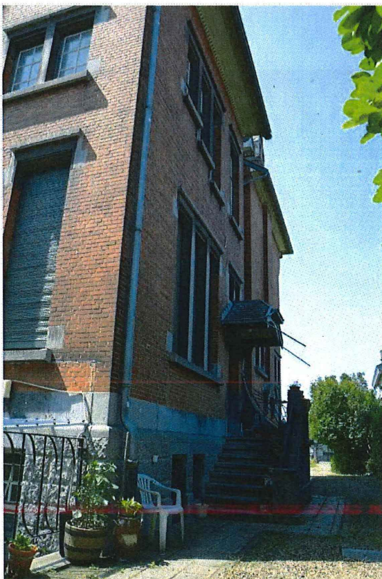
Foto 33: Noordelijke zijgevel, gezien vanaf het oosten (18/07/2017).
