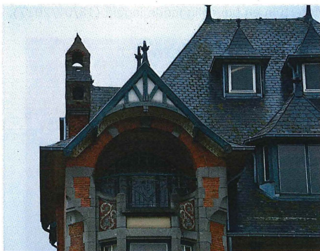
Foto 13: Voorgevel, zicht op de loggia in de eerste travee (22/02/2017).
