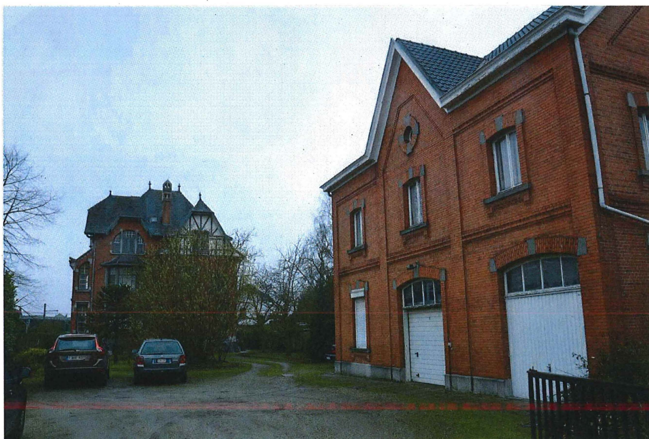
Foto 6: Zicht op de achtergevel (oostgevel) van de Villa Coppin en de voormalige portierswoning, gezien vanaf de Onderwijsstraat (22/02/2017).
