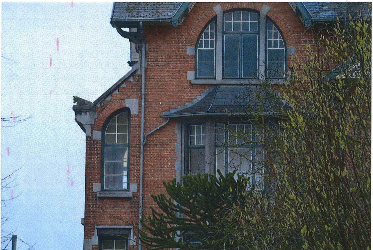
Foto 32: Achtergevel, detail. Zicht op de vensters van in de eerste travee en op de zijkant van de loggia in de zuidgevel (22/02/2017).
