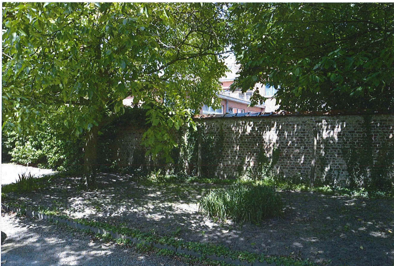
Foto 7: De met pannen afgedekte bakstenen tuinmuur langs de noordgrens van het perceel (18/07/2017).
