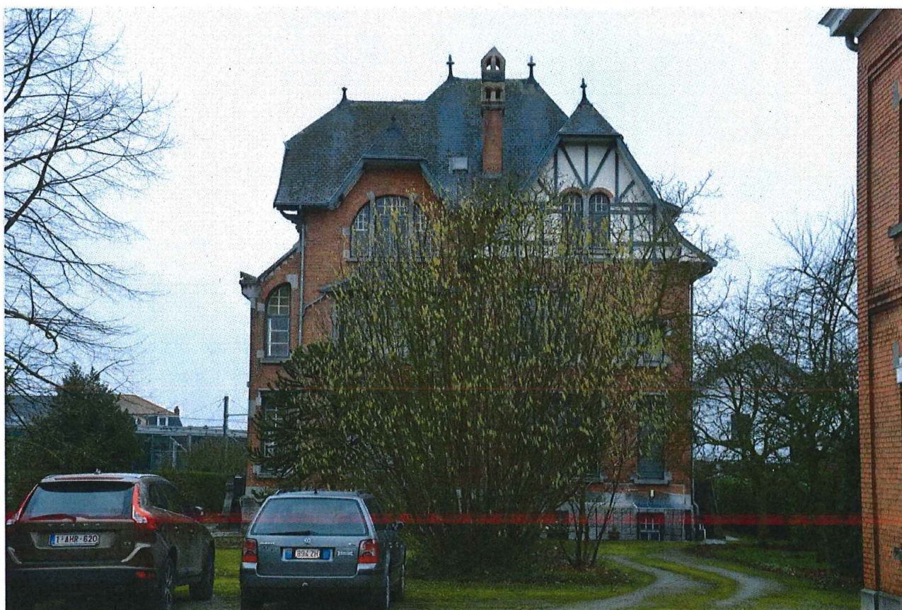
Foto 27: Achtergevel en tuin, gezien vanuit het oosten (22/02/2017).
