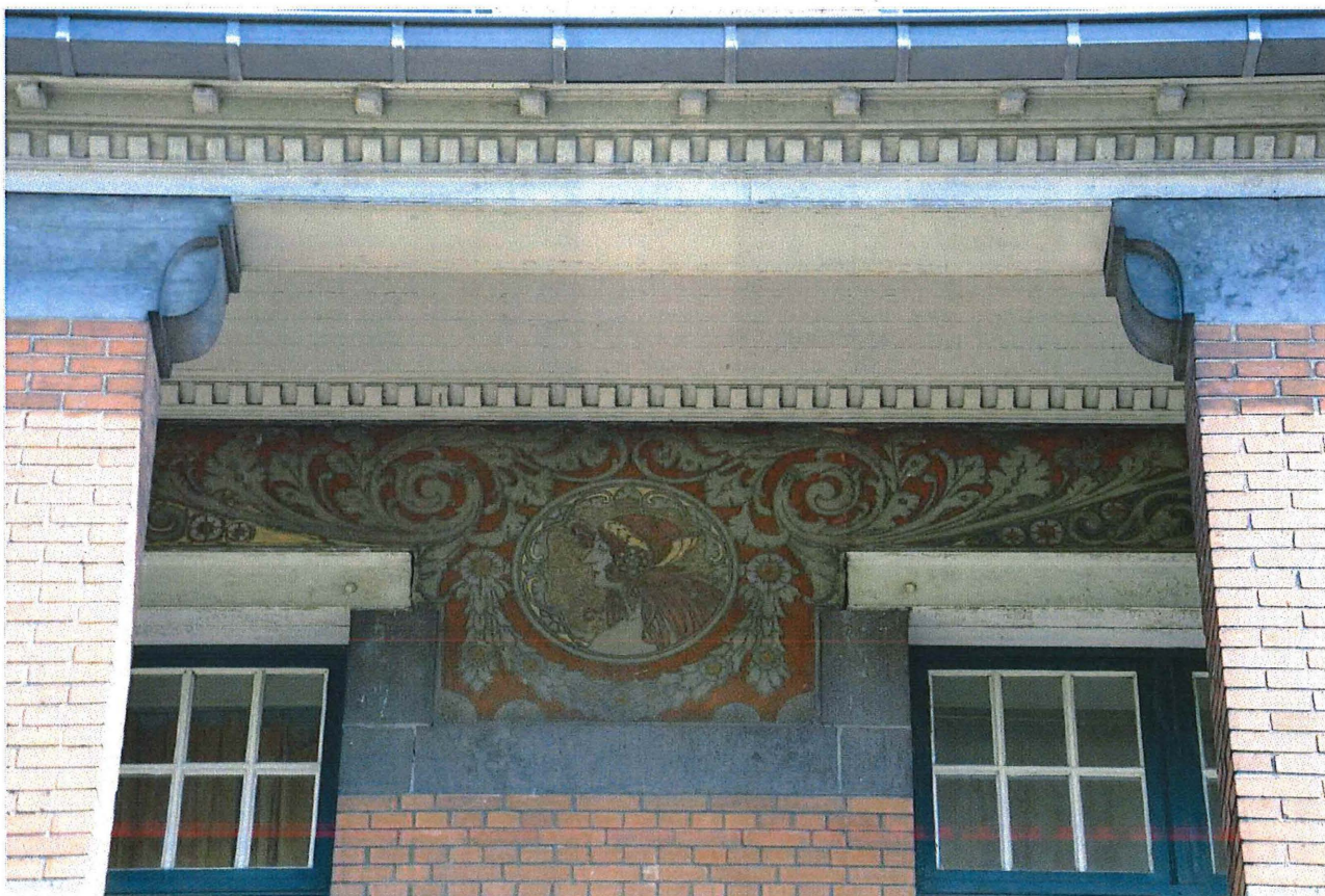
Foto 22: Zuidelijke zijgevel, detail. Zicht op het sgraffitopaneel en de metalen lateien boven de vensterdeuren van de loggia (18/07/2017).
