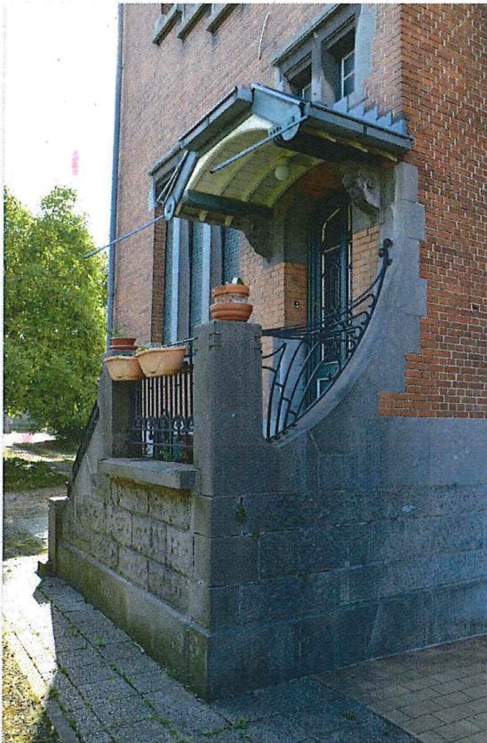
Foto 35: Noordelijke zijgevel, detail. Buitentrap naar de toegangsdeur onder luifel (18/07/2017).
