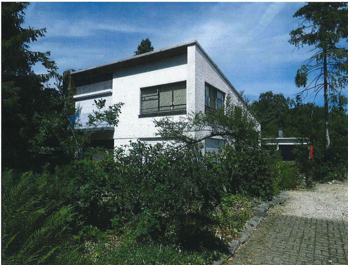
Foto 10: Woning Burssens met achterliggend museumgebouw. Zicht vanop de oprit.
