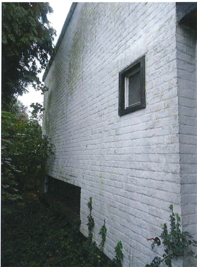
Foto 26: Linkerdeel van de noordwestelijke zijgevel.
