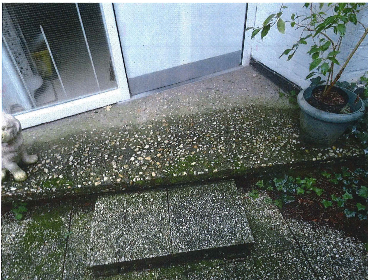
Foto 24: Detail toegangstrede tot de woning, uitgevoerd in silexdallen.
