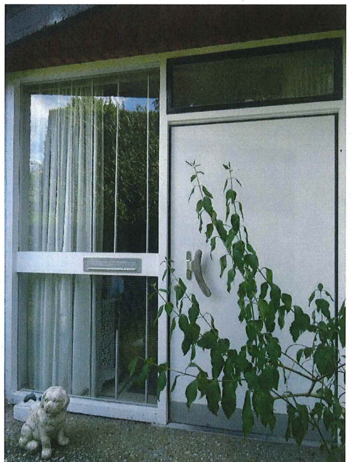
Foto 23: Detail van de deur met bovenlicht en het flankerend venster.
