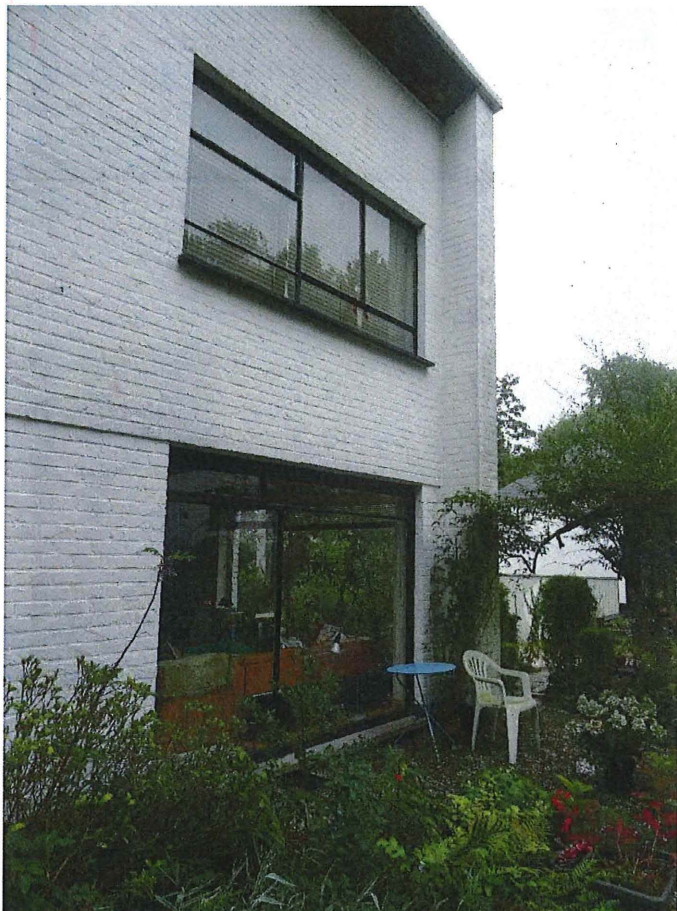
Foto 17: Zuidwestelijke voortuingevel. Detail van het schrijnwerk in de rechtertravee.
