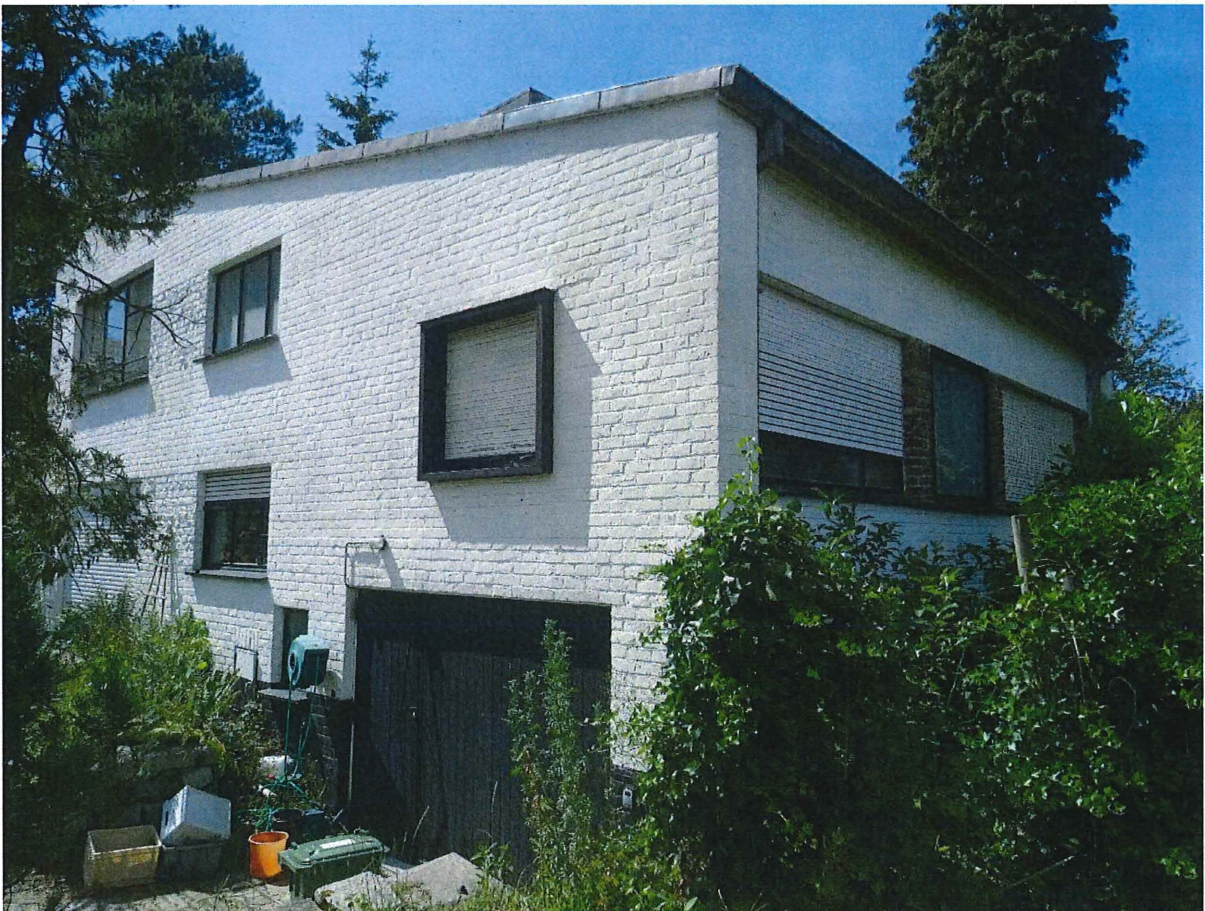
Foto 32: Zuidoostelijke zijgevel en noordoostelijke achtergevel.
