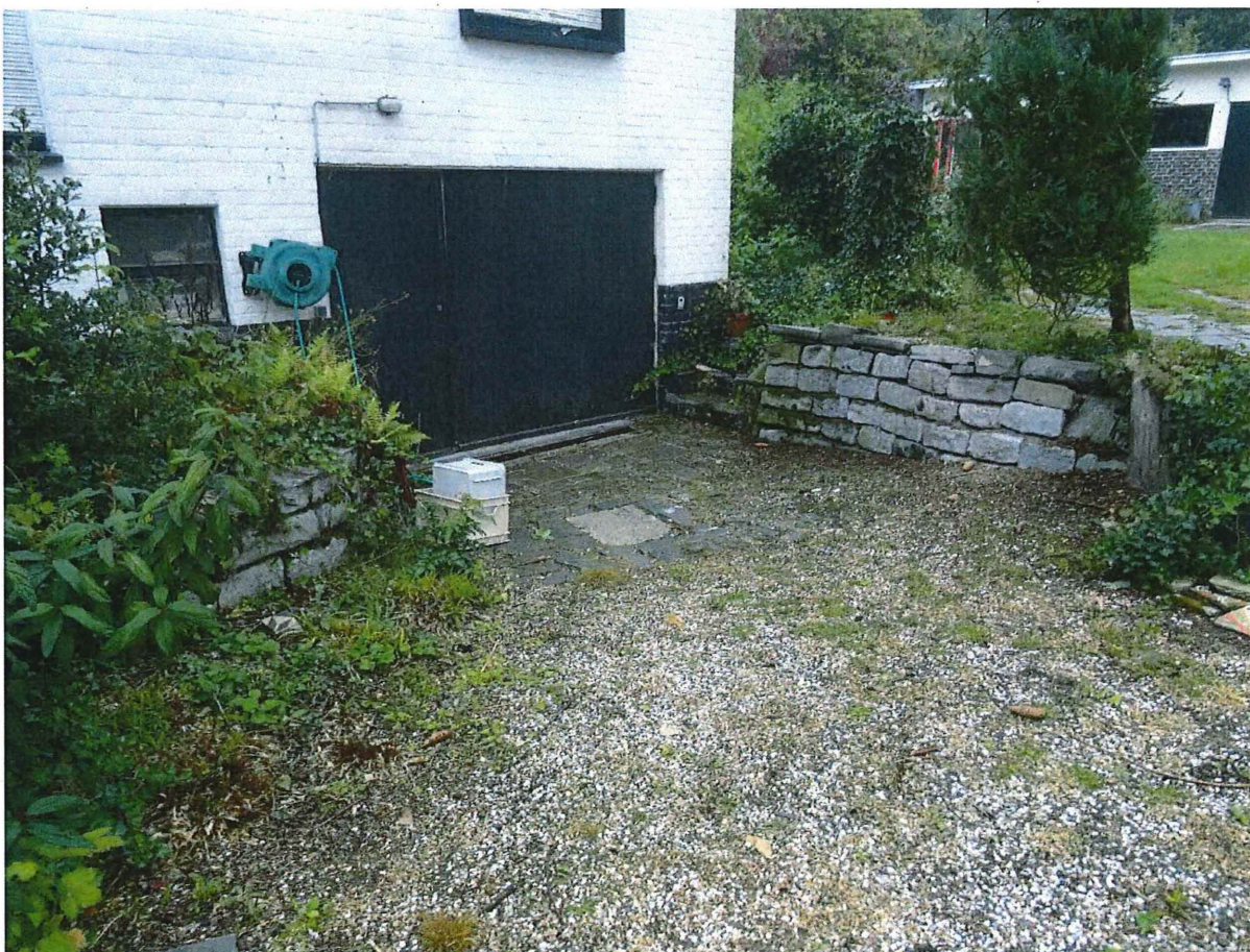
Foto 7: Oprit tot de garage in het souterrain.
