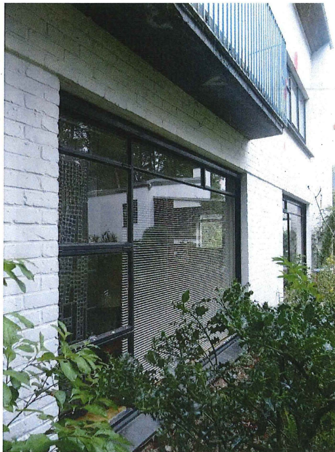
Foto 18: Zuidwestelijke voortuingevel. Detail schrijnwerk linker benedenvenster.
