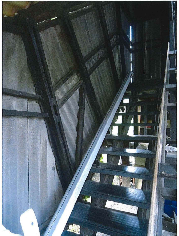
Foto 17: Buitentrap. Binnenzicht vanaf beneden.
