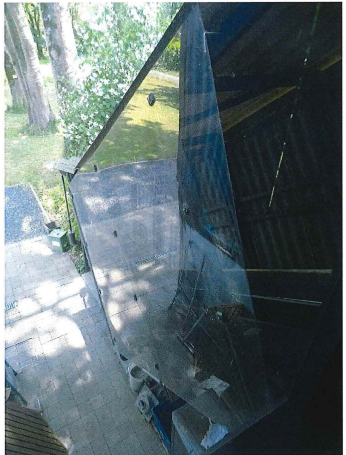
Foto 19: Buitentrap, zicht vanuit portiek op bovenverdieping.
