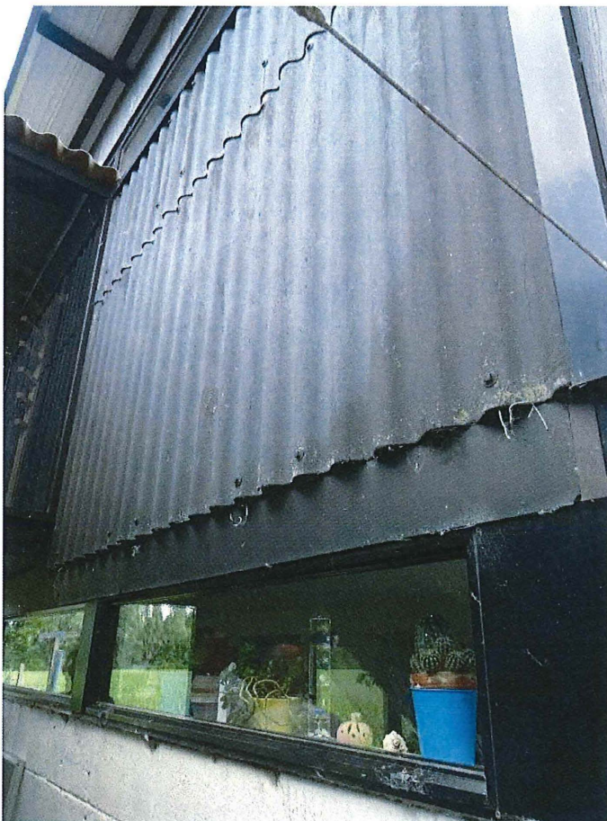
Foto 21: Rechterdeel van de westelijke zijgevel, bovenverdieping afgewerkt met golfplaten.
