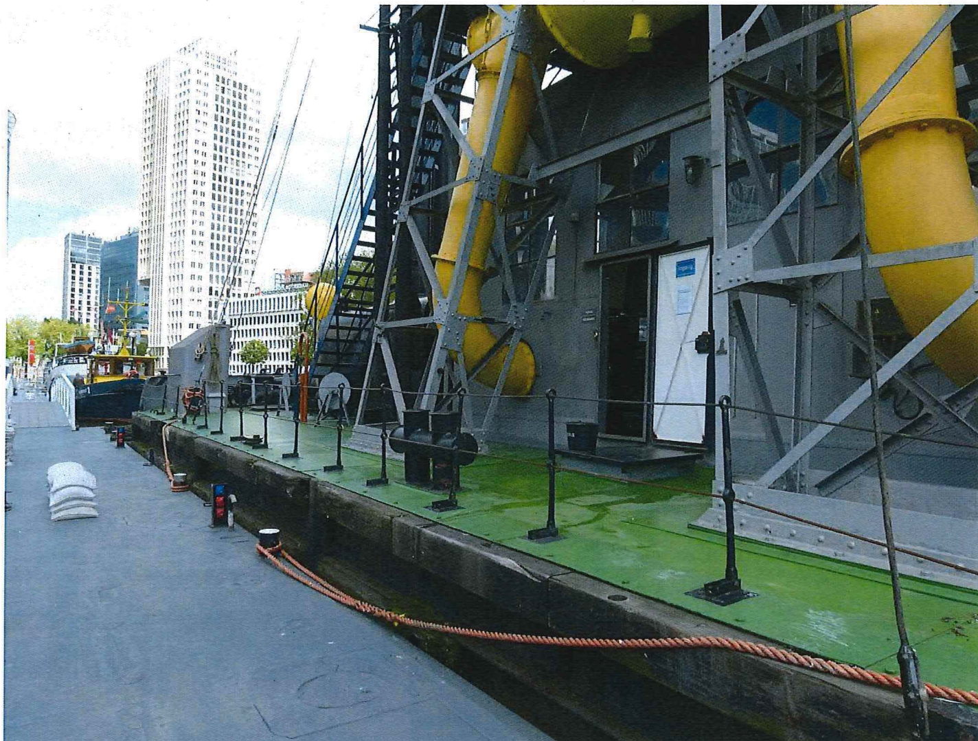
Foto 31: Zicht op de bakboordzijde van het vaartuig, met de toegang tot de machinekamer vanop het dek. De basis van de toren in stalen vakwerk is hier zichtbaar, evenals de twee luchtafvoerbuizen van de vacuümpompen.
