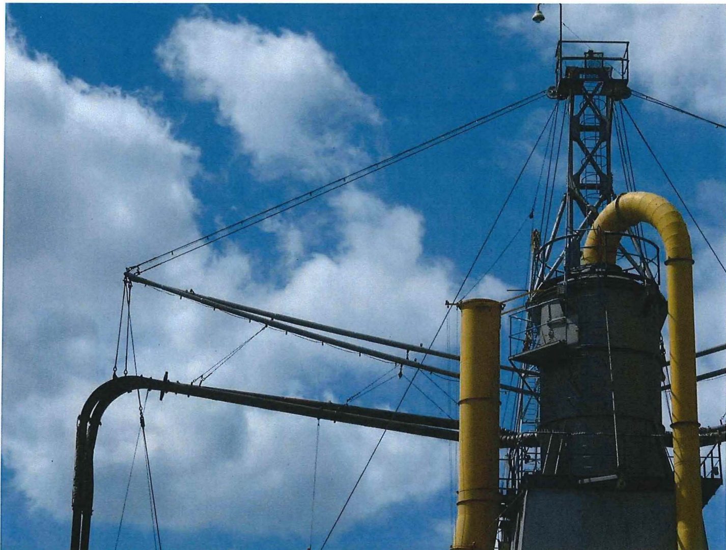
Foto 16: Zicht op de top van de toren met de recipiënt, de mast, de gieken en de graanzuigleidingen.
