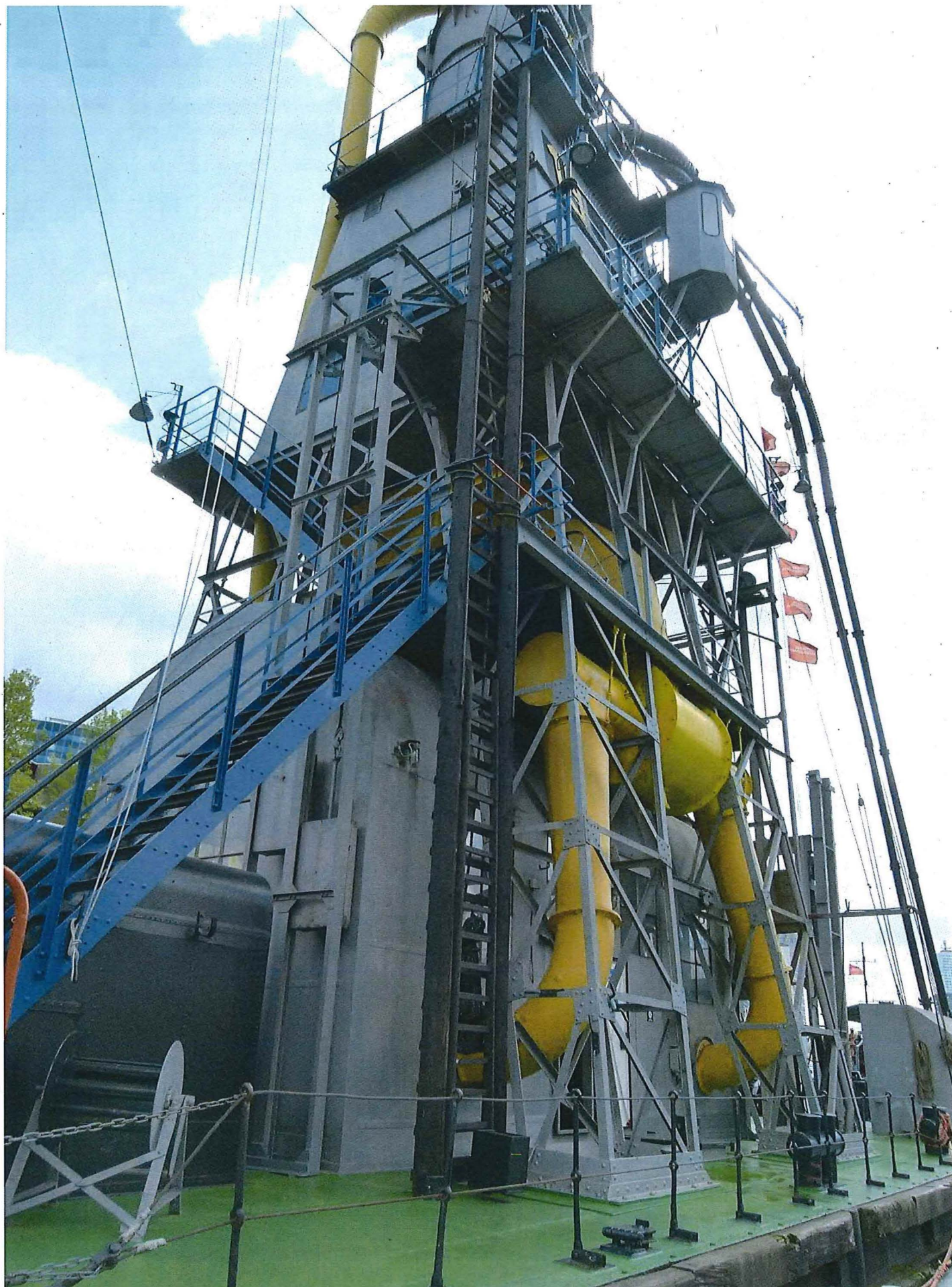
Foto 7: Zicht op de toren vanaf de bakboordzijde.
