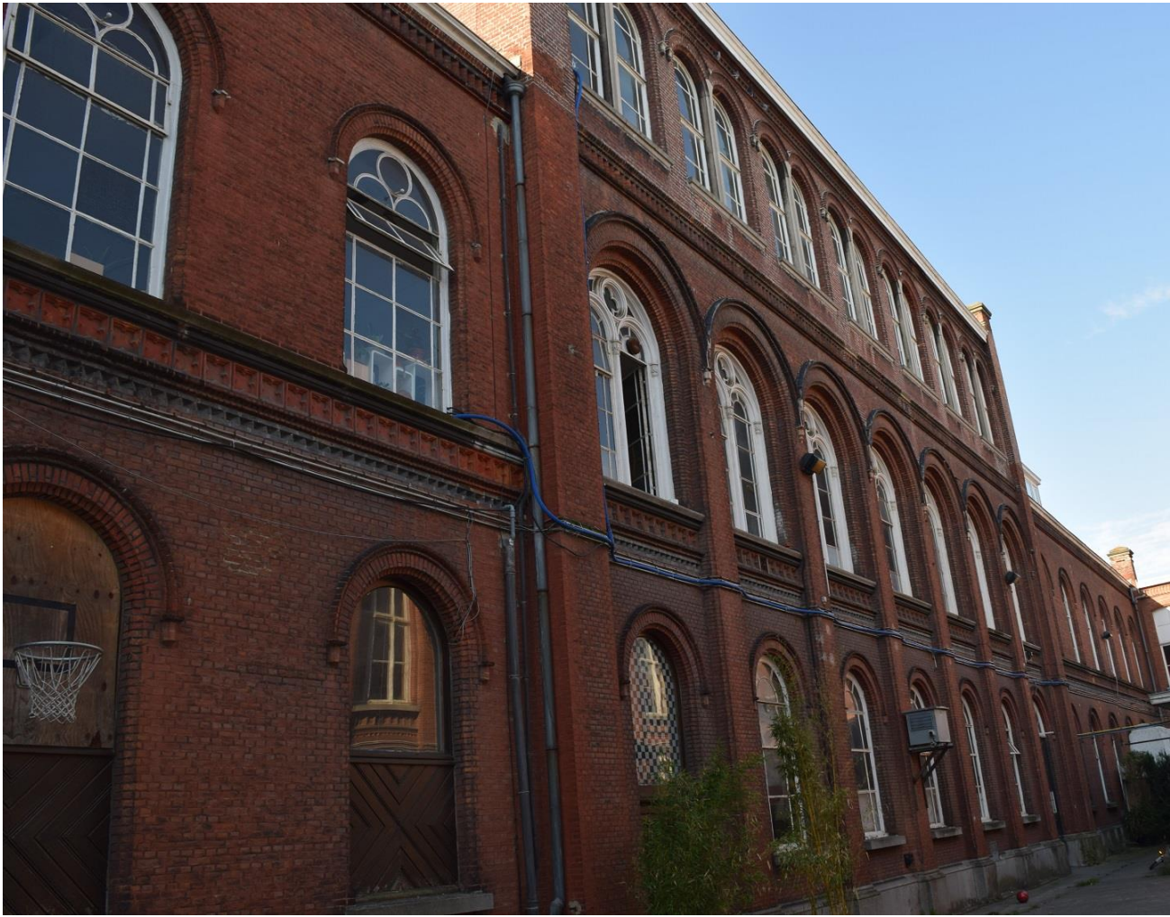
Foto 1: Nijverheidsschool (1857-1859) voorgevel zuidzijde binnenkoer
