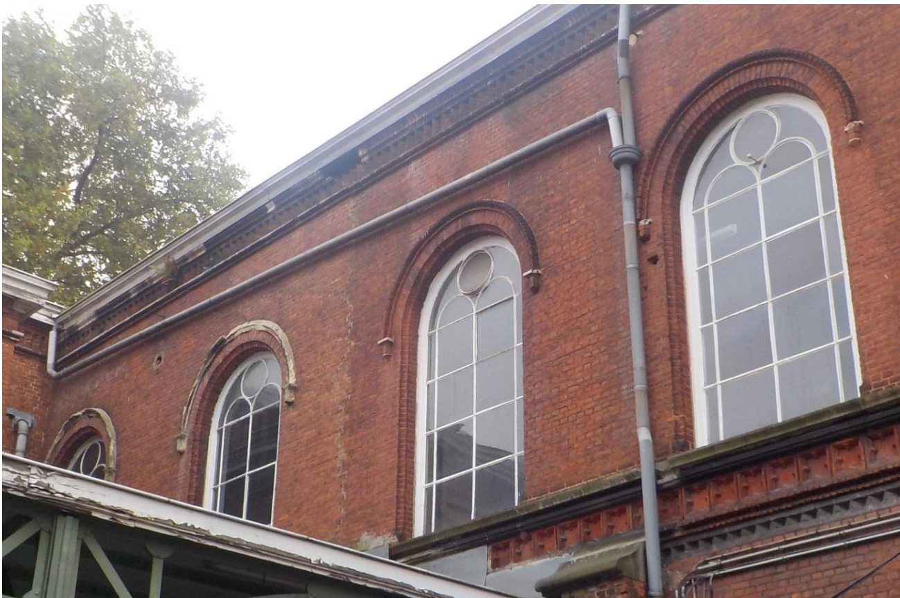
Foto 2: Nijverheidsschool (1857-1859) voorgevel (rechts) en lagere school (1865) zijgevel (links)
