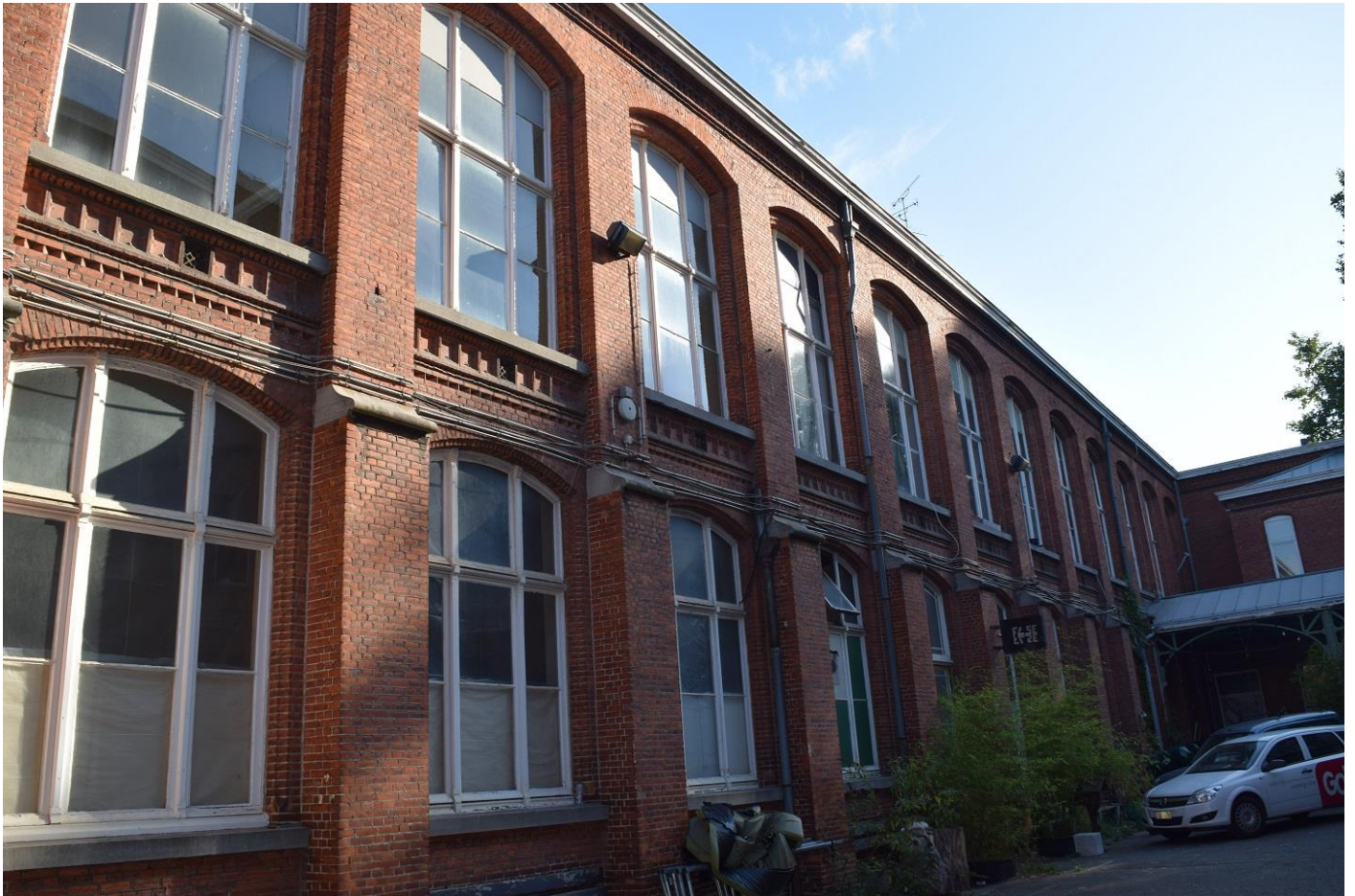
Foto 24: Nijverheidsschool (1897-1900) gevel noordzijde binnenkoer
