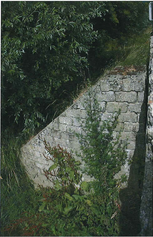
Foto 9: Steunbeer aan zuidwestelijke zijde. Foto genomen vanuit zuidoostelijk standpunt.
