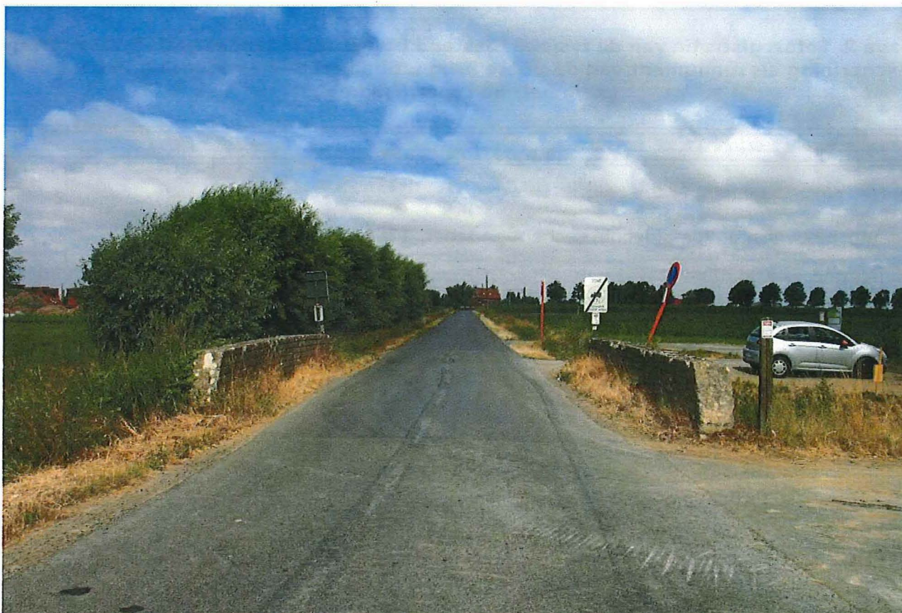
Foto 1: De brug over de Kommelbeek. Zicht vanuit zuidoostelijk standpunt in de richting van het gehucht Hallebast.
