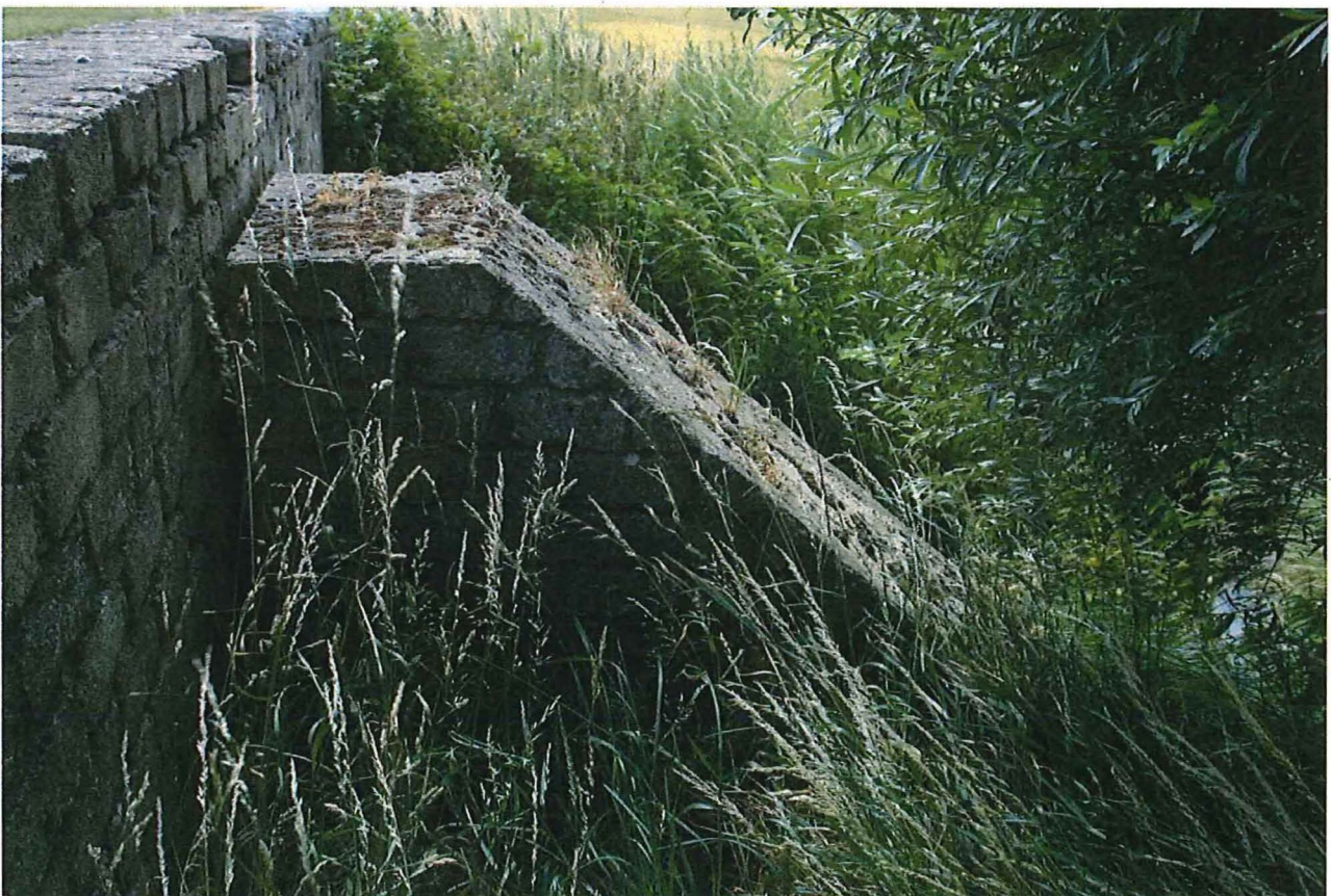
Foto 8: Steunbeer aan zuidwestelijke zijde. Foto genomen vanuit noordwestelijke richting.
