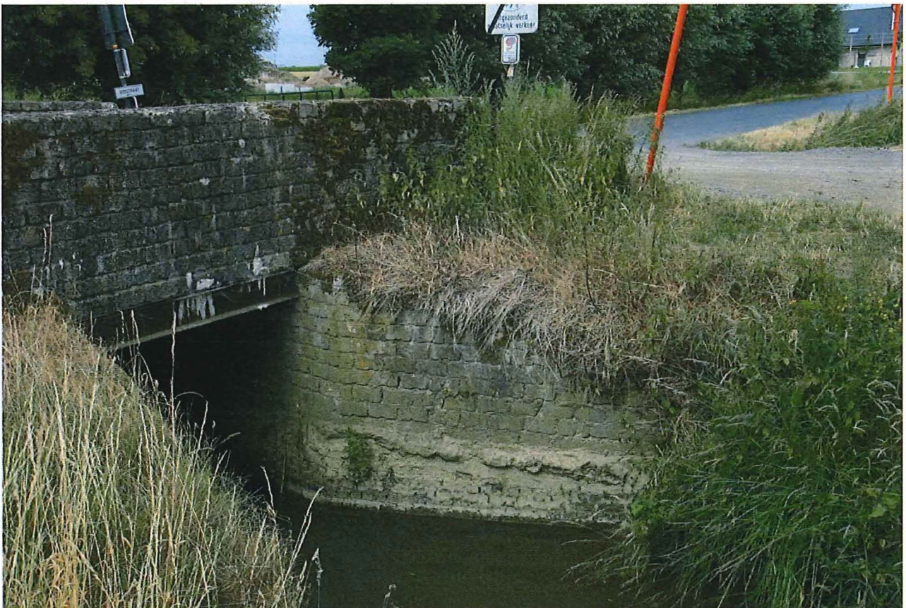
Foto 4: Zicht op de noordoostelijke borstwering en vleugelwand.
