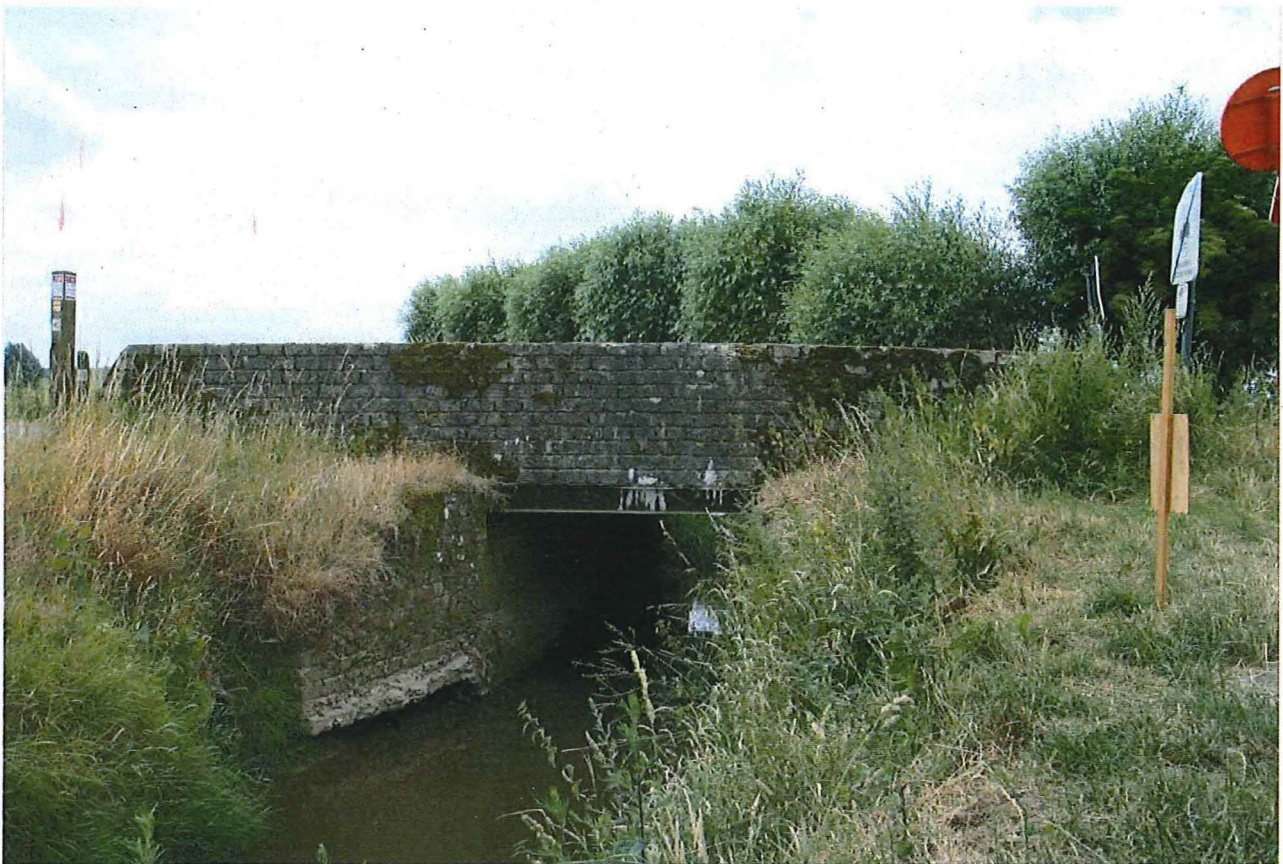
Foto 3: Zicht op de brug, vanuit noordoostelijk standpunt.
