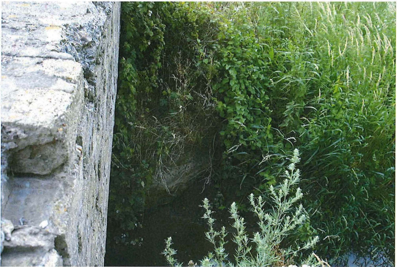
Foto 7: De zuidoostelijke vleugelwand.
