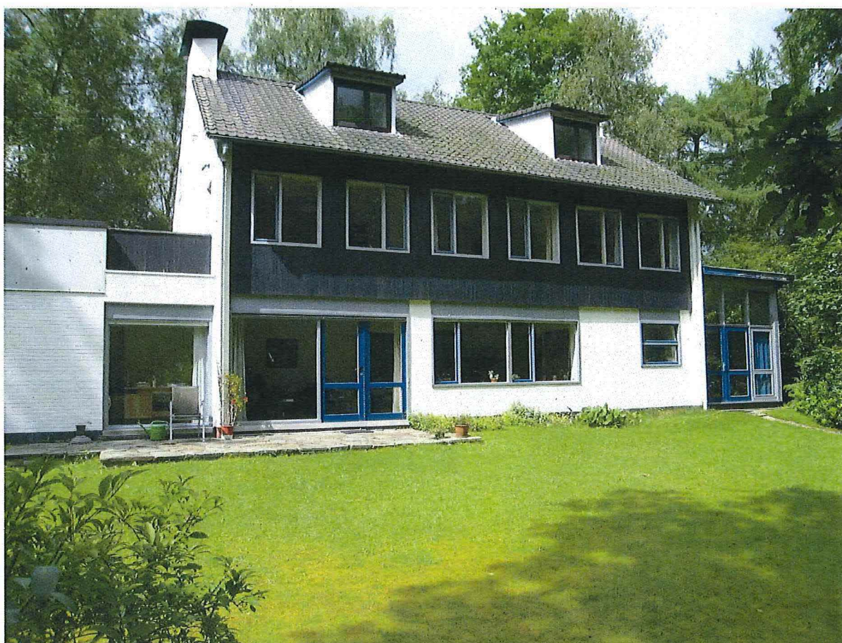
Foto 6: Schilde, Rozenlaan – Woning De Roover-Van Coillie: tuingevel
