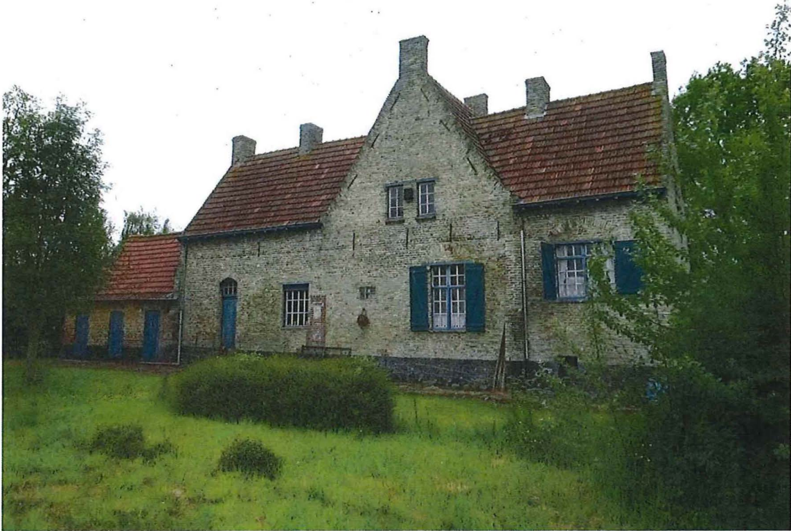
Foto 16. De achtergevel (oostgevel) van het boerenhuis. Links aansluitend, het nutsgebouw onder lager zadeldak, met drie deurtjes.
