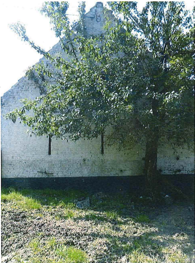
Foto 23. De zijgevel (oostgevel) van de stalling is opengewerkt door lichtgleuven.
