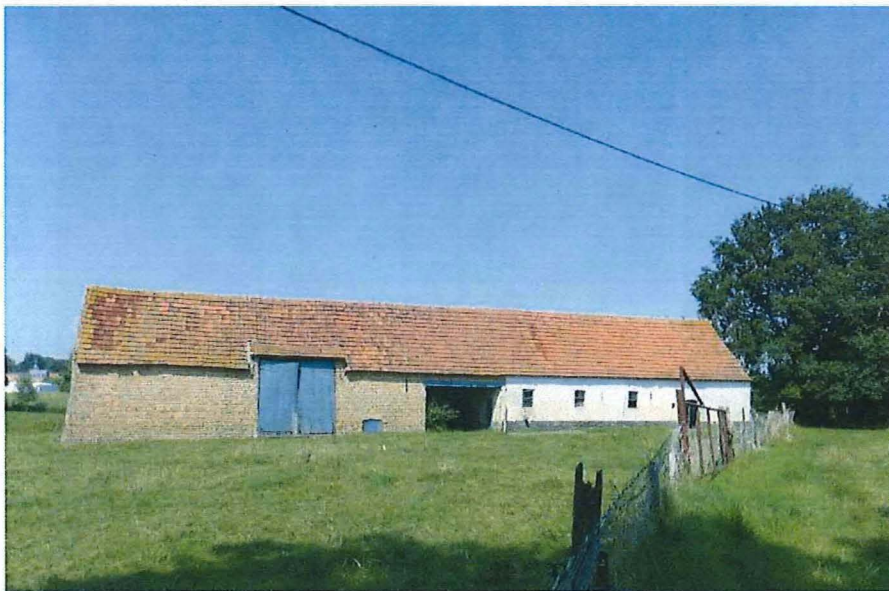
Foto 20. Het langgestrekte schuur- en stalvolume (zuidgevel) met links de schuur uit de wederopbouwperiode en rechts de witgekalkte stalling met oudere, minstens 19de-eeuwse kern. Foto 21. De zijgevel (westgevel) van de schuur met steunberen, aandaken en vlechtingen.
