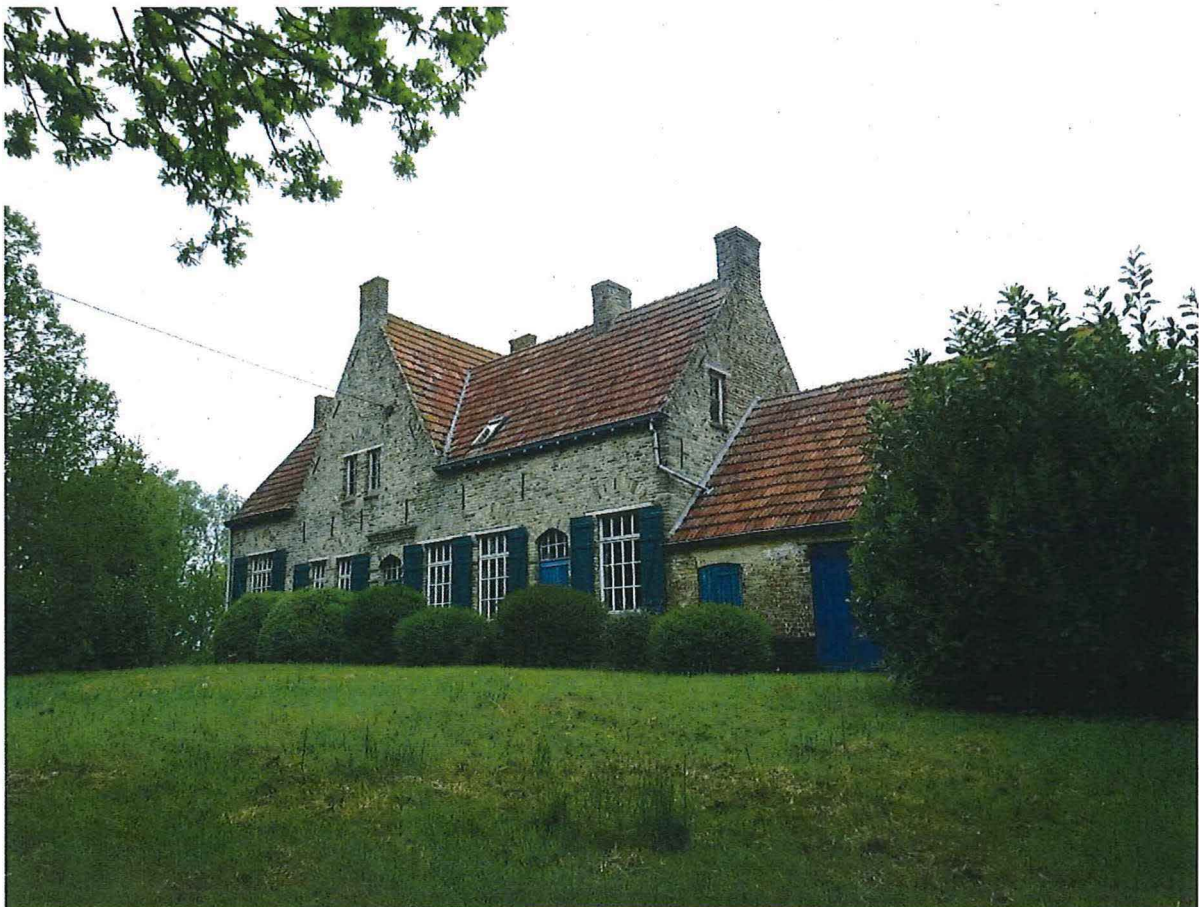
Foto 4. Het boerenhuis heeft landhuisallure door de ligging op een opgehoogd perceel én door de volumeopbouw en dakstructuur. Zicht vanuit de westzijde.
