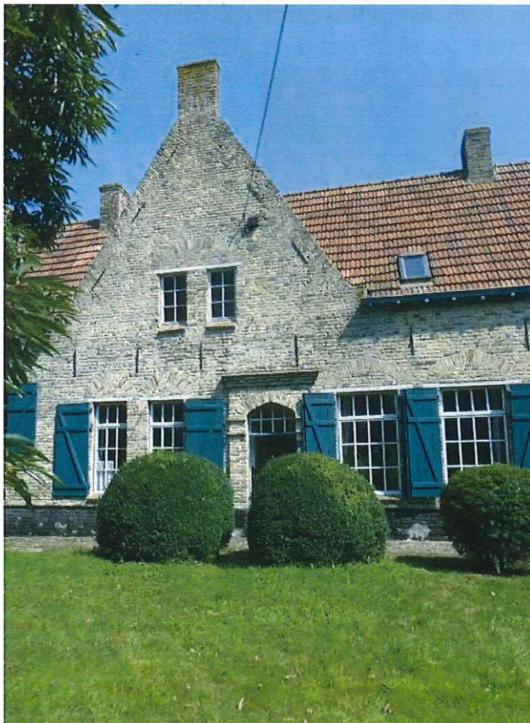
Foto 8. De westgevel van het boerenhuis met kenmerkende aandaken en muurvlechtingen. De toegang tot het hoofdportaal wordt begeleid door twee in bolvorm geknipte palmboompjes.
