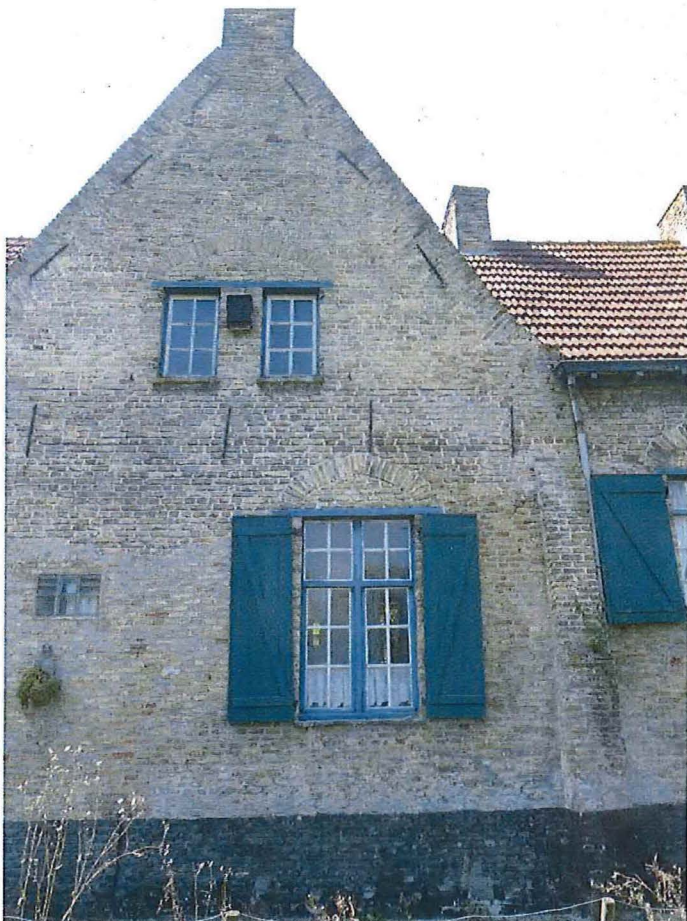
Foto's 18 en 19. Bewaard oorspronkelijk houtwerk in de achtergevel (rechter travee onder het brede dakvenster). Houten kruisvenster met kleine roedeverdeling. Ook in de tuitgevel is het houtwerk bewaard.
