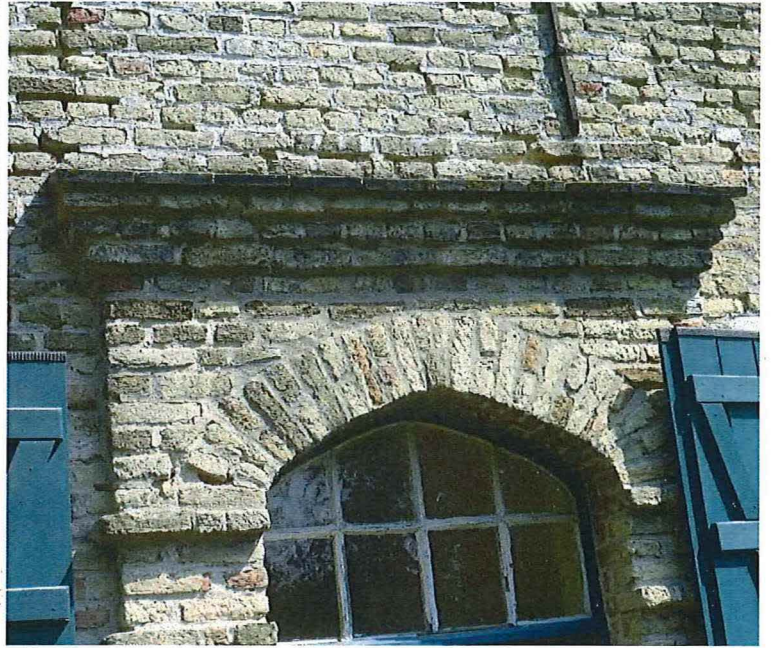
Foto's 9 en 10. Westgevel van het boerenhuis: sierlijk portaal (tudorboog) in geriemde omlijsting, afdekking door tegels. Bewaard houtwerk met kleine roedeverdeling (bovenlicht).
