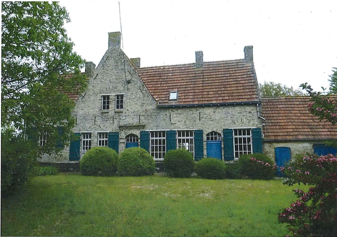
Foto 7. De westgevel van het boerenhuis met rechts aansluitend nutsgebouw.
