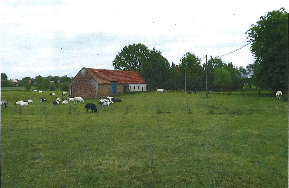
Foto 3. Algemeen beeld van de wederopbouwhoeve 'Watervliet' met grachtrestanten en graslanden, vanuit het zuidwesten. Het langgestrekte schuur- en stalvolume gaat voor het witgeschilderde stalgedeelte minimaal terug op de 19de eeuw. Het microreliëf van de vroegere walgrachten is afleesbaar.
