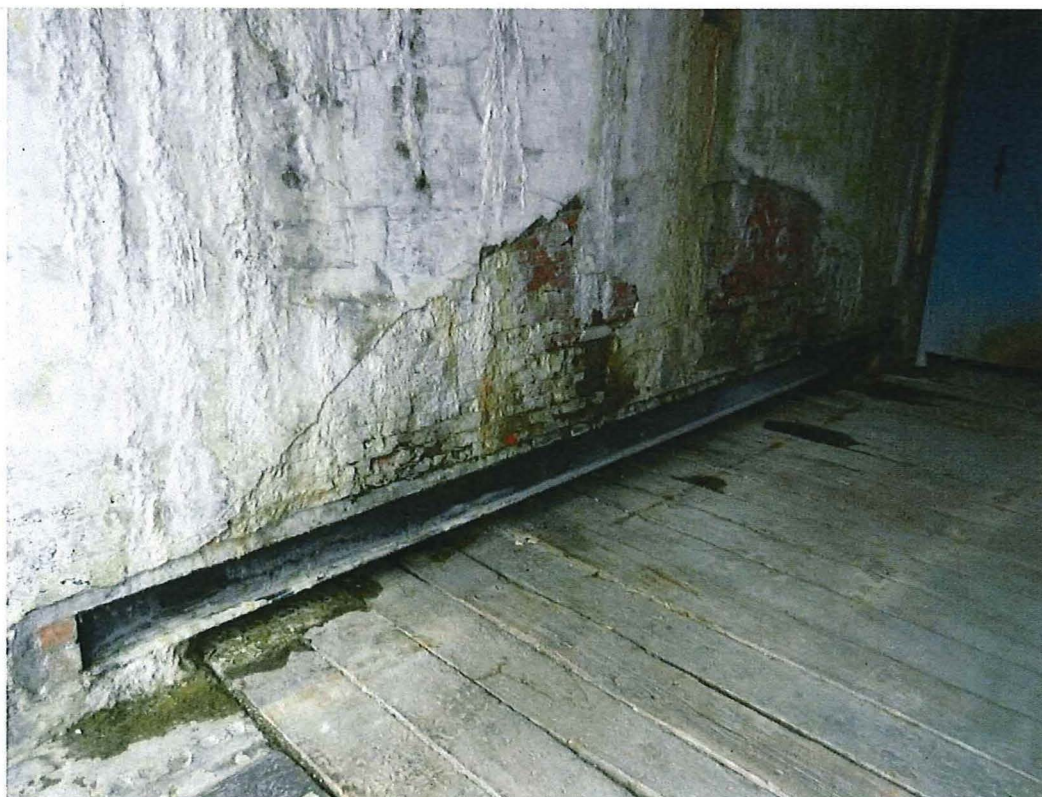
4. Mobiele brug bij de toegang van het fort. Bevindt zich in de poort van het traditoregebouw, de binnenmuur is in baksteen uitgevoerd, 12/05/2017.
