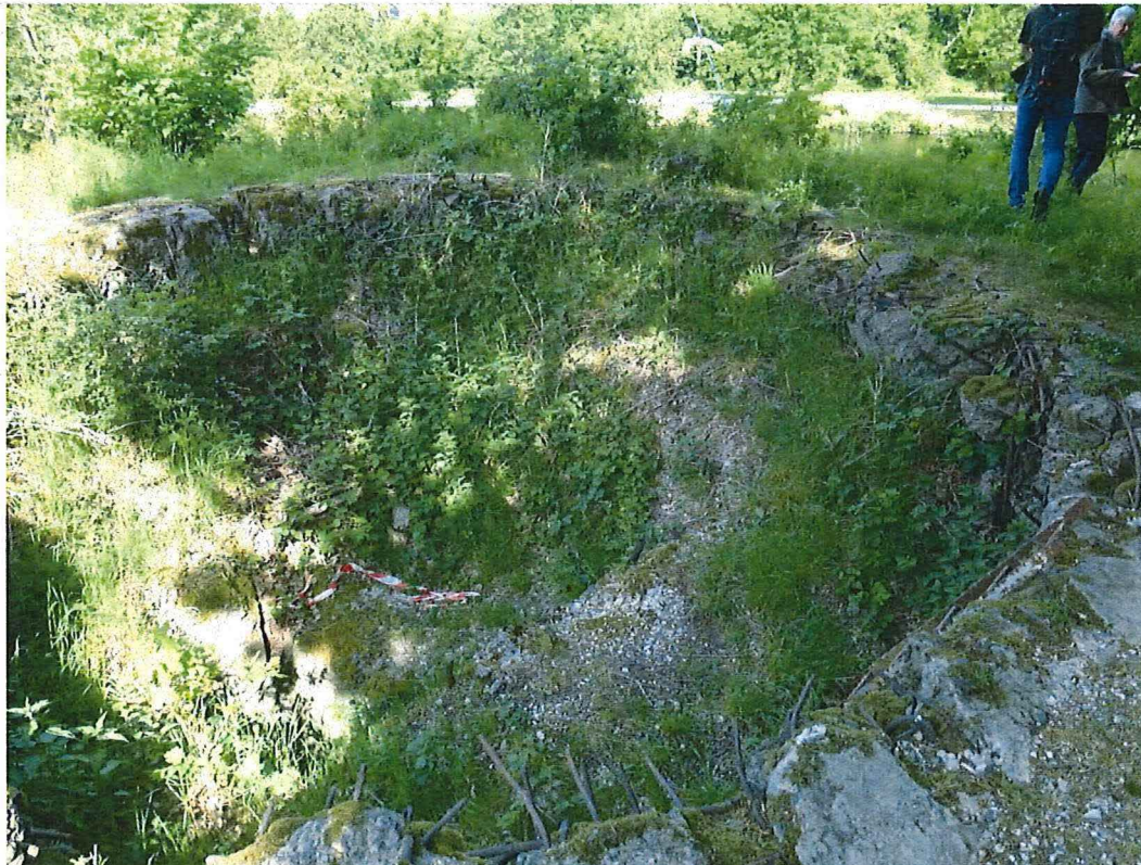
50. Saillant 1, bovenzijde: het gewapend beton op de rand van de koepel zijn de resten van de torenbunker die in het interbellum bovenop de geschutkoepel is aangelegd, 22/05/2017.
