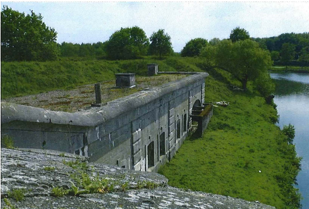
12. Zicht op het rechterkeelfrontgebouw, vanaf het dak van de traditorebatterij. Het blinde muurtje centraal in de foto schermt de toiletten van de (onder)officieren tegen inkijk af. Boven op het dak zijn de ventilatieschachten zichtbaar, 21/05/2016.
