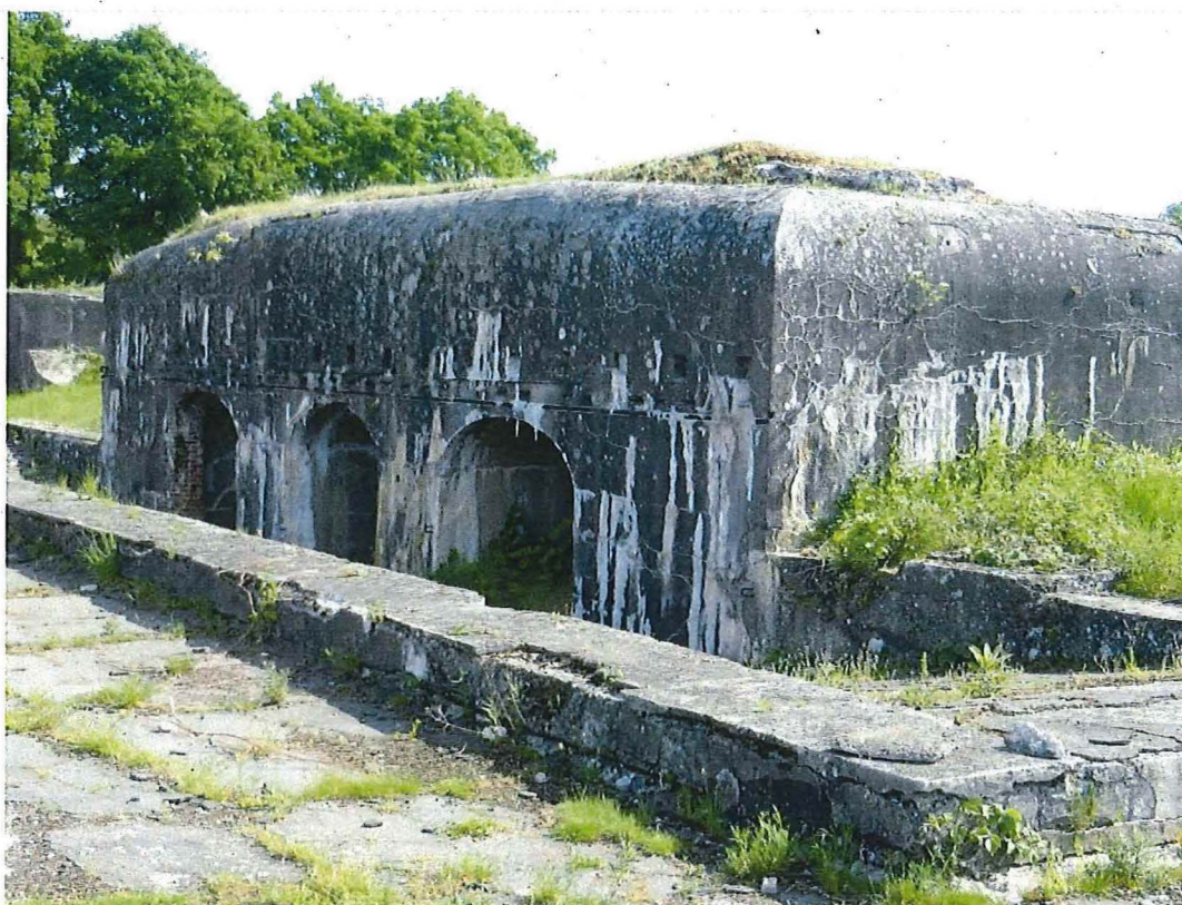
33. Centrale geschutskoepel, achterzijde: in de drie opening stond mobiele artillerie die boven op het fort kon worden geplaatst. Elke poort was afgedekt met een zijdelings verplaatsbare metalen schuifdeur, die intussen verwijderd is, 22/05/2017.
