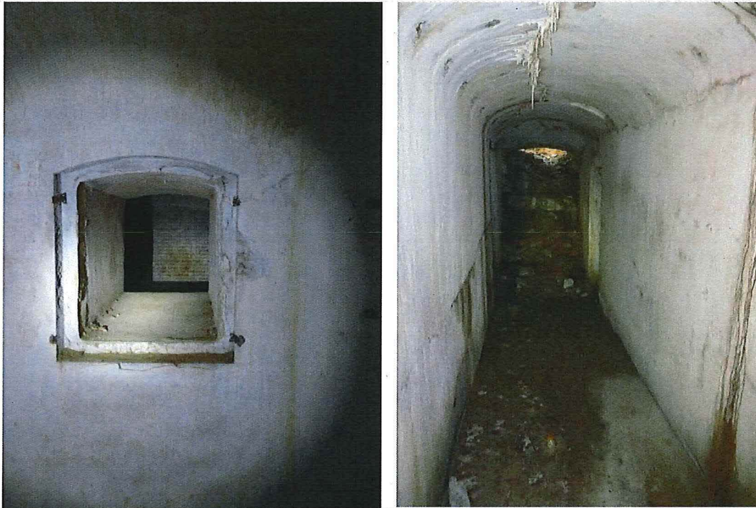
49. Caponnière corridor: links doorkijk vanuit de gang naar de achterliggende munitiekamer, rechts gang naar de 5,7cm geschutkoepel, 22/05/2016.
