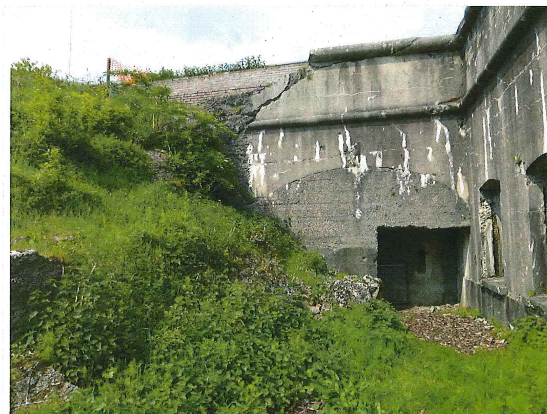
20. Centrale verbinding tussen het keelfront- en het hoofdfrontgebouw met zicht op het magazijn dat een inslag te verwerken kreeg. Een recent gemetst muurtje sluit het dak af. Daarboven staan zonnepanelen geplaatst, 21/05/2016
