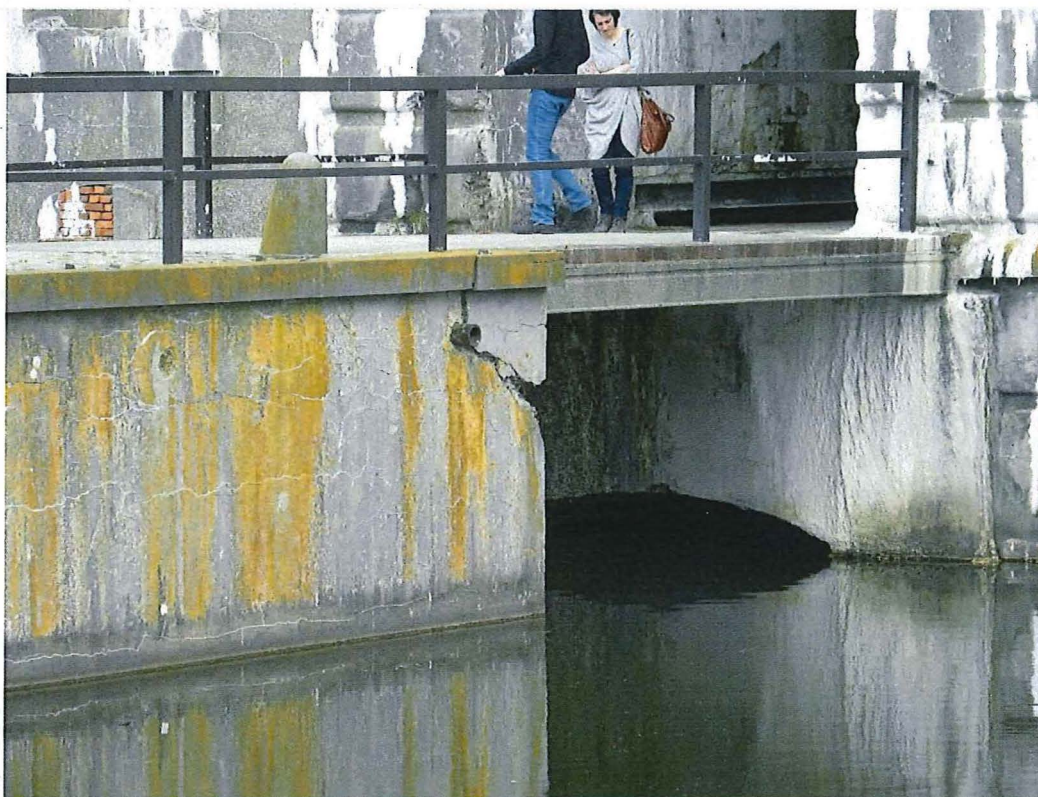
3. Dam en brug boven de vestinggracht bij de toegang tot het fort. De balustrade van de brug is niet origineel, geplaatst in de jaren 1970. De horizontale 'gleuven' boven de brug geven de positie van de mobiele brug aan, 12/05/2017.
