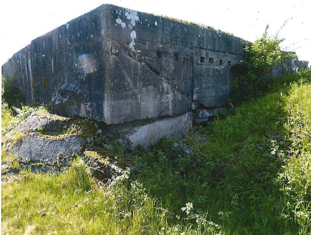
38. Saillant 3, achterzijde: let op de horizontale bouwnaad onderaan de saillant (gebarsten): het onderste gedeelte behoorde tot de bouwwerken van de privéfirma Bolsée, terwijl de geschutkoepel omwille van het strategische belang door de militairen werd aangelegd: 12/05/2017.
