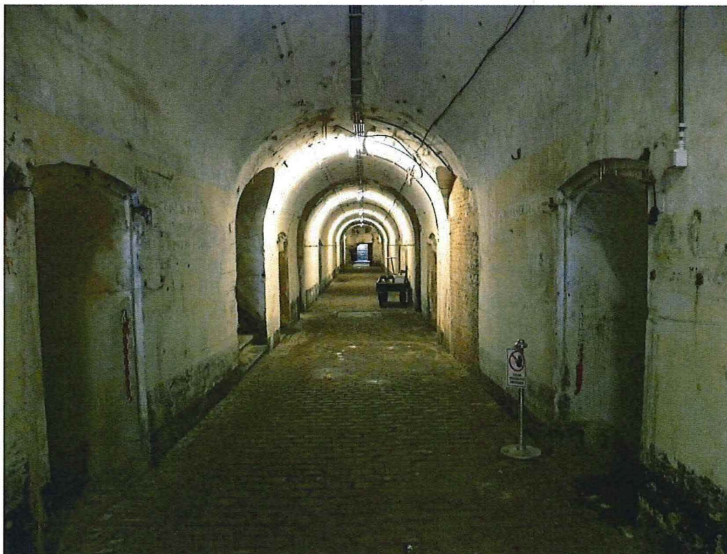
8. Poterne tussen het keelfrontgebouw en de centrale geschutskoepel. De kasseien zijn origineel, maar opnieuw gelegd. Links op de foto naast de deur zijn muuropschriften zichtbaar, 12/05/2017.
