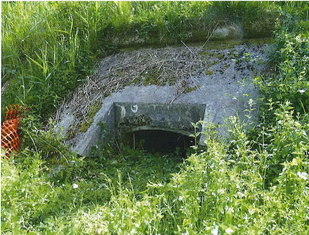
51. Saillant 1: ventilatiegang aan het keelfront van het forteiland, 22/05/2017.
