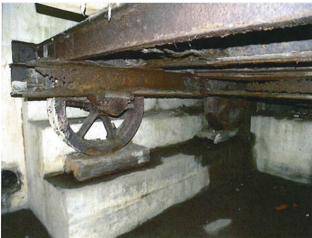
5. Mobiele brug om de toegang tot het fort te kunnen onderbreken. Bevindt zich in de brugzaal van de traditorebatterij, 12/05/2017.
