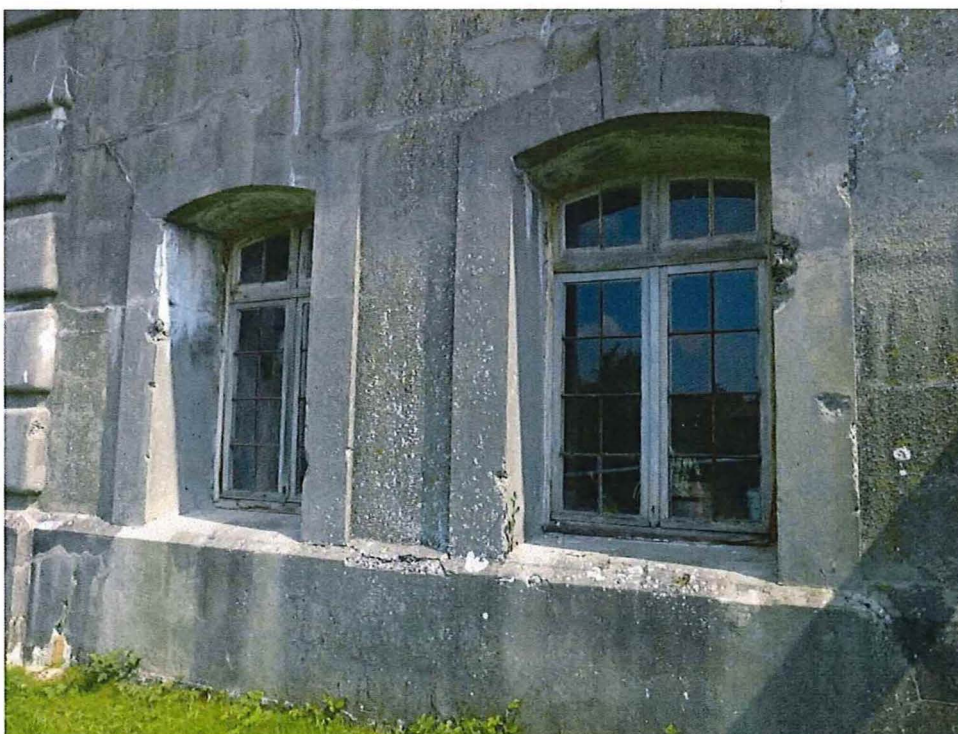
19. Buitengevel van het rechterkeelfrontgebouw. Het schrijnwerk is nog origineel. Kenmerkend zijn de omlijstingen als ornamentiek rond de raamopeningen in de betongevel, 21/05/2016.
