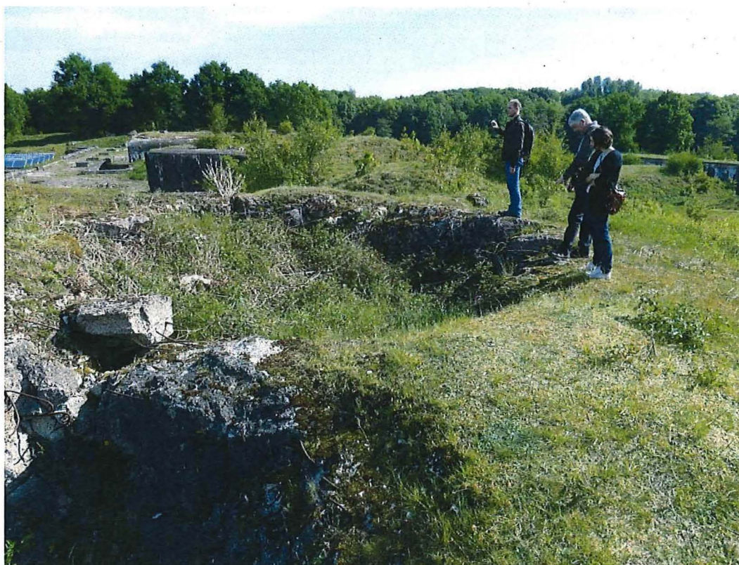
37. Saillant 3, bovenzijde: resten van de 7,5cm geschutskoepel op saillant 3. De wapening in het beton geeft aan waar de bunker tijdens het interbellum over de geschutskoepel werd gelegd, 22/05/2017.
