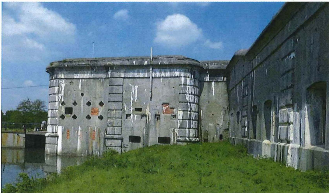
9. Zijkant van de traditorebatterij. Kort boven de waterspiegel bevindt zich de benedenverdieping, met (links) drie dichtgemetste schietgaten, (midden) kanonkamer met twee gaten voor snelvuurkanonnen van 5,7cm, (achteruitspringend gedeelte) petroleumopslagplaats. De bovenverdieping telde (links) een kanonkamer met twee 7,5cm kanonnen, (midden) een kanonkamer met twee 12cm kanonnen en (achteruitspringend gedeelte) een projector waarvan de opening dichtgemetst en bepleisterd is. Het materieel is verwijderd, maar in de muur zijn de gaten met de verankeringen van de plaataffuiten nog goed zichtbaar, 21/05/2016.
