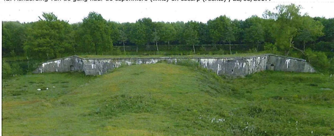
43. Caponnière met schietgaten, gaten voor 5,7cm snelvuurkanonnen en oreillon (schuinaflopnd). Centraal op de voorgrond bevindt zich de aangeaarde ondergrondse galerij naar de caponnière. In de achtergrond, achter de eerste bomenrij is het steile contrescarp zichtbaar, 21/05/2016.
