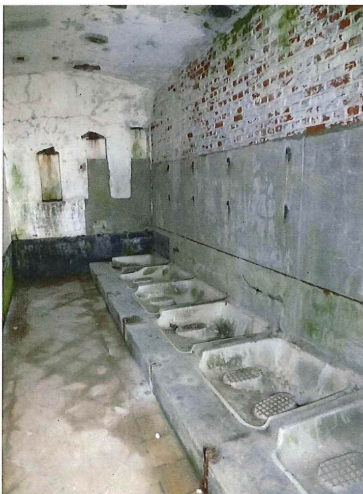
18. Rechterkeelfrontgebouw Toiletten voor de gewone manschappen. Deze Franse toiletten zijn geplaatst in het interbellum en vervangen de originele 'Turkse toiletten', 21/05/2016.
