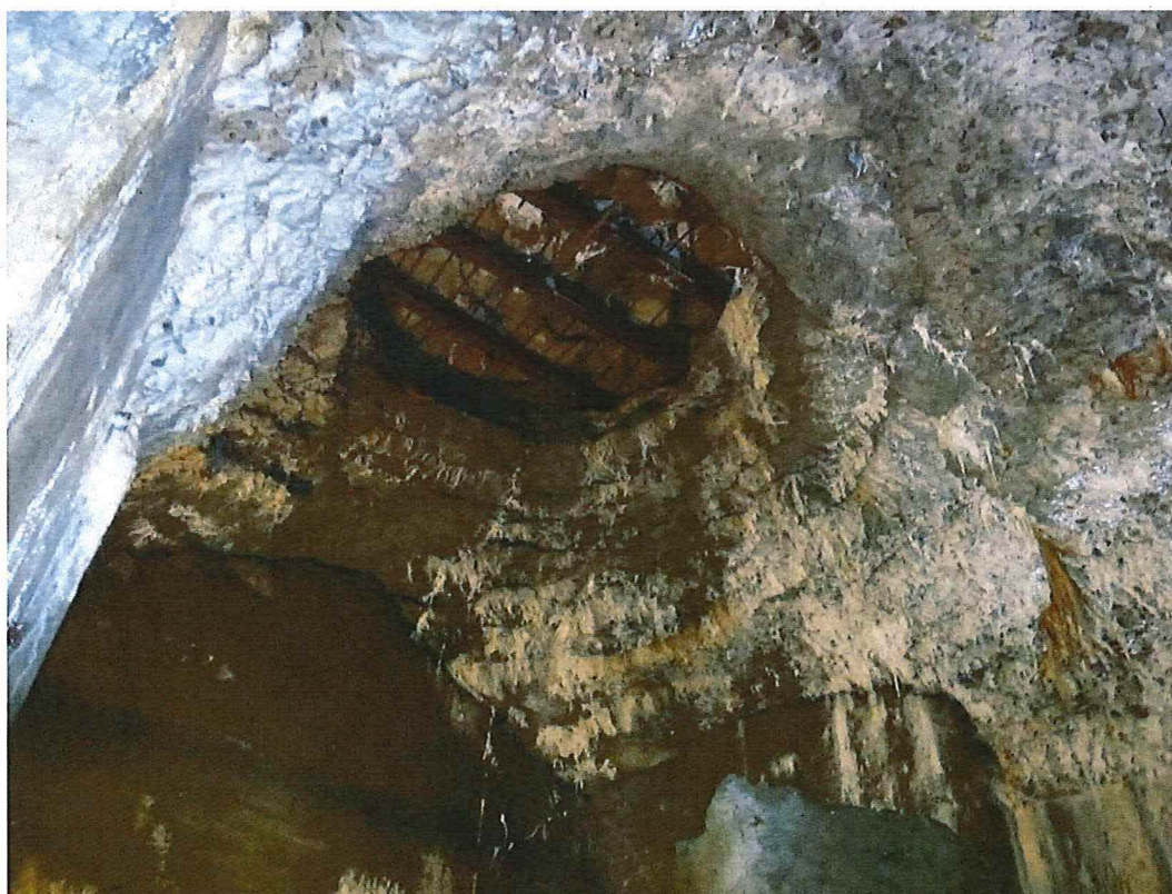
21. Hoofdfrontgebouw, kamer van de commandant: inslag waarbij het gewelf volledig werd doorboord. Sinds 1914 was deze ruimte dichtgemetst en afgesloten. In 2014 groeven vrijwilligers de massa puin weg, 21/05/2016.
