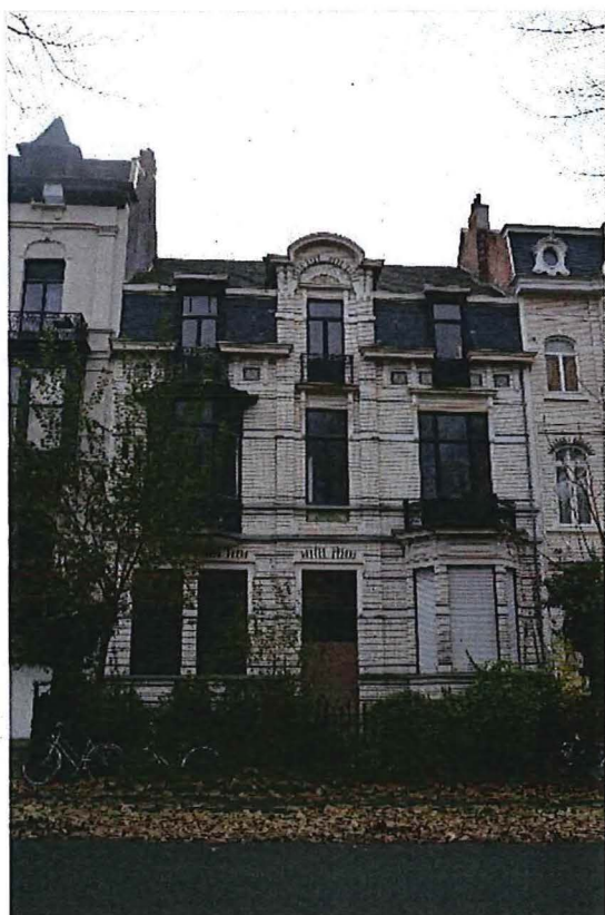
Foto 66: Parklaan nummer 33, voorgevel (09/12/2016).
