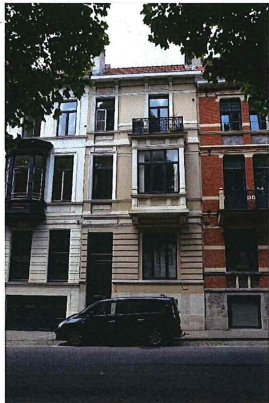
Foto 40: Parklaan nummer 20-26, voorgevel (06/07/2016).
