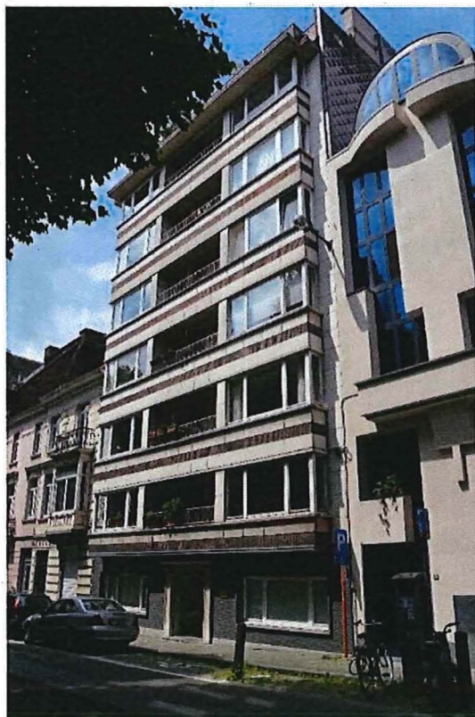
Foto 33: Parklaan nummer 44-72, voorgevel (06/07/2016).
