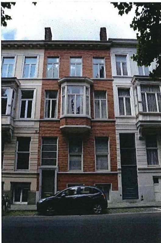
Foto 37: Parklaan nummer 32, voorgevel (06/07/2016).
