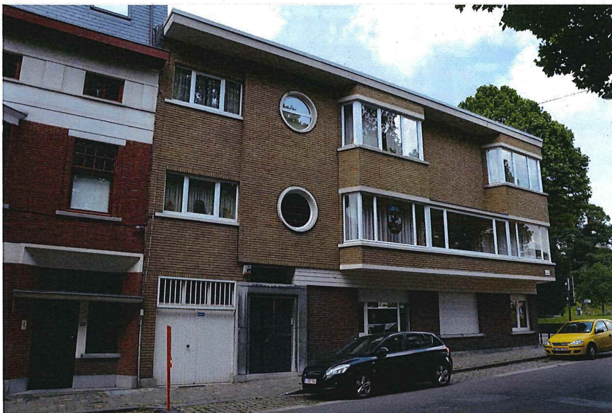
Foto 46: Hoekpand Parklaan nummer 2 - Fortlaan nummer 96 en 97, voorgevel aan de Parklaan (06/07/2016).
