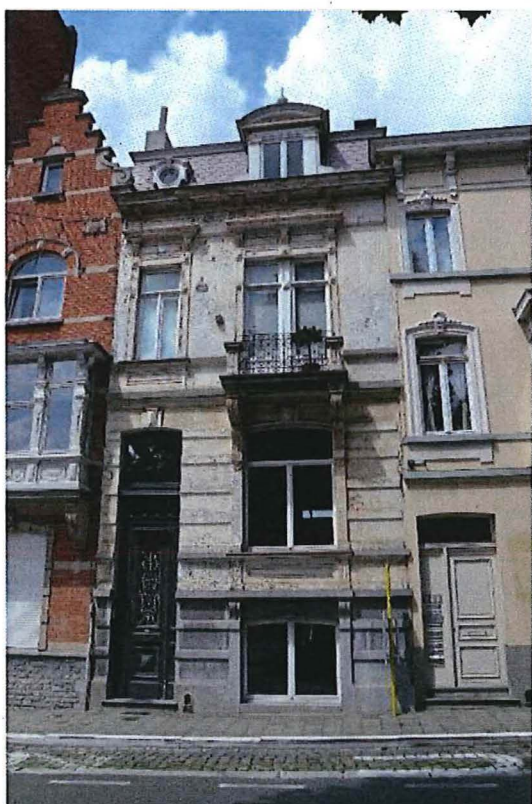
Foto 22: Parklaan nummer 96, voorgevel (06/07/2016).
