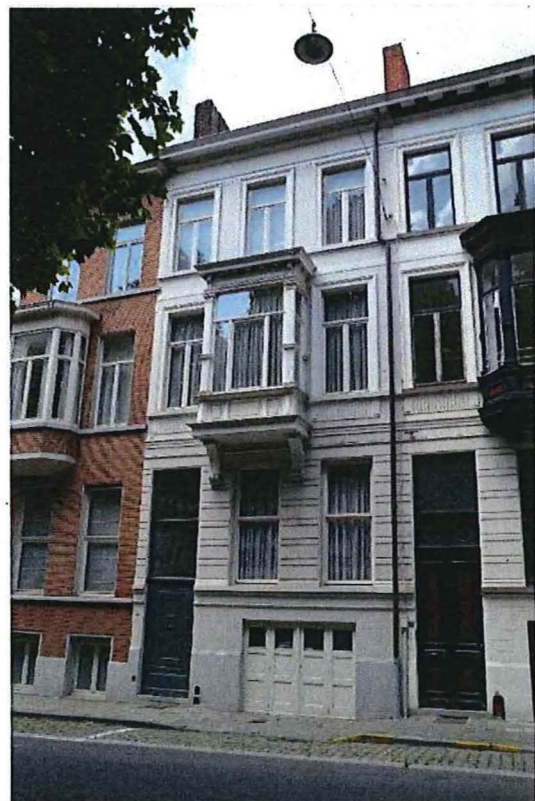
Foto 38: Parklaan nummer 30, voorgevel (06/07/2016).
