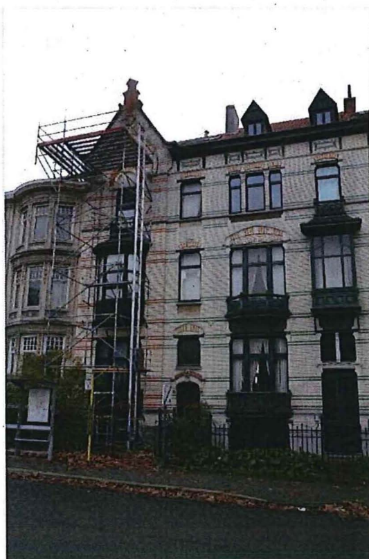
Foto 74: Parklaan nummer 5, voorgevel (09/12/2016).
