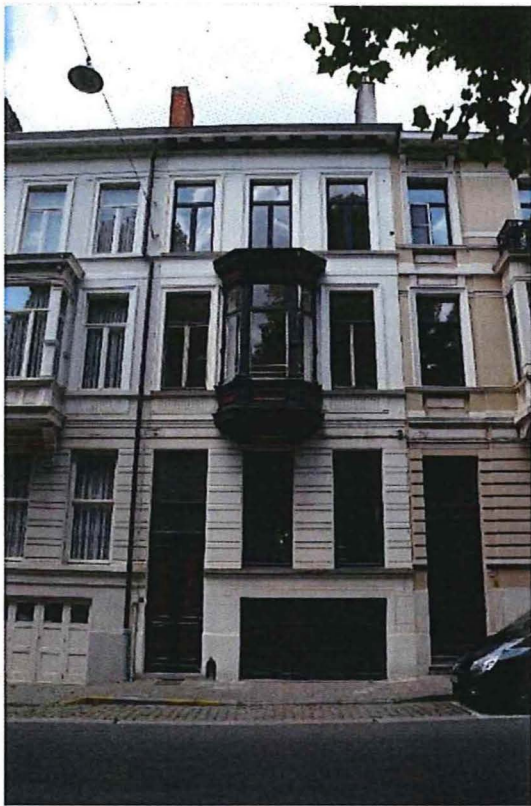
Foto 39: Parklaan nummer 28, voorgevel (06/07/2016).
