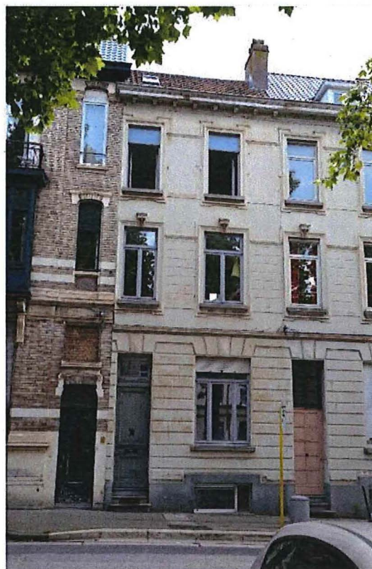
Foto 52: Parklaan nummer 127, voorgevel (06/07/2016).
