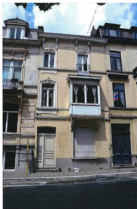
Foto 23: Parklaan nummer 94, voorgevel (06/07/2016).
