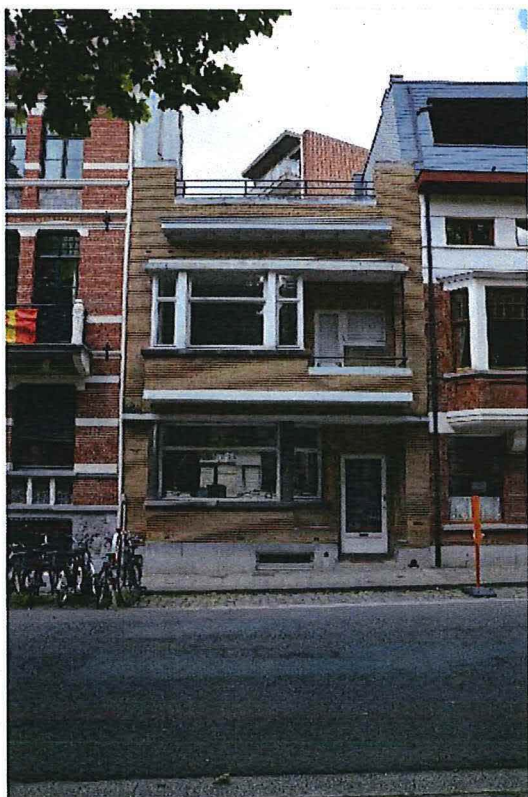
Foto 44: Parklaan nummer 6, voorgevel (06/07/2016).
