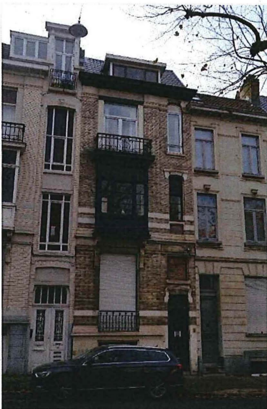
Foto 55: Parklaan nummer 123, voorgevel (09/12/2016).
