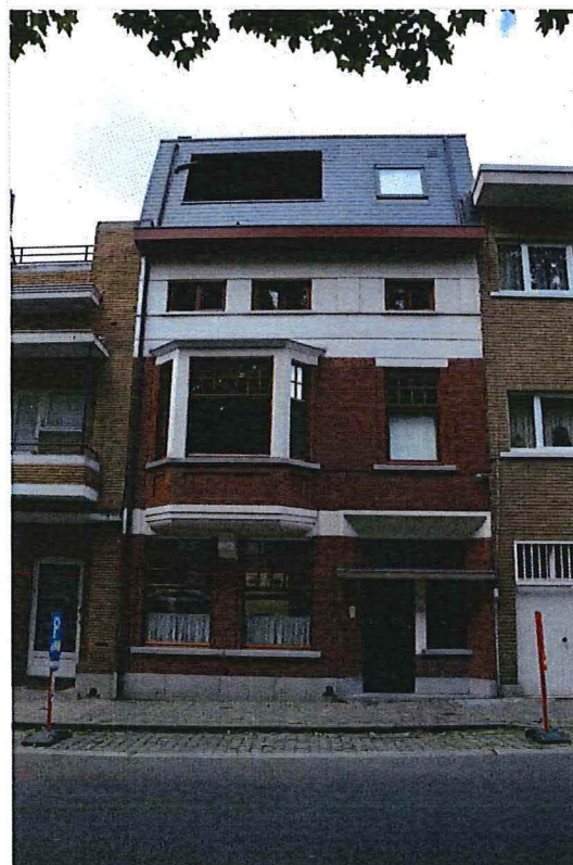
Foto 45: Parklaan nummer 4, voorgevel (06/07/2016).
