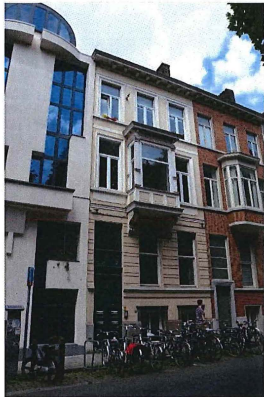
Foto 36: Parklaan nummer 34-40, voorgevel (06/07/2016).
