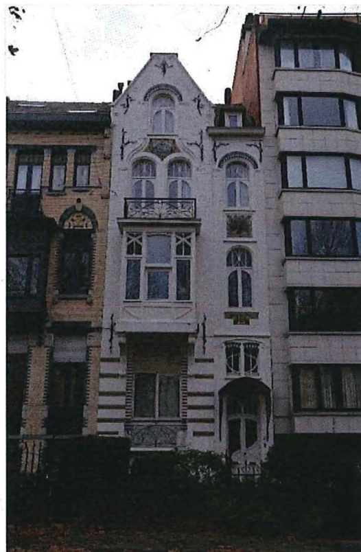
Foto 60: Parklaan nummer 39, voorgevel (09/12/2016).
