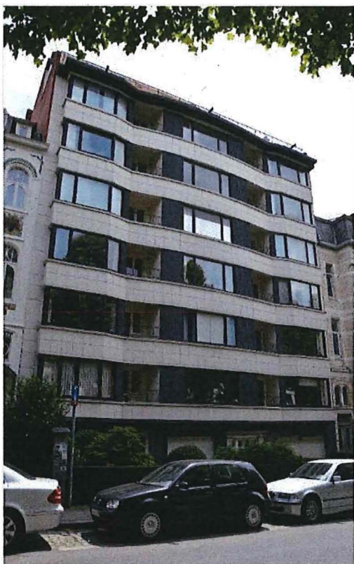
Foto 59: Parklaan nummer 41-81, voorgevel (06/07/2016).
