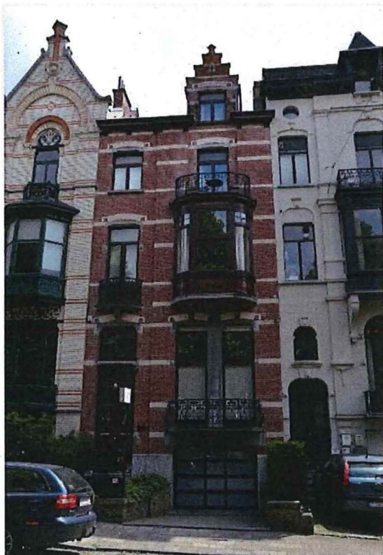
Foto 68: Parklaan nummer 25, voorgevel (06/07/2016).
