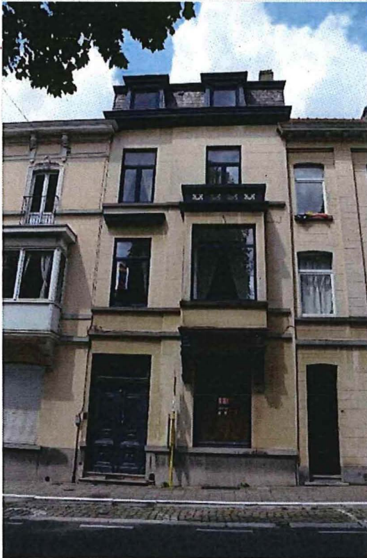
Foto 24: Parklaan nummer 92, voorgevel (06/07/2016).
