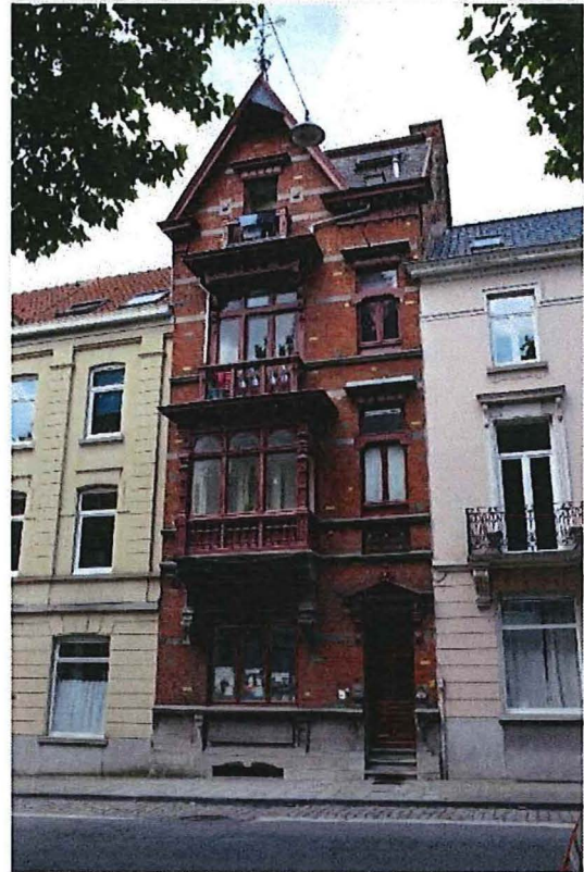
Foto 29: Parklaan nummer 80, voorgevel (06/07/2016).
