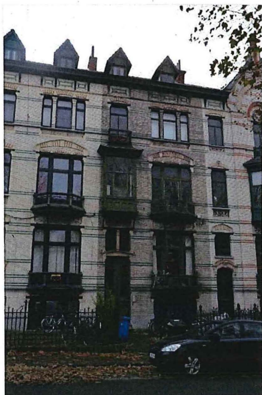
Foto 70: Parklaan nummer 17-19, voorgevel (09/12/2016).
