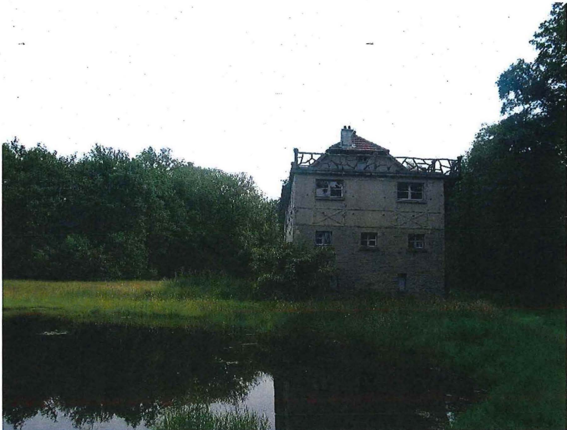
Foto 4: Zijgevel met balkon met cementrustieke balustrade
