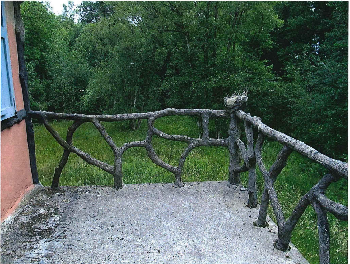
Foto 26: Detail balustrade balkon langs voorgevel
