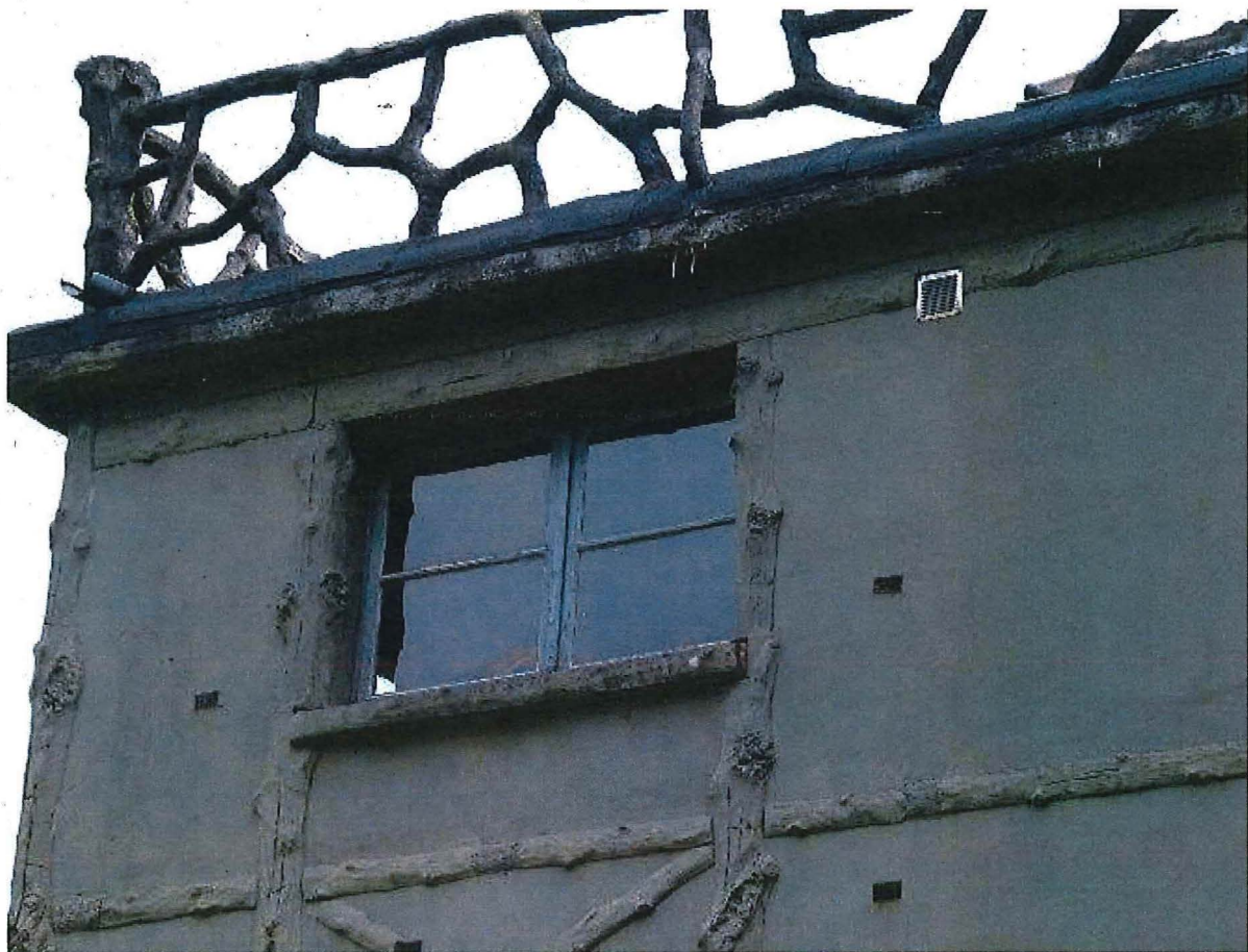
Foto 23: Détail balustrade, schrijnwerk en cementrustiek
