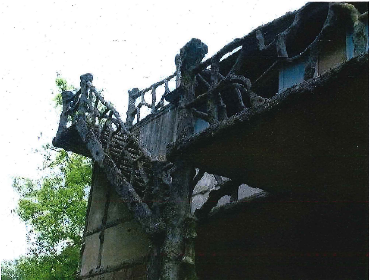
Foto 16: Detail cementrustieke balustrade bij trap en balkon
