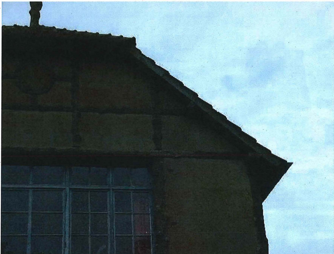
Foto 22: Detail cementrustiek: imitatie vakwerk en boomstammen
