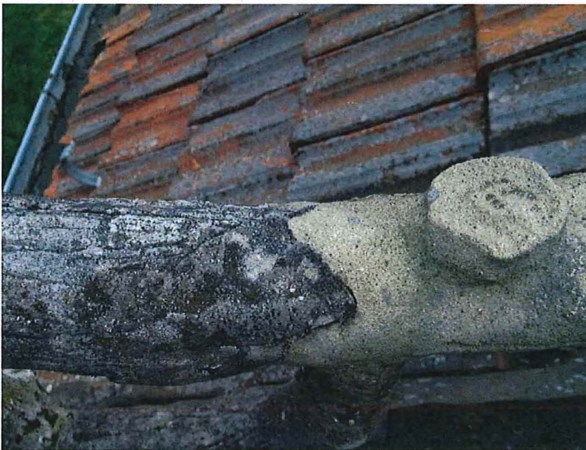
Foto 29: Detail gerestaureerde cementrustiek Foto 30: Detail gerestaureerde cementrustiek
