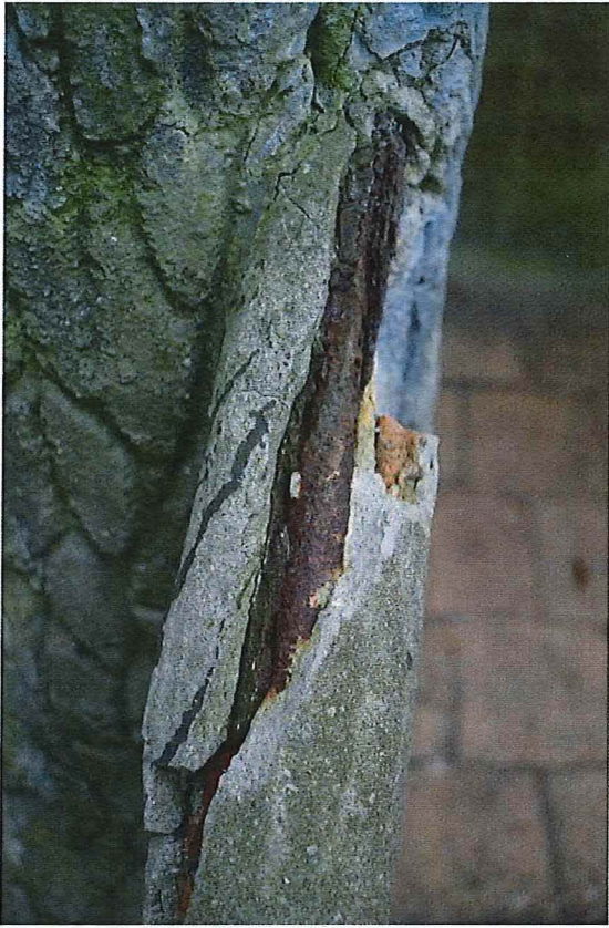
Foto 22: openluchtpreekstoel: leuning: schade door corroderende wapening
