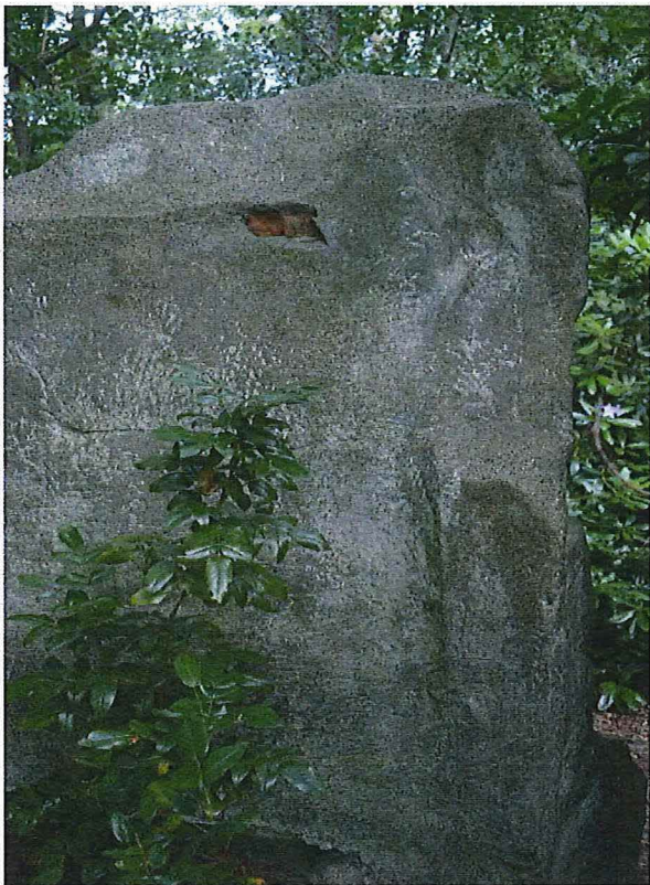
Foto 71: Kruisweg: achterzijde: spoor van bakstenen kernstructuur
