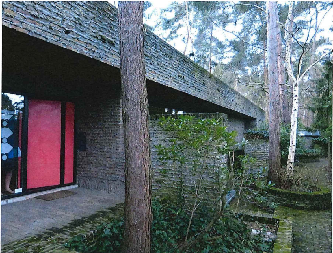
Foto 12: Rechterkant van de noordgevel
