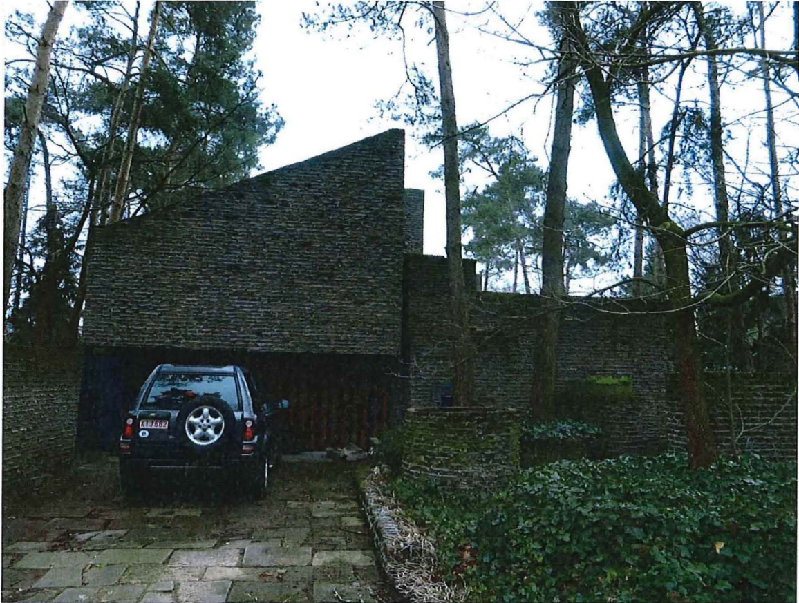
Foto 3: Westgevel met zicht op de oprit
