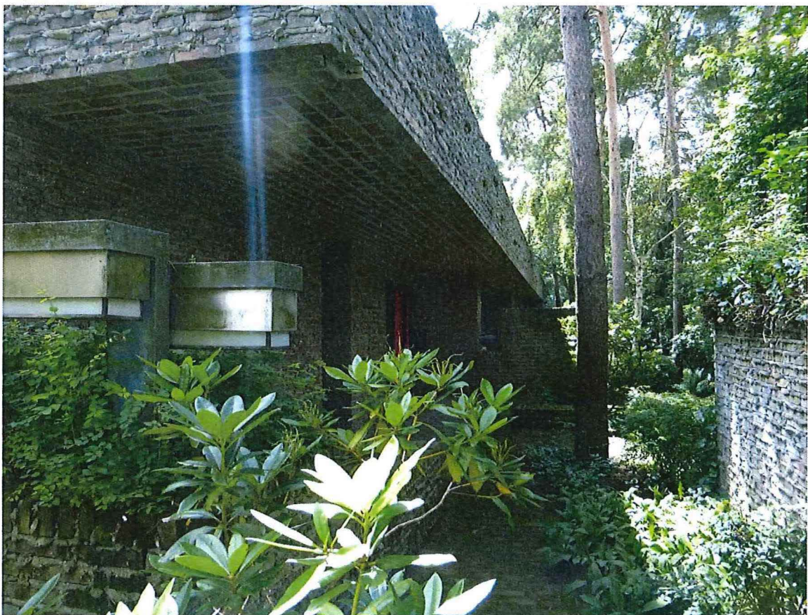
Foto 13: Linkerkant van de noordgevel
