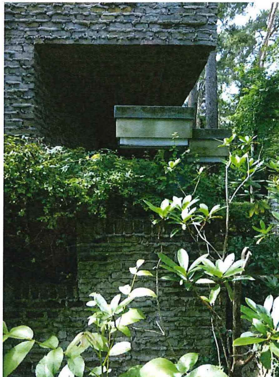
Foto 29: Oostgevel detail met verlichtingselement
