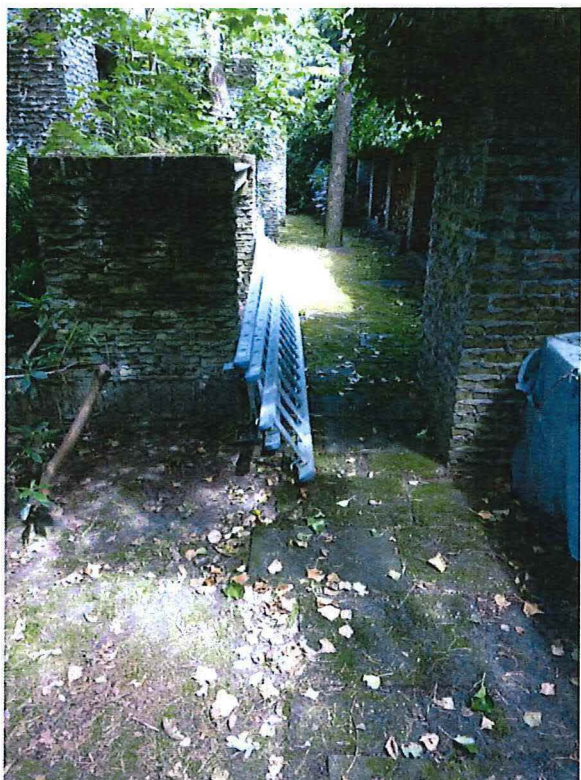
Foto 32: Tuinpad zuiden met houtopslag
