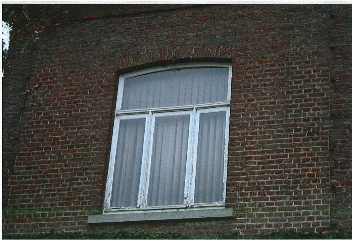
Foto 4: Detail van een raam in de voorgevel van de fruittelerswoning
