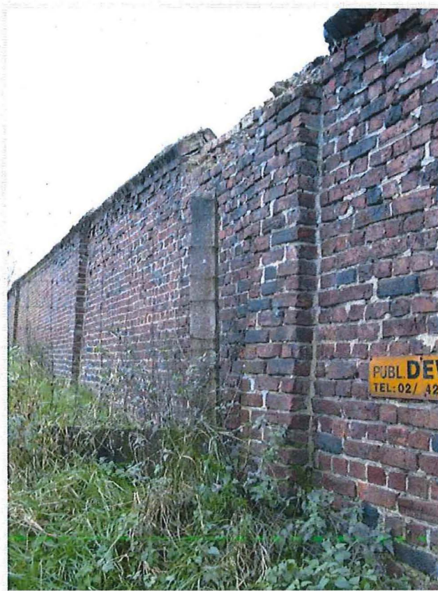
Foto 20: Deel van de westelijke omheiningsmuur, gezien vanuit de fruitweide
