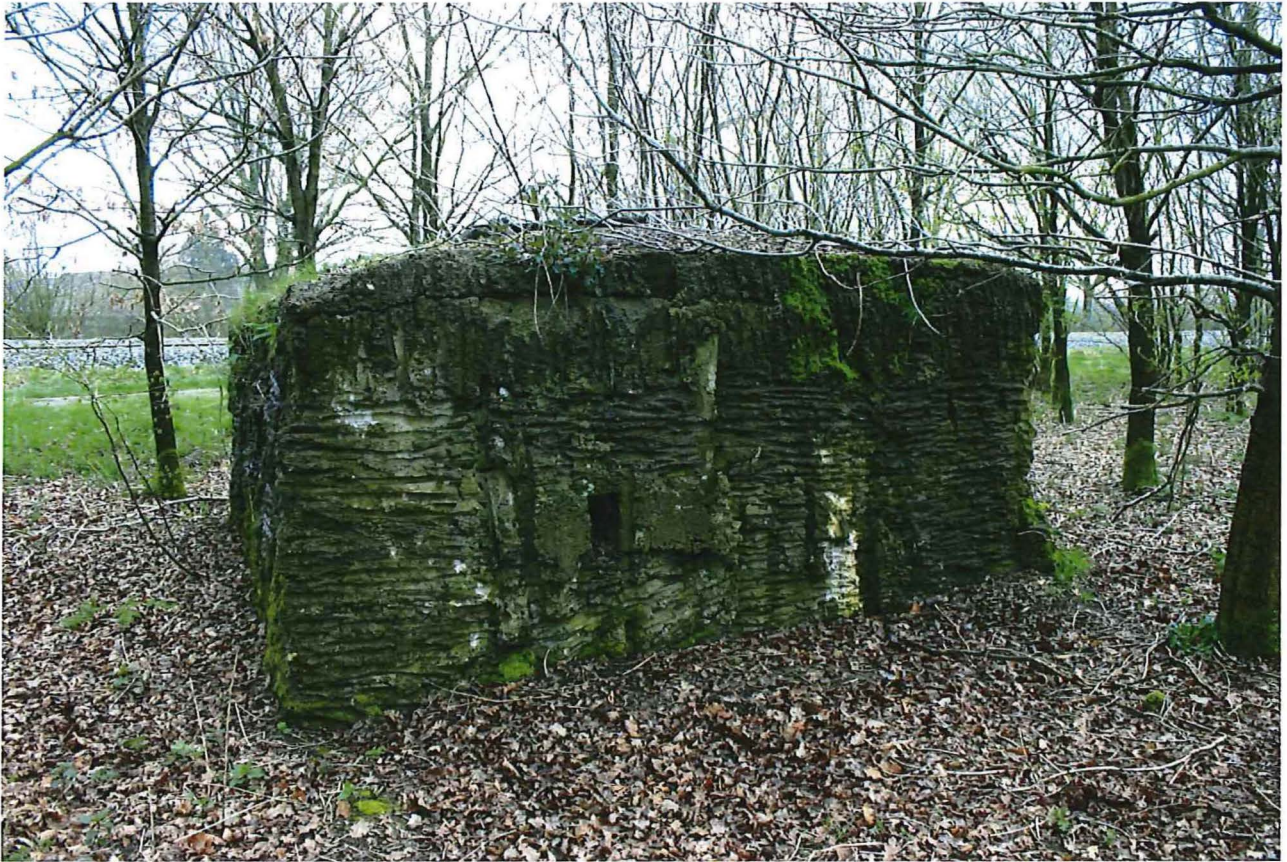
Foto 3: De noordelijke zijde van de bunker.
