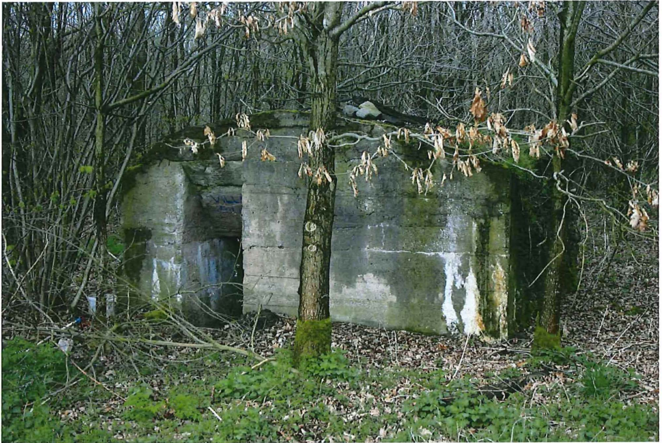
Foto 1: De zuidelijke zijde van de bunker.
