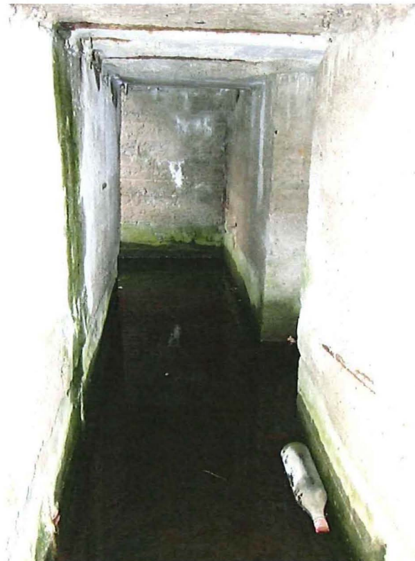
Foto 4: De gang van de bunker.
