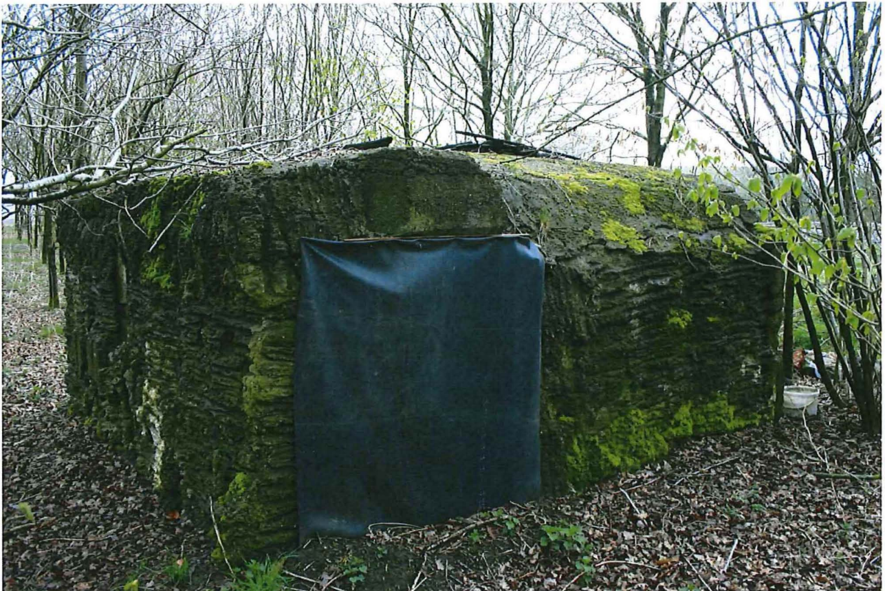
Foto 2: De westelijke zijde van de bunker.
