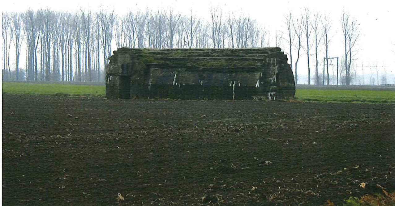
Foto 2: Ligging van de bunker, met op de achtergrond de spoorlijn Torhout-Brugge.
