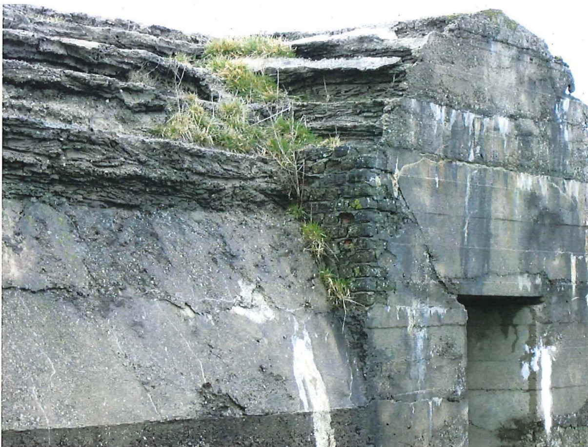
Foto 3: Bij de bouw van de bunker zijn ook bakstenen gebruikt.
