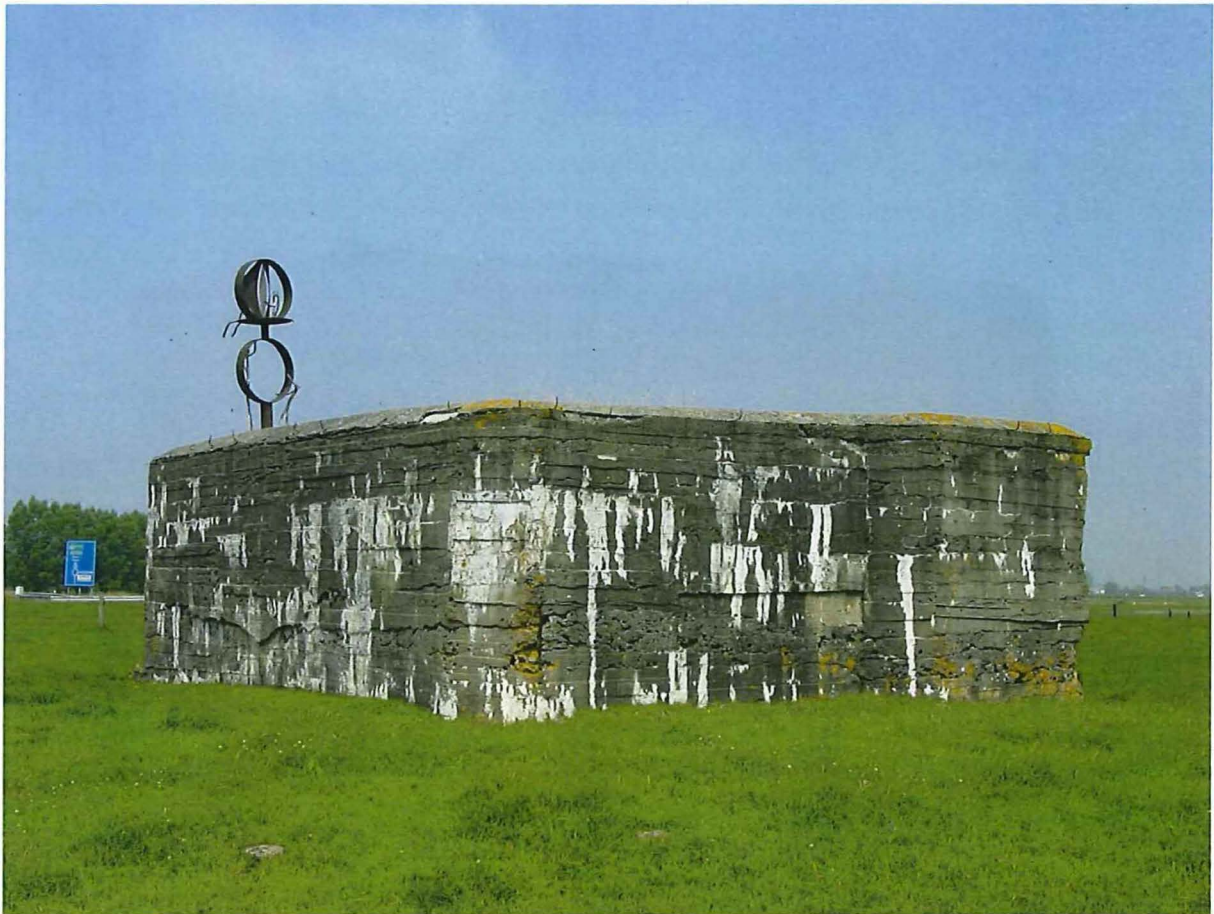
Foto 3: De zuidelijke en westelijke zijde van de meest noordelijke constructie. Tegen de dakrand zijn de ijzers voor de bevestiging van camouflagenetten te zien.
