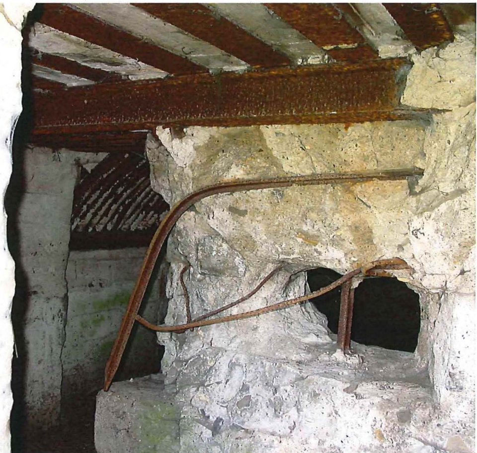
Foto 4: Zicht in de noordelijke bunker
