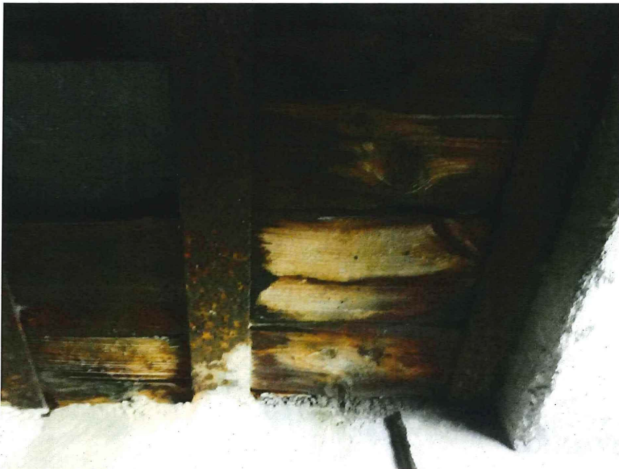
Foto 7: Bewaarde houten beplanking tussen de stalen profielen in het plafond van de bunker.
