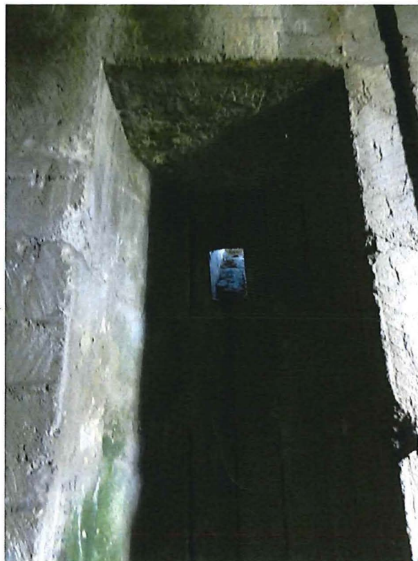
Foto 4: Een nis voor een kachel, met schuine opening voor rookafvoer.
