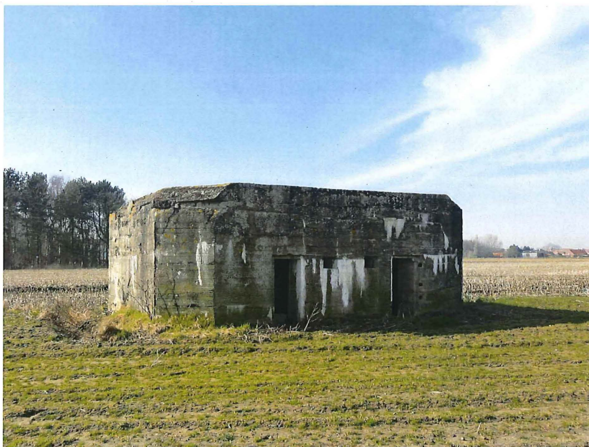
Foto 2: De toegangszijde (noordoostelijke zijde) van de bunker.
