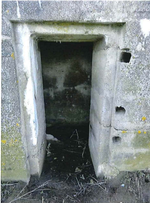
Foto 5: Een deuropening met ernaast uitsparingen, voor de bevestiging van een deur.
