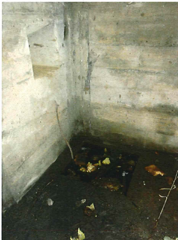
Foto 6: De opening in de vloer en in de tussenmuur.
