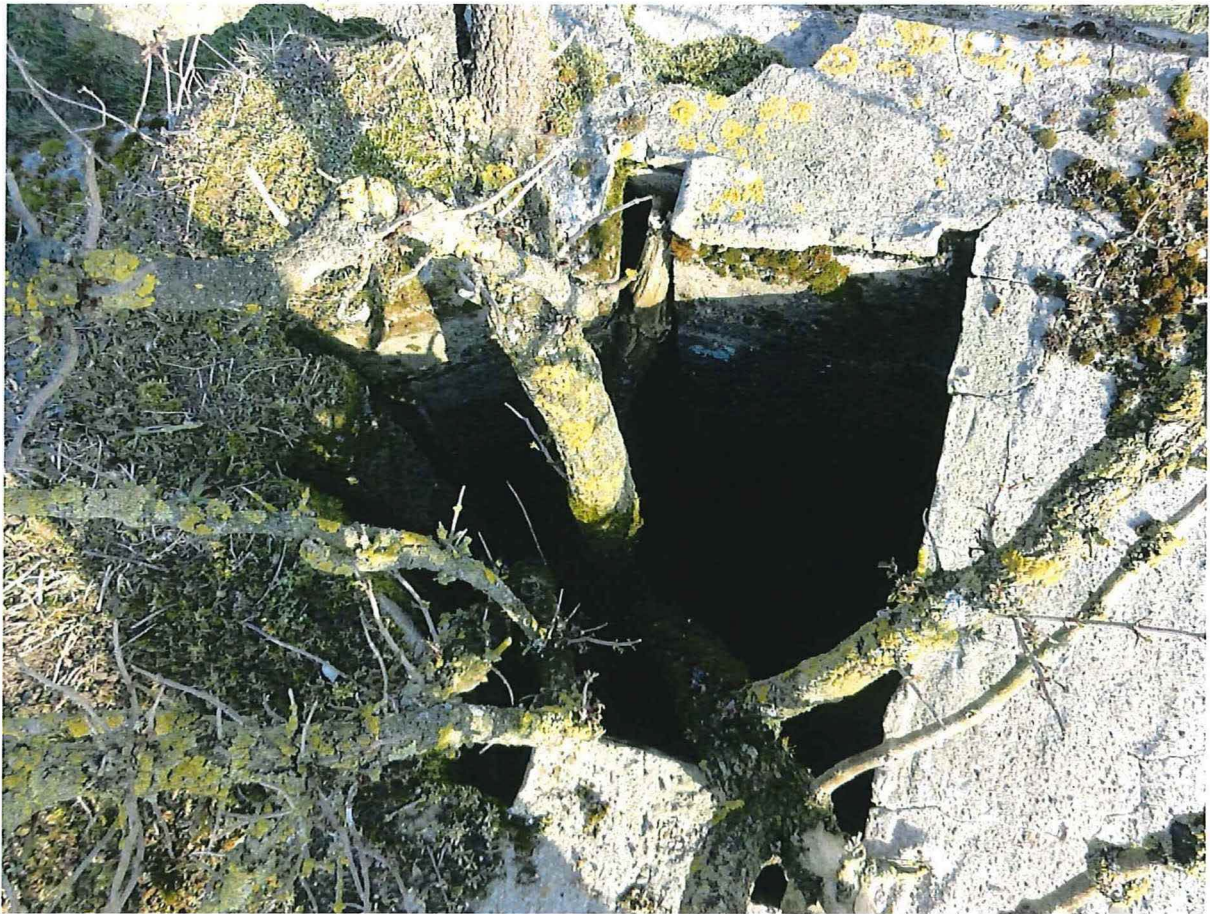
Foto 7: Het mangat, vanaf het dak.
