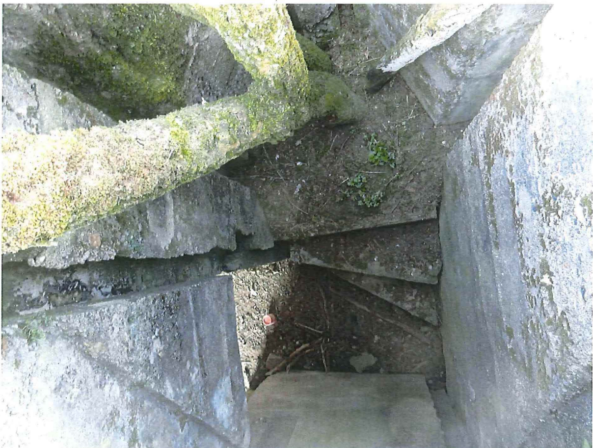
Foto 8: Zicht in het mangat, vanaf het dak.
