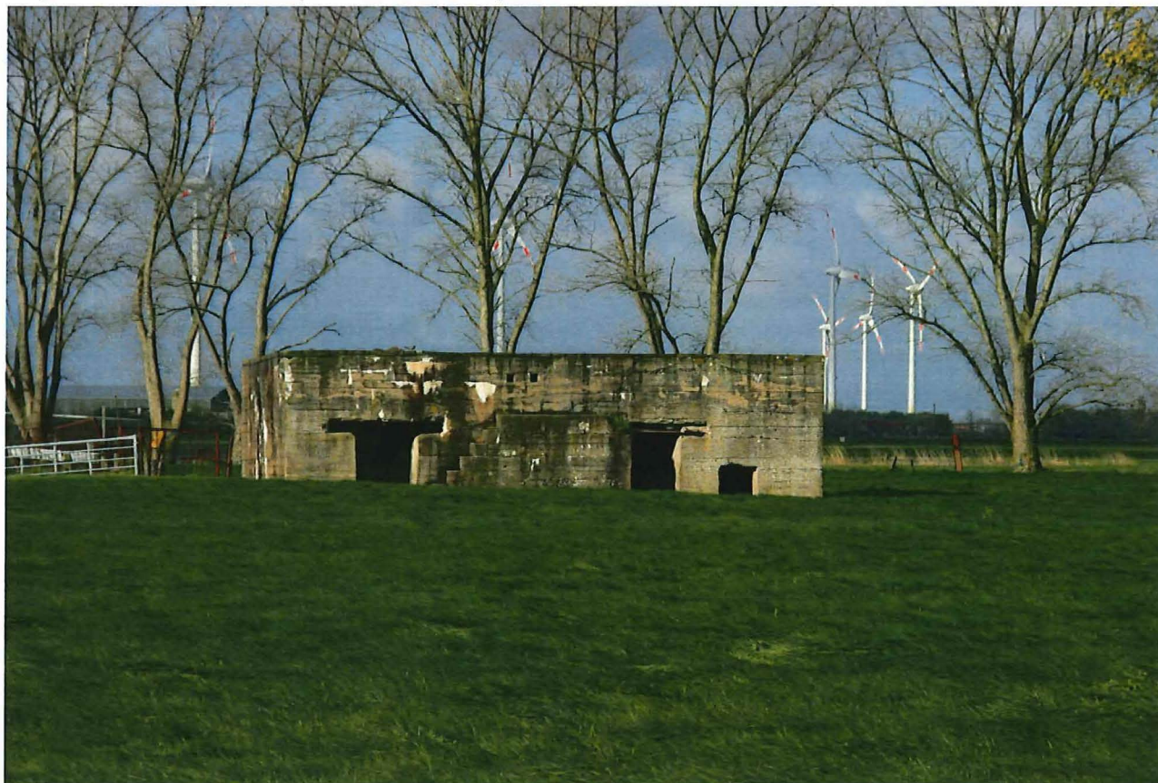
Foto 1: Zicht op de achterzijde van de bunker.
