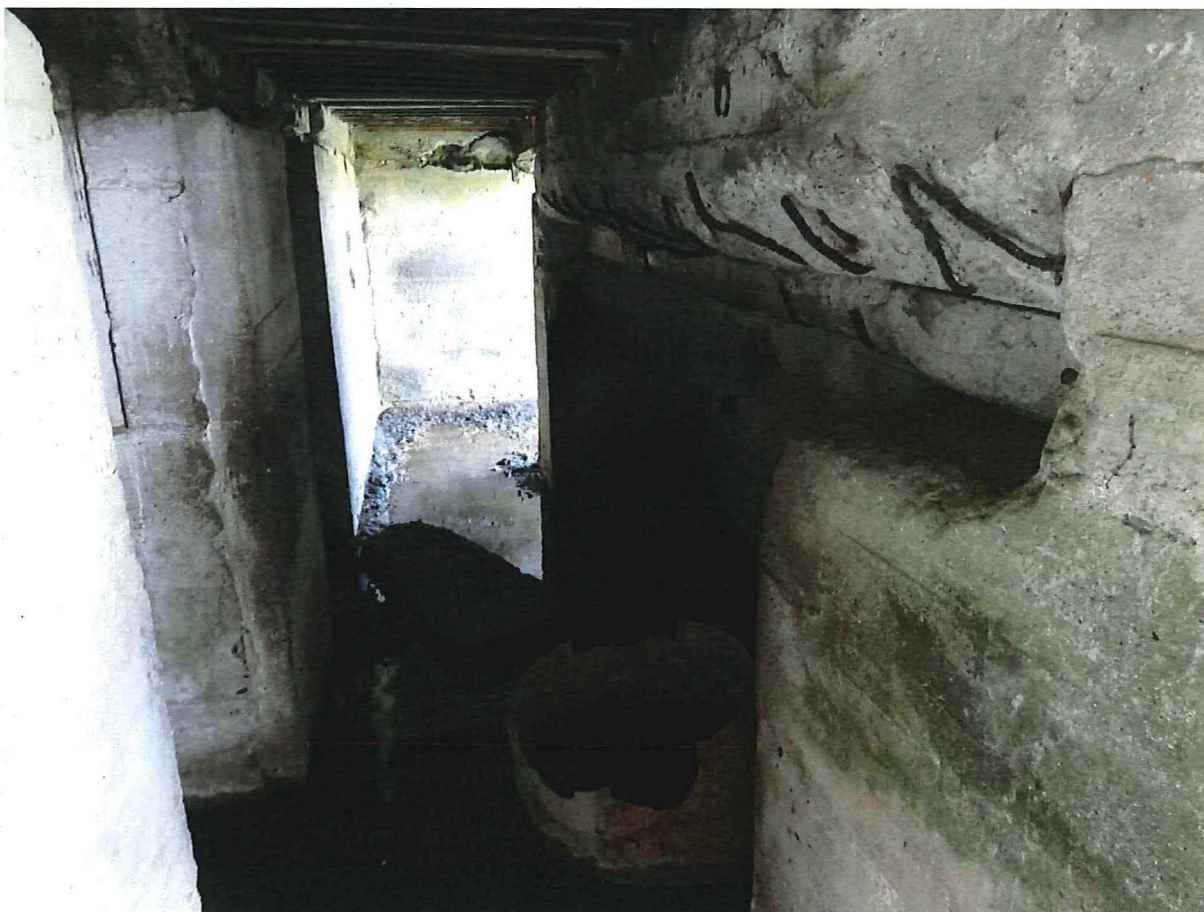
Foto 4: De gang van de bunker.
