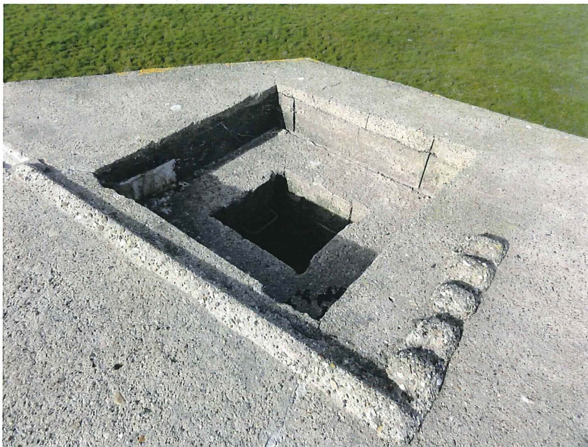
Foto 6: Het mangat met betonnen omranding.
