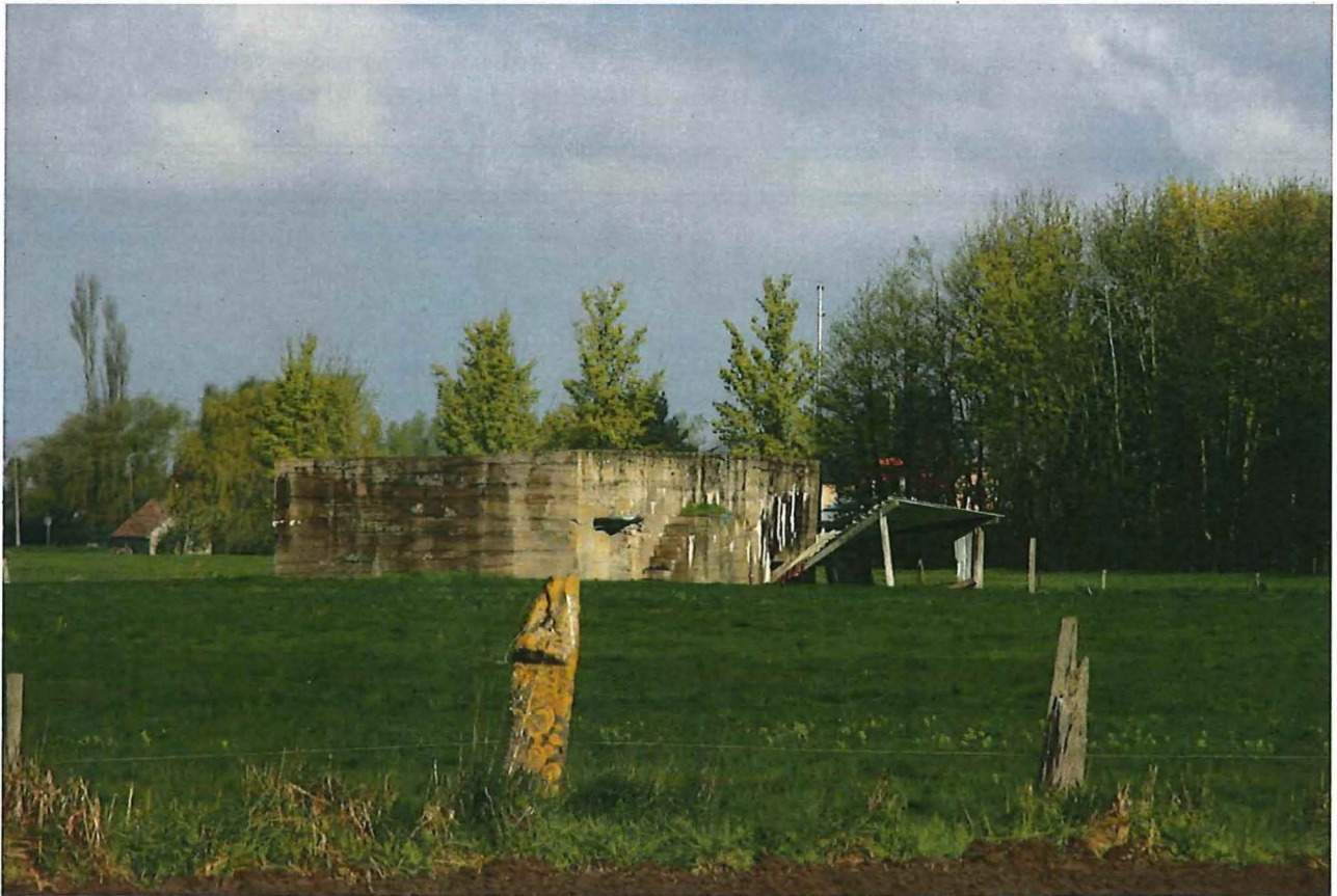
Foto 1: Ligging van de bunker.
