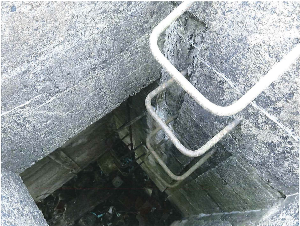
Foto 6: De bewaarde klimijzers in het mangat.
