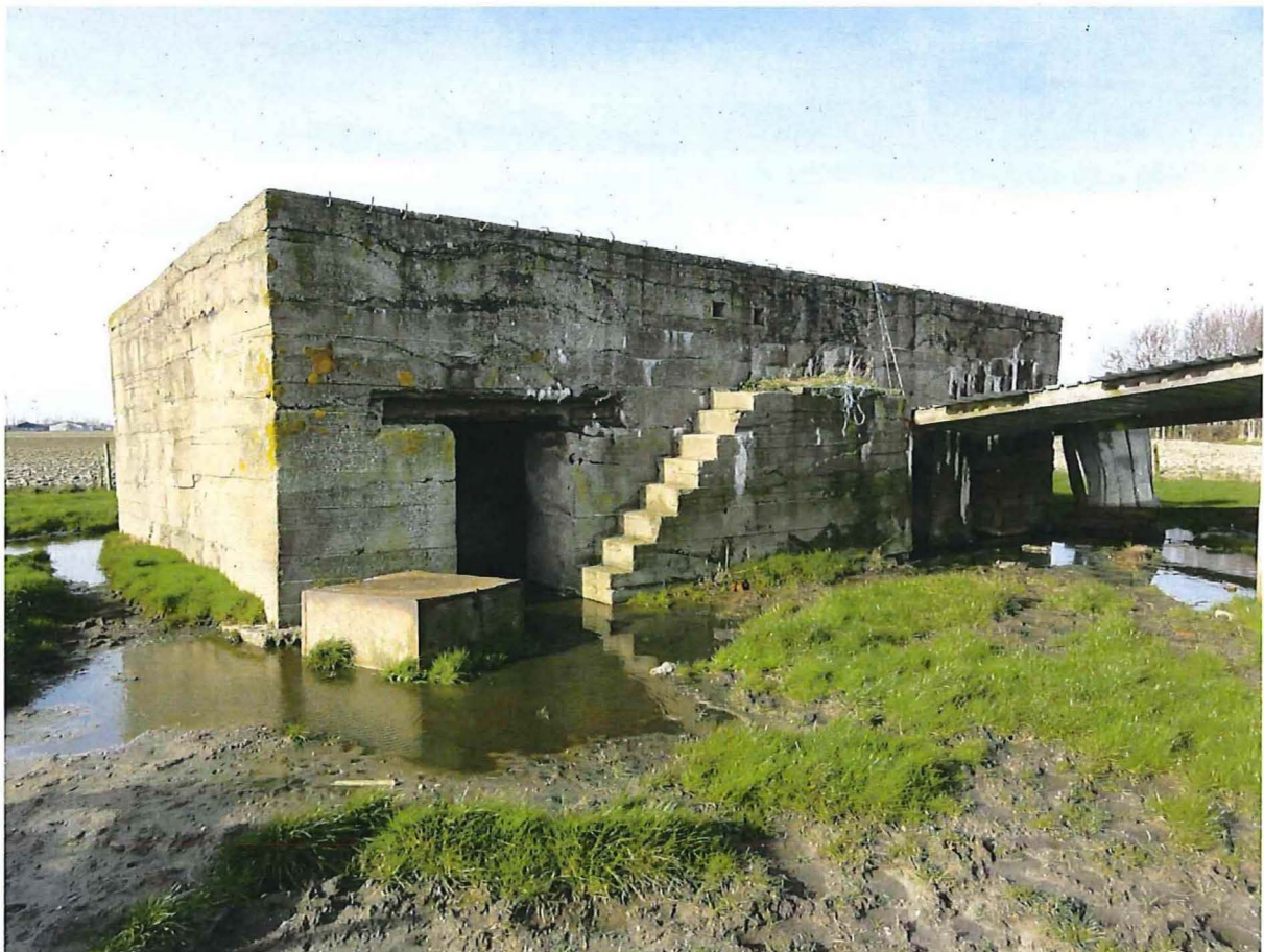
Foto 2: De toegangszijde (noordoostelijke zijde) van de bunker.
