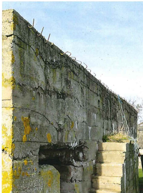
Foto 4: De ijzeren haken langs de dakrand.
