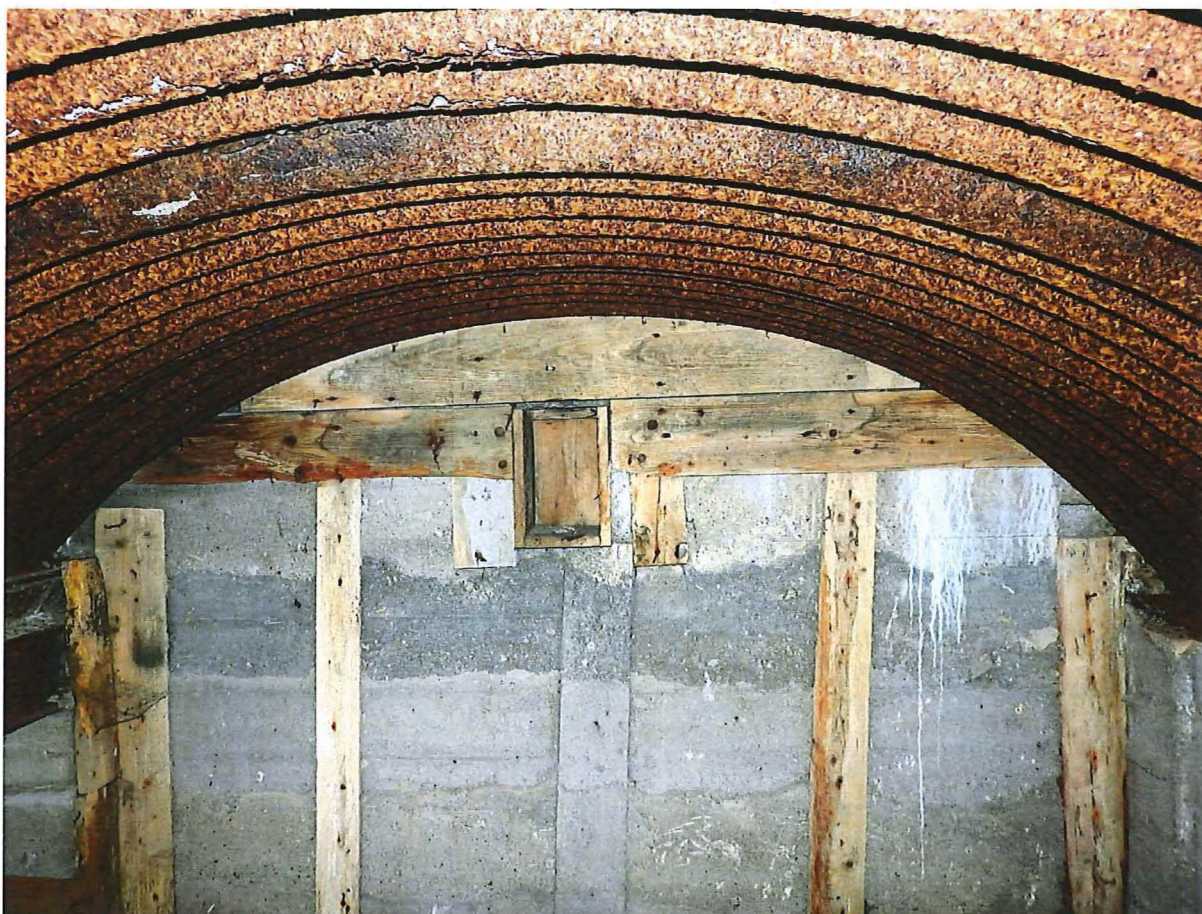
Foto 5: Houten nisje voor lamp in de rechtse ruimte. Het plafond van de ruimtes bestaat uit zogenaamde Wellblechbogen (gebogen gegolfd plaatijzers).
