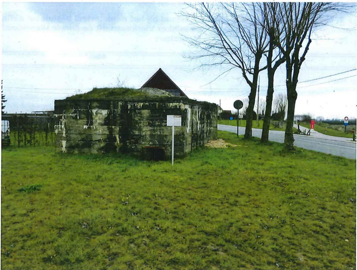
Foto 1: De bunker bij Vierkavenhoek vanuit zuidwestelijke richting.
