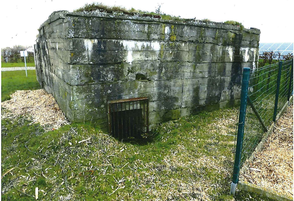
Foto 4: De noordoostelijke zijde van de bunker.
