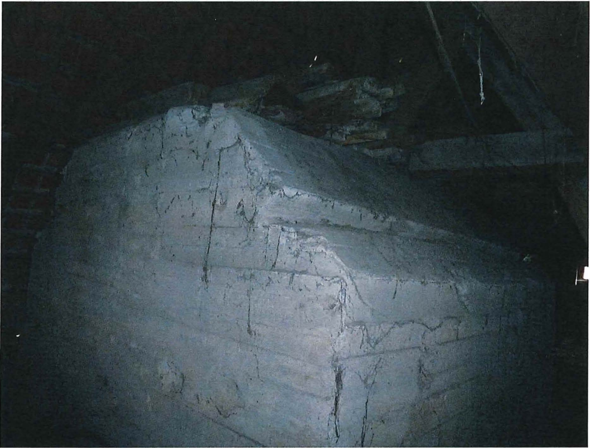
Foto 3: Een uitsparing van een gording in de betonnen dakrand.
