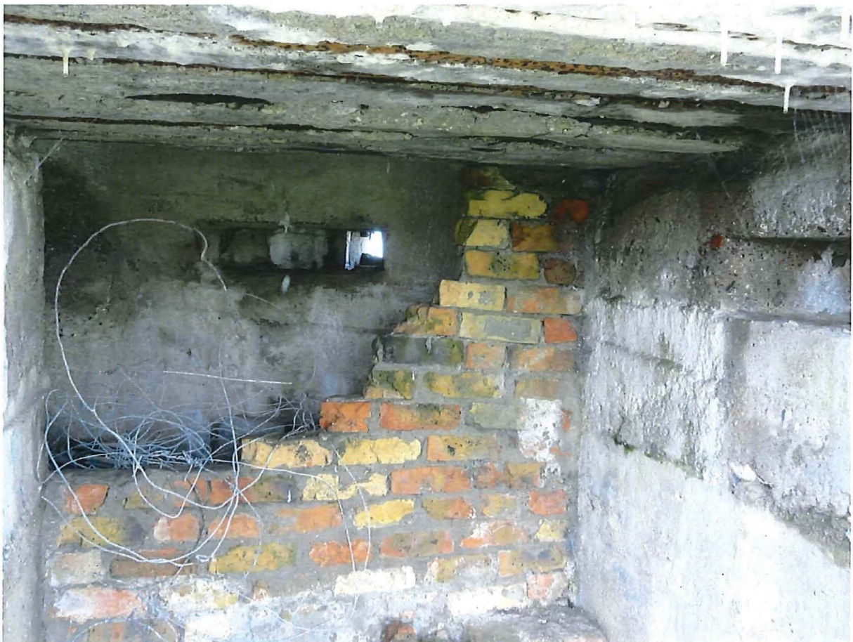
Foto 8: Schietopening aan de binnenzijde
