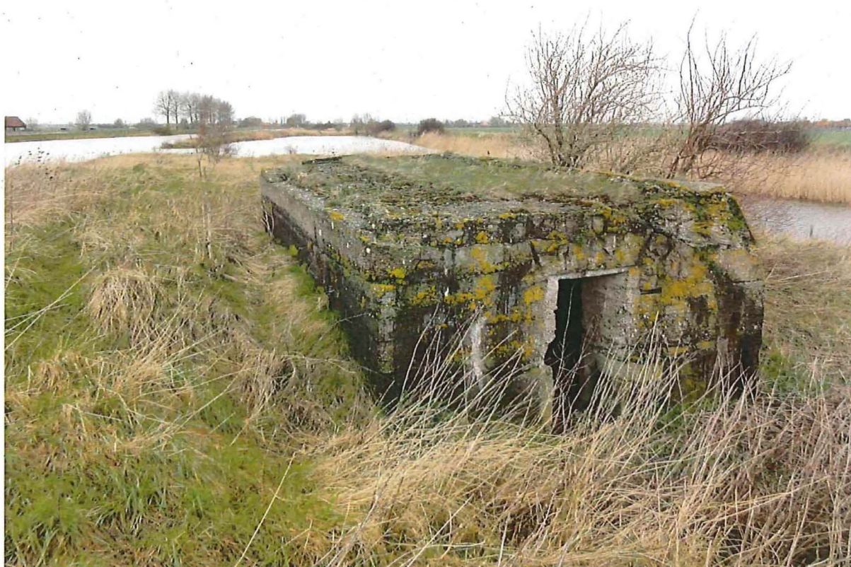
Foto 2: Zicht op de toegang van de bunker aan zuidoostelijke zijde
