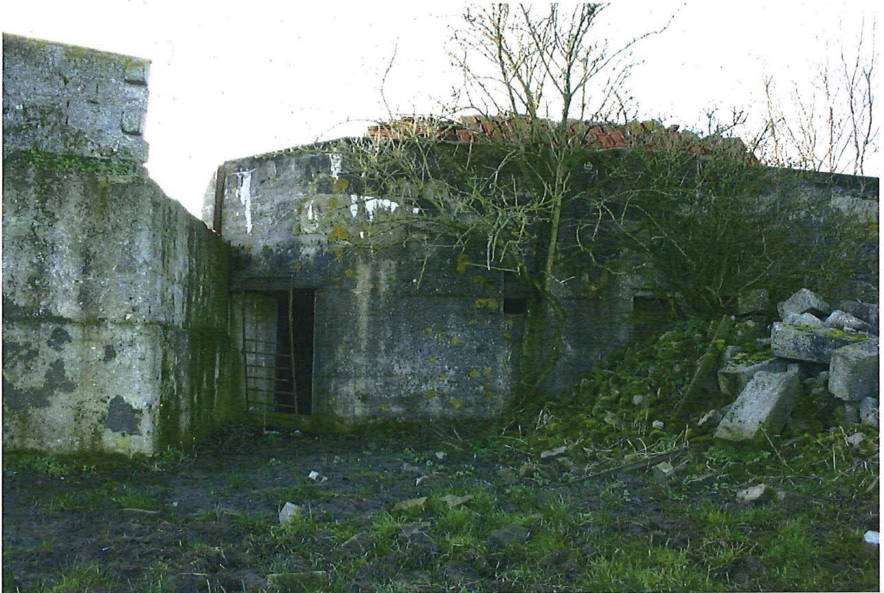
Foto 5: De noordelijke bunker
