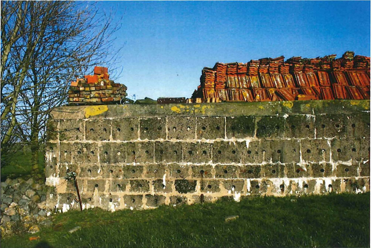
Foto 7: Betonstenen aan de westelijke zijde van de noordelijke bunker
