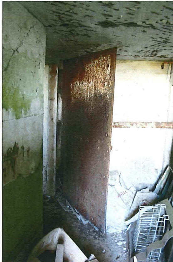
Foto 12: Stalen deur in bunker
