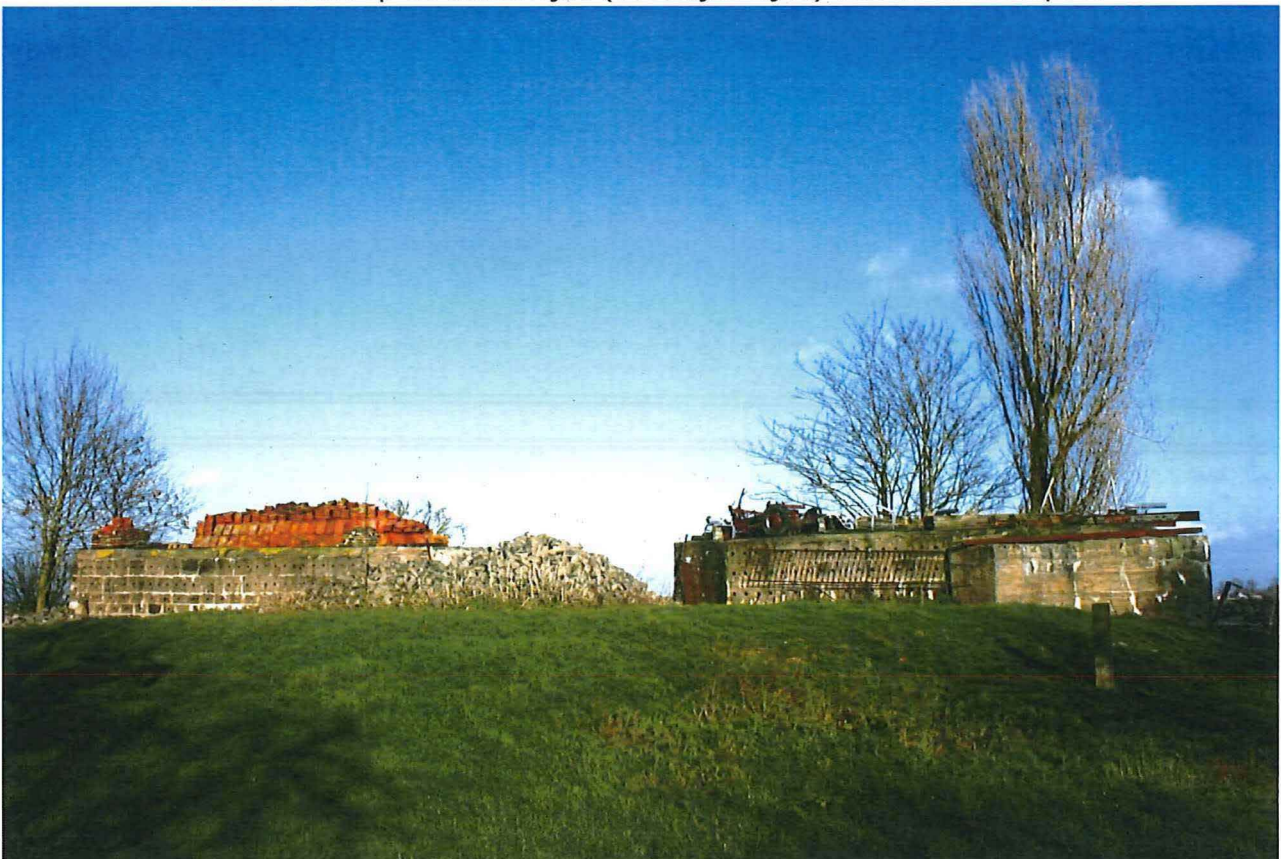
Foto 2: Zicht op de voorzijde (westelijke zijde) van de artilleriepost
