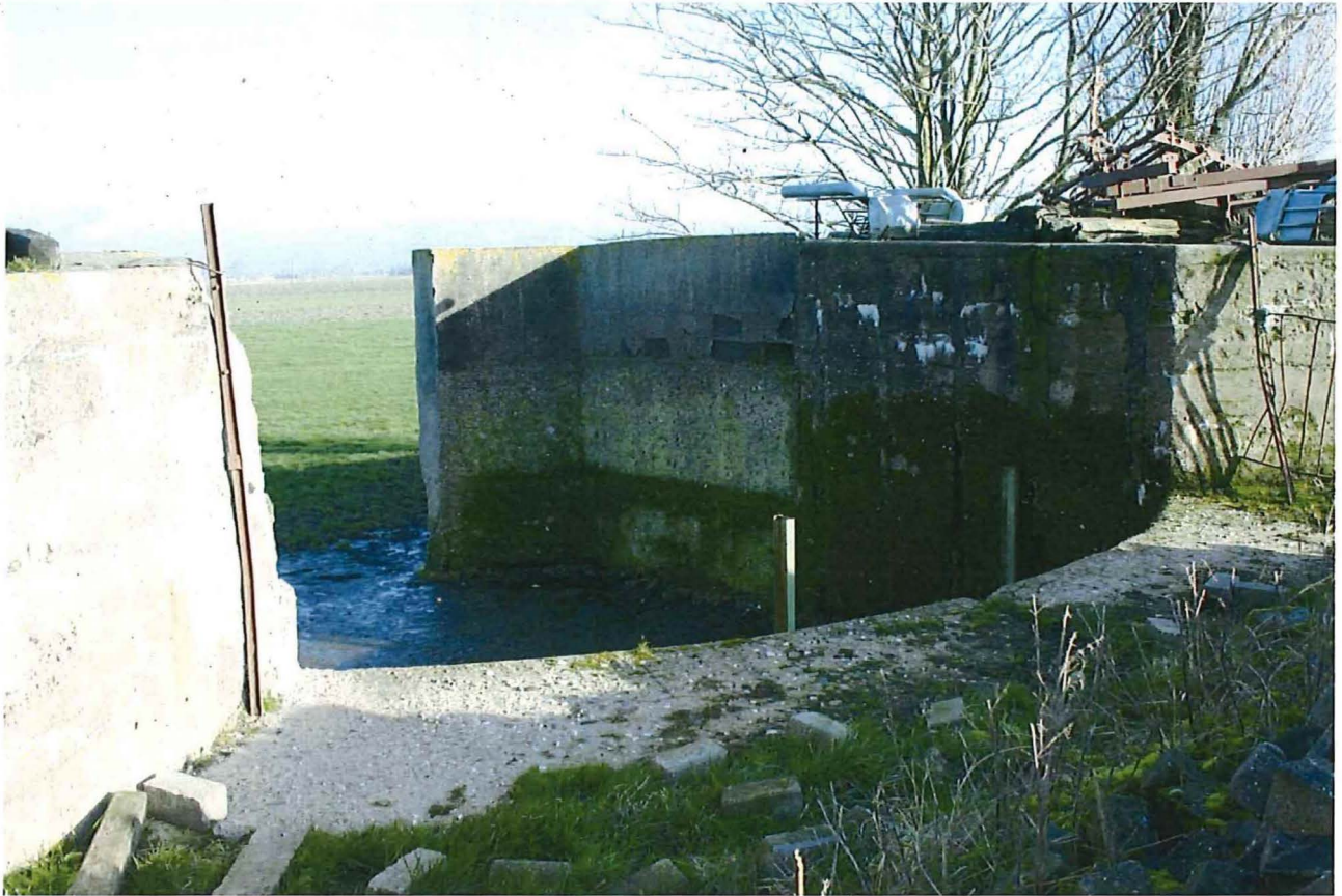
Foto 3: De betonnen geschutsbedding vanaf westelijke zijde
