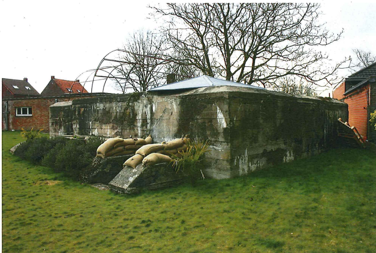
Foto 2: Zicht op de bunker vanaf noordelijke zijde.
