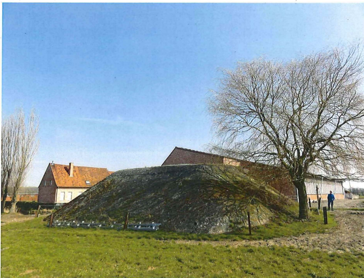
Foto 5: Zicht op de westelijke zijde van de bunker.
