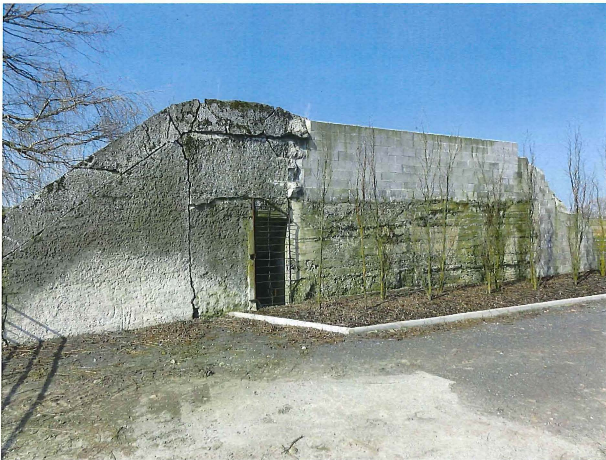
Foto 3: Zicht op de oostelijke zijde van de bunker. De hier zichtbare aankleding van de oostelijke zijde (met snelbouwstenen) is het resultaat van latere aanpassingen.
