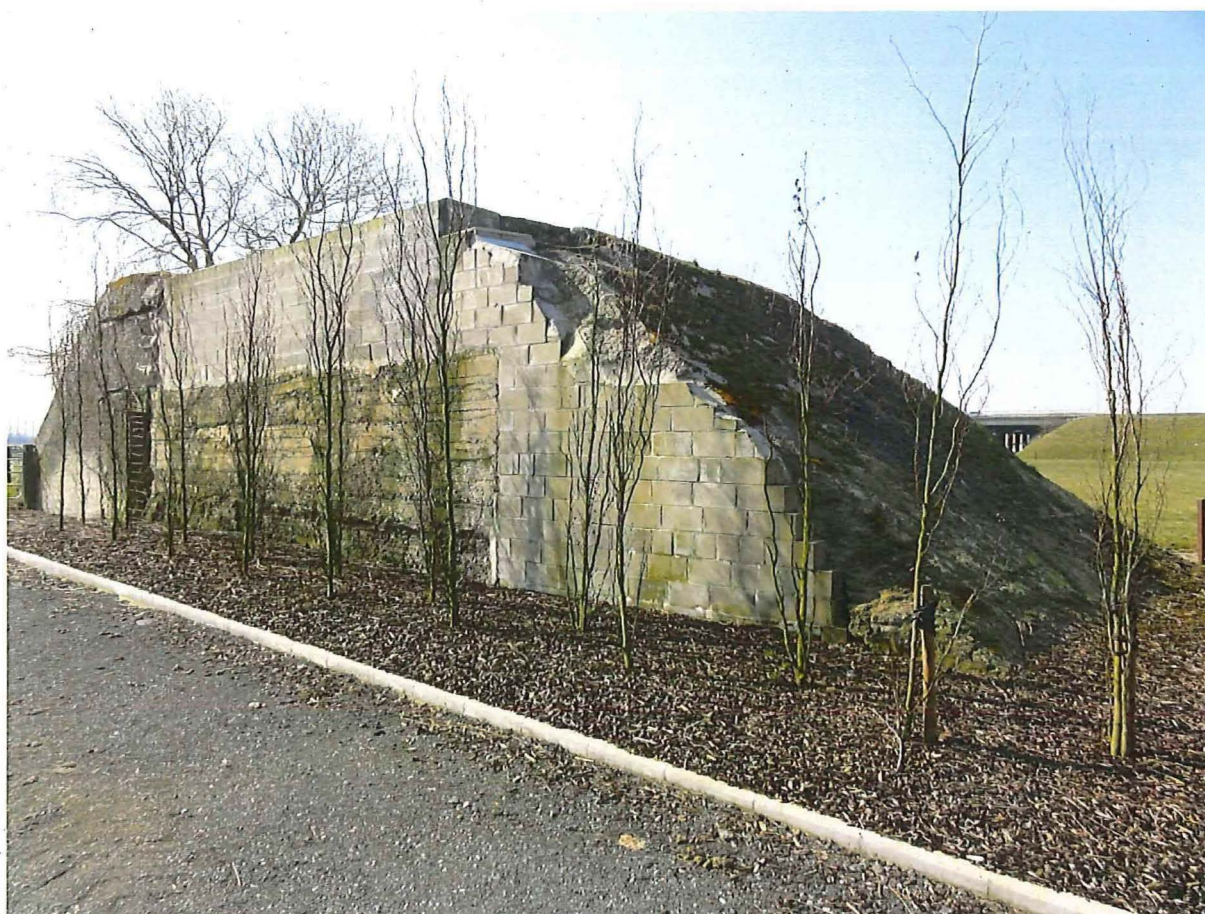
Foto 4: Zicht op de noordelijke en oostelijke zijde van de bunker.
