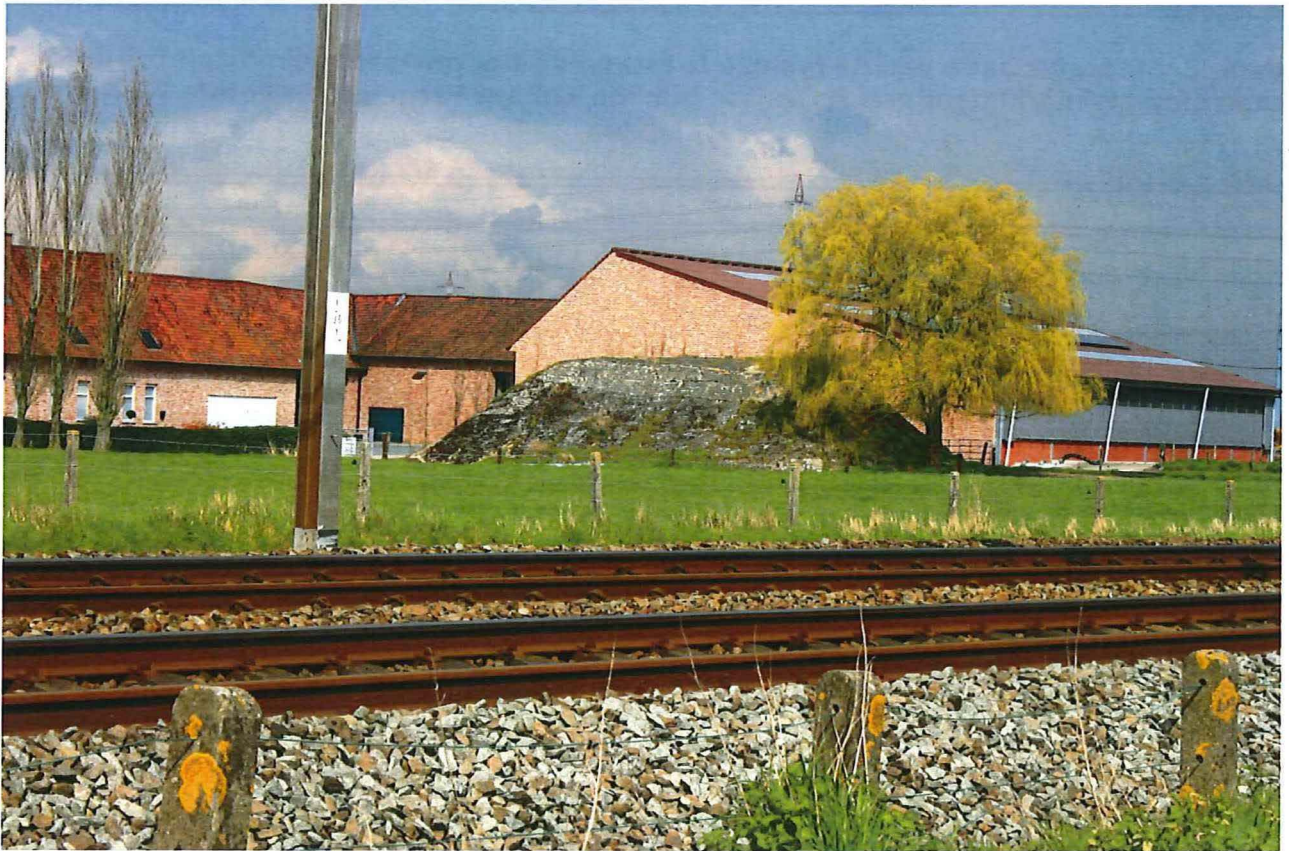
Foto 1: Zicht op de westelijke zijde van de Duitse bunker bij Limber Farm , vanaf de spoorlijn.
