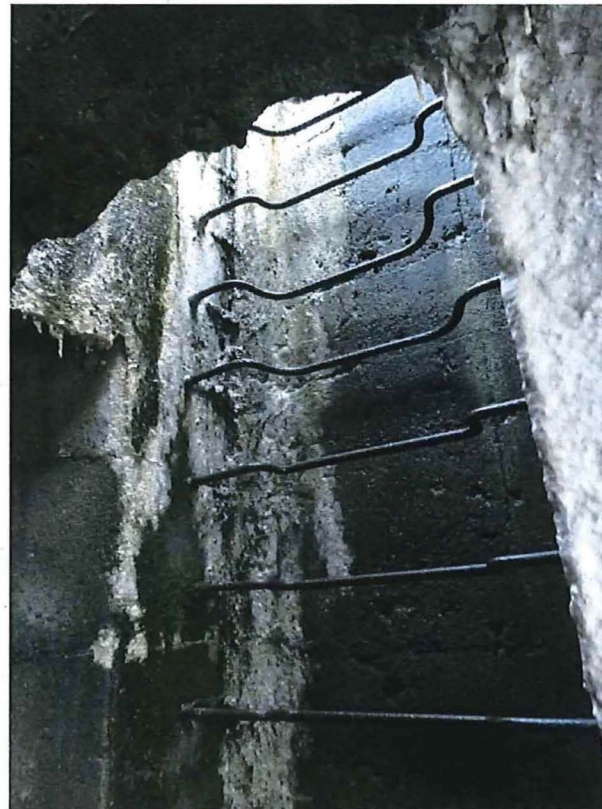
Foto 8: Het mangat met klimijzers.
