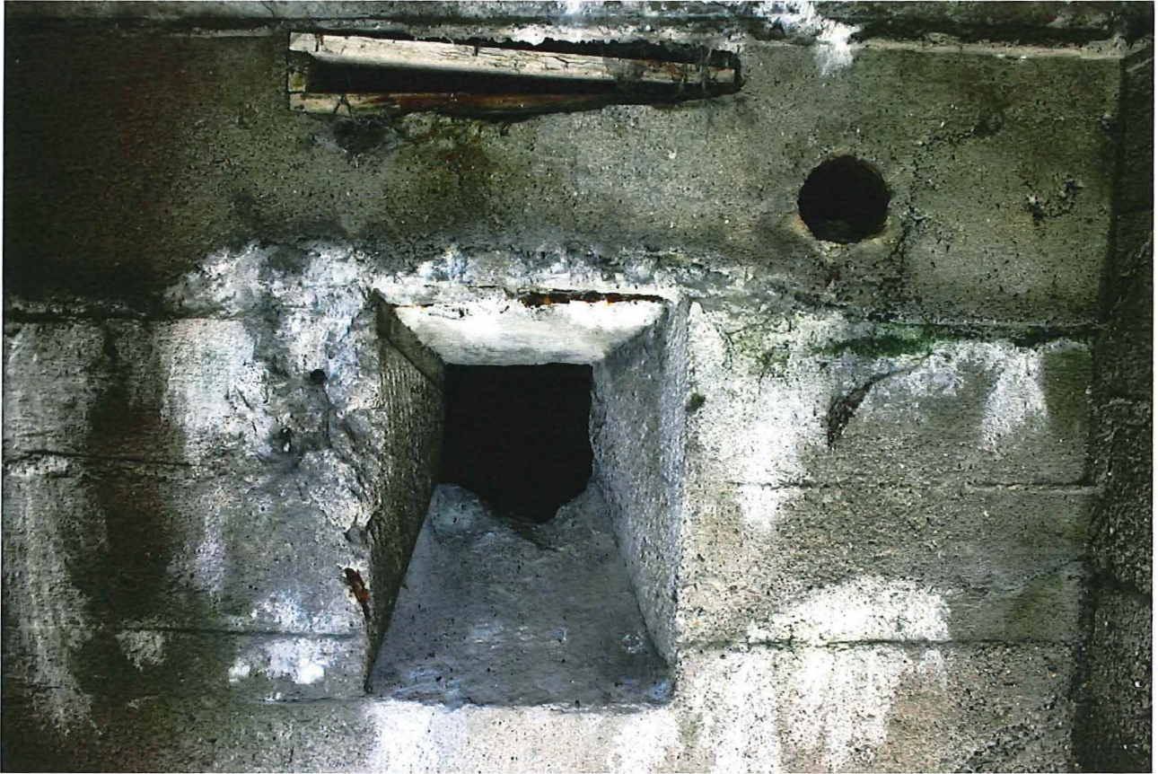
Foto 3: Een opening in de binnenmuur ter hoogte van de rechertoegang
