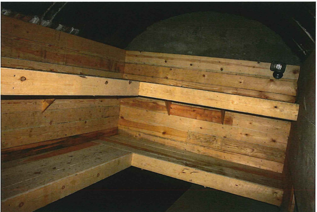
Foto 6: Een binnenruimte waarin recent een houten bekleding met britsen is opgetrokken.
